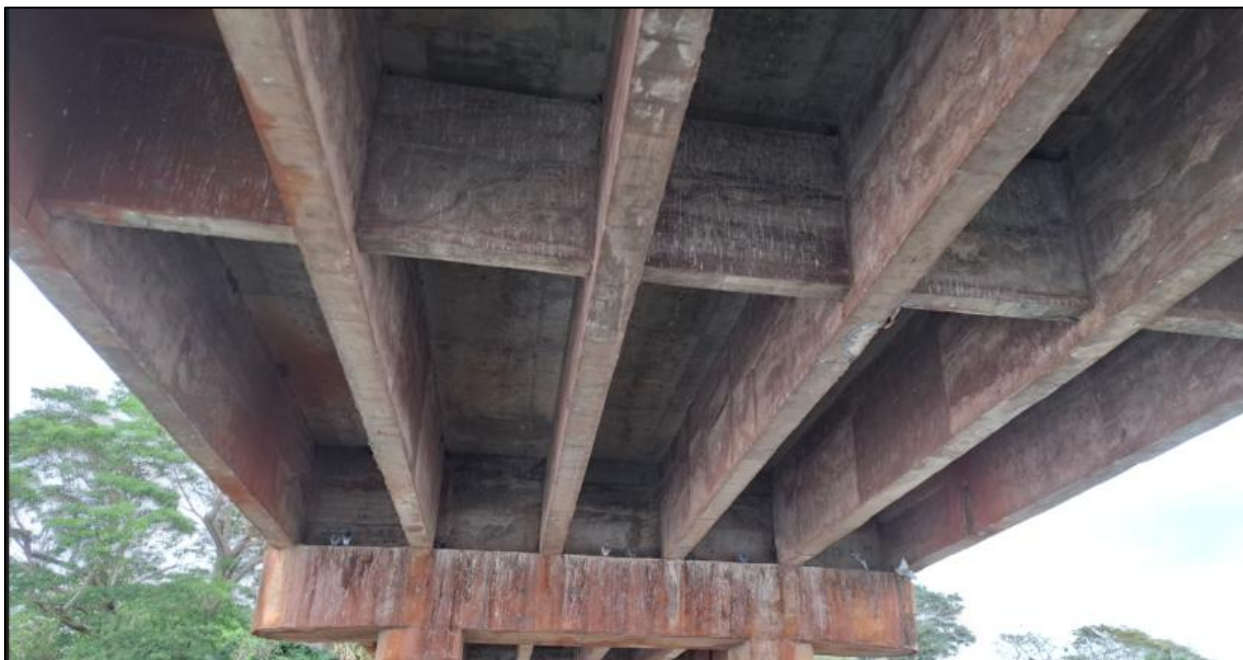
Figura 17 – Seção transversal executada no local
