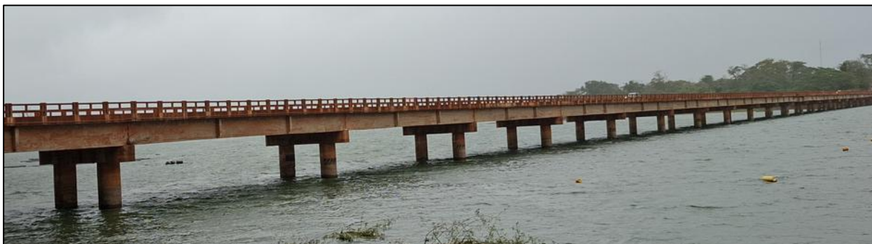
Figura 82 – Travessa existente diverge do memorial de cálculo original 2/2
