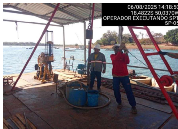
OPERADOR EXECUTANDO SPT
