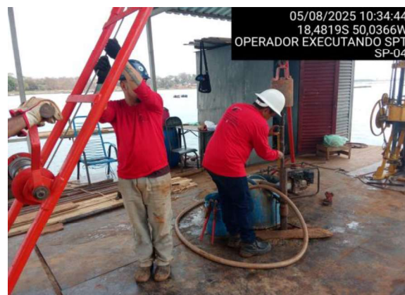
OPERADOR EXECUTANDO SPT
