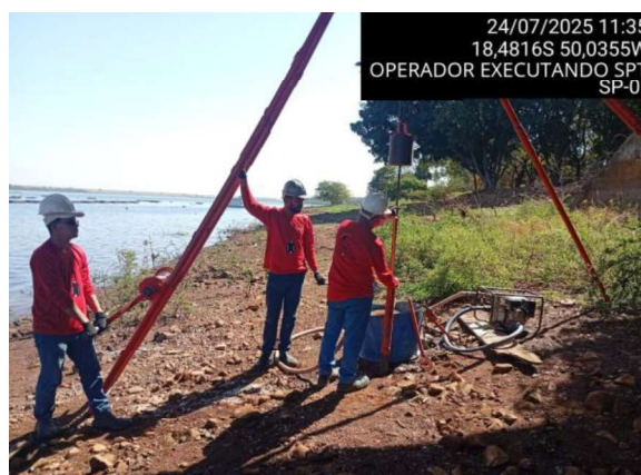
OPERADOR EXECUTANDO SPT
