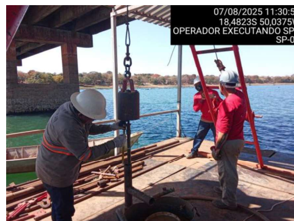
OPERADOR EXECUTANDO SPT
