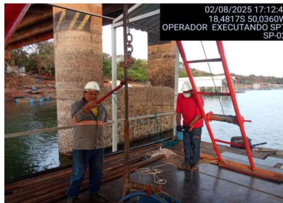
OPERADOR EXECUTANDO SPT
