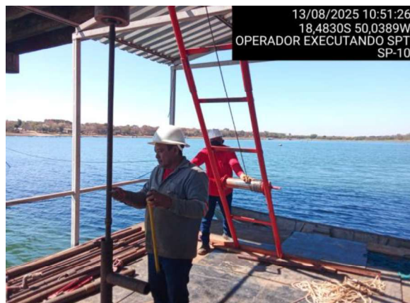
OPERADOR EXECUTANDO SPT
