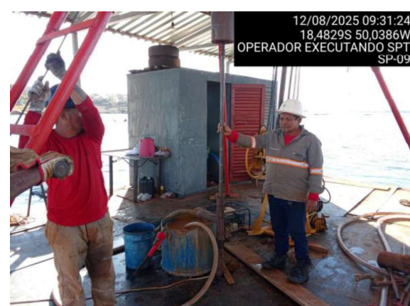
OPERADOR EXECUTANDO SPT
