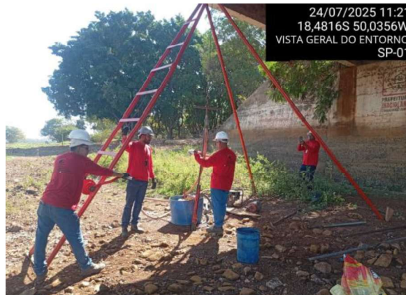
VISTA GERAL DO ENTORNO
