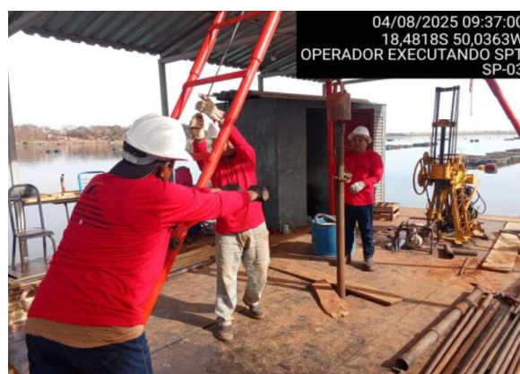
OPERADOR EXECUTANDO SPT
