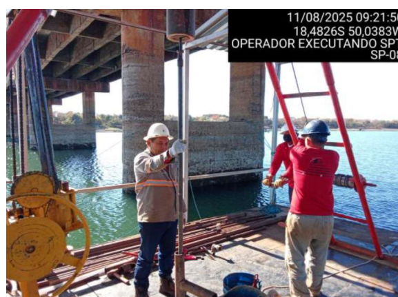
OPERADOR EXECUTANDO SPT
