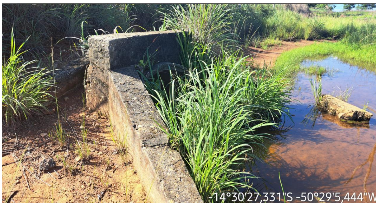
Km: 29,20 - Bueiro tubular.
