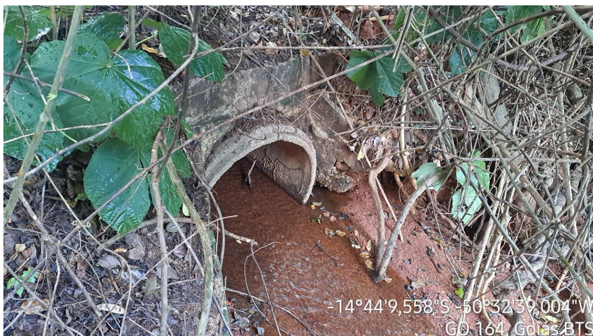
Km: 2,50 – Bueiro tubular.
