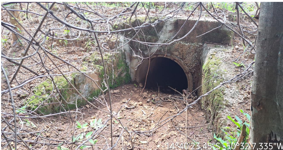
Km: 9,70 – Bueiro tubular.
