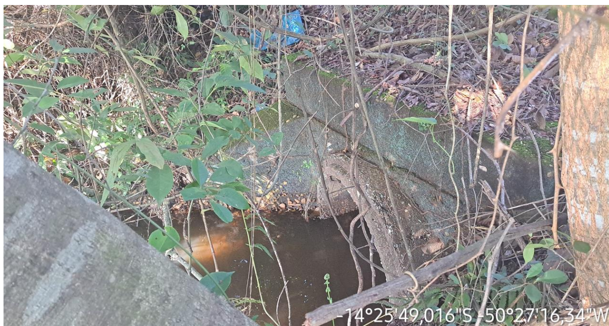
Km: 38,50 - Bueiro tubular.
