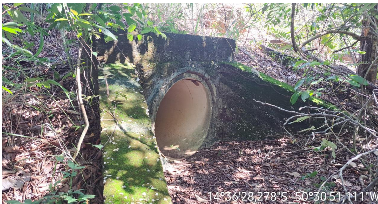
Km: 17,50 - Bueiro tubular.
