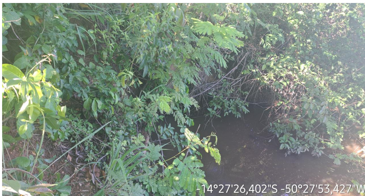
Km: 35,20 - Bueiro tubular.
