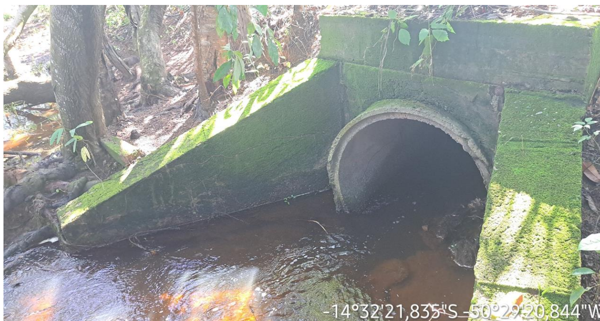
Km: 25,60 - Bueiro tubular.
