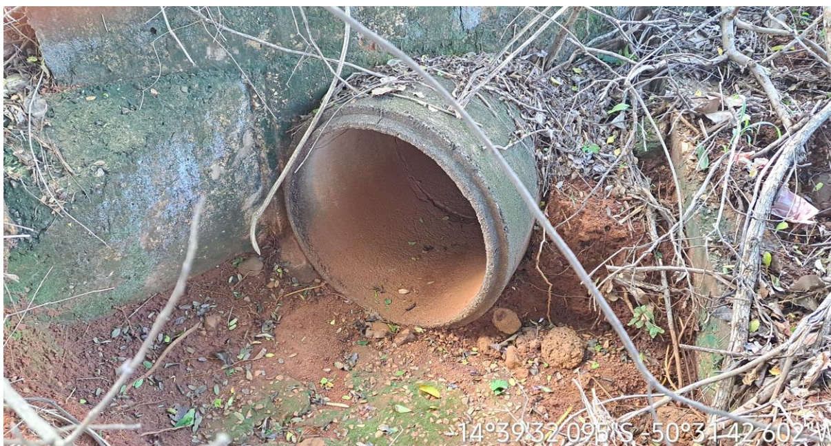
Km: 11,50 – Bueiro tubular.
