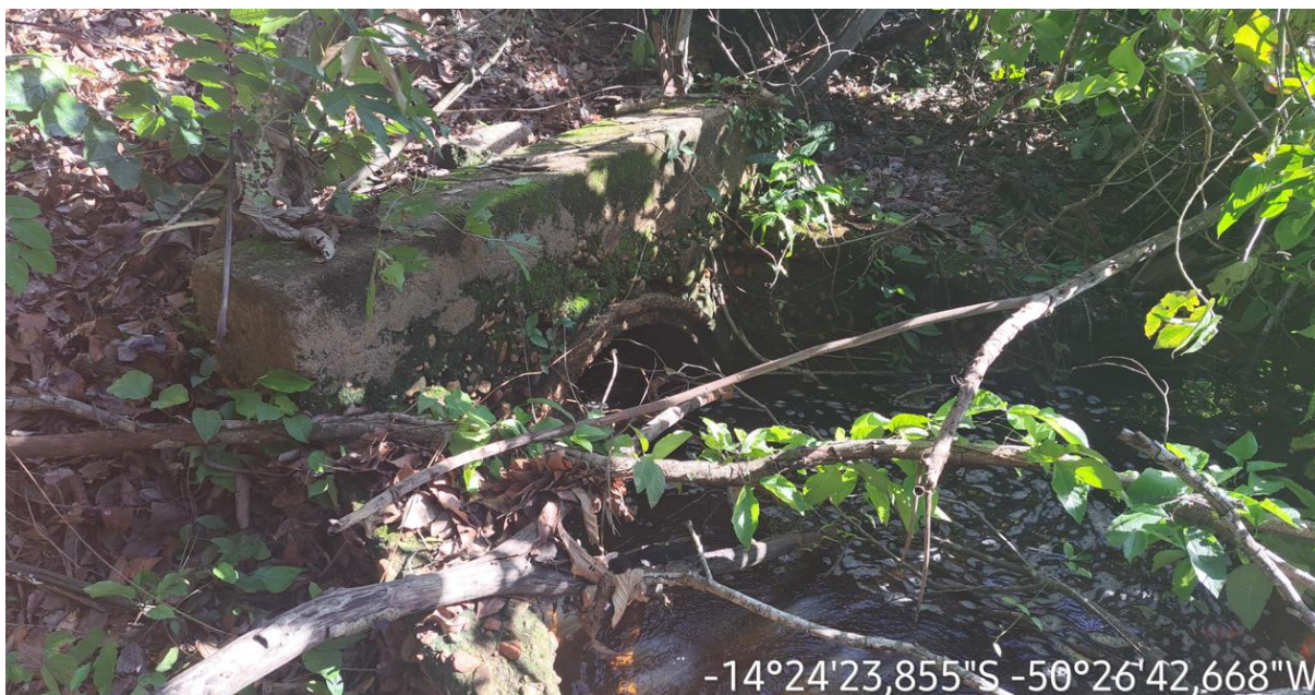
Km: 41,30 - Bueiro tubular.
