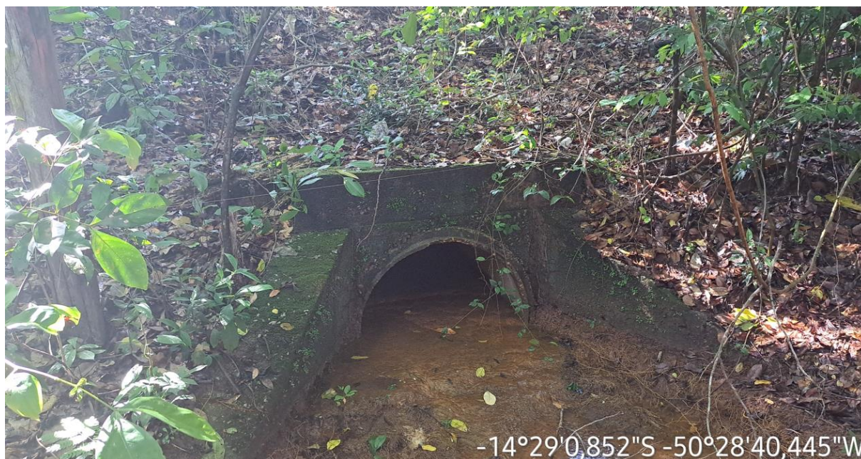
Km: 32,00 - Bueiro tubular.
