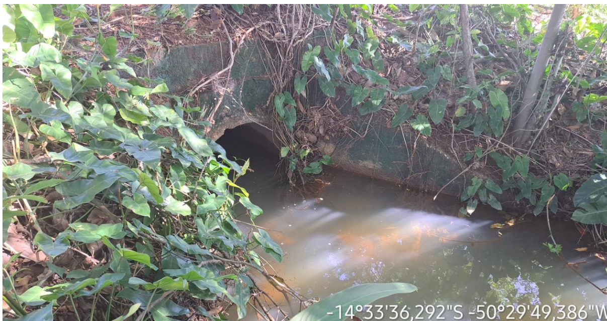
Km: 23,20 – Bueiro tubular.
