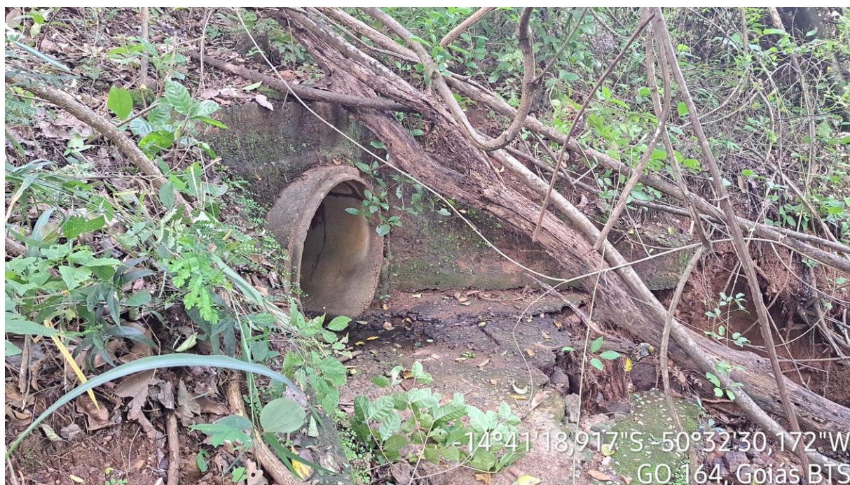
Km: 7,90 - Bueiro tubular.
