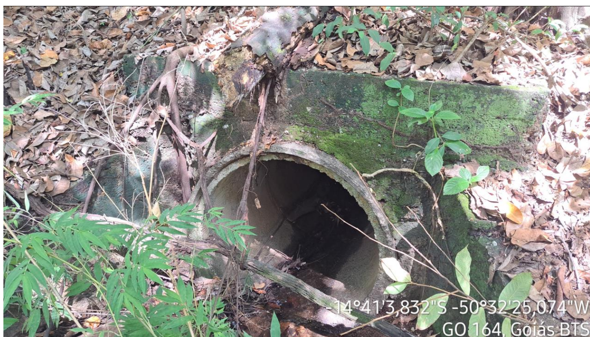
Km: 8,40 – Bueiro tubular.
