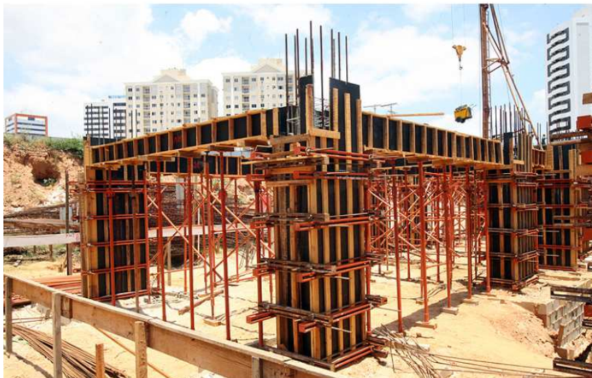
Figura 4 - Foto que mostra o sistema de escoramento e as formas explicitadas neste caderno ( fonte: cimento itambé)
