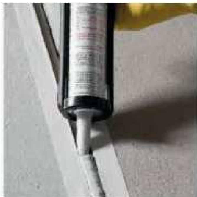
Figura 16 - Aplicação de Selante PU em Juntas de Movimentação
