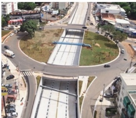
Contenções e Fundações de OAE
