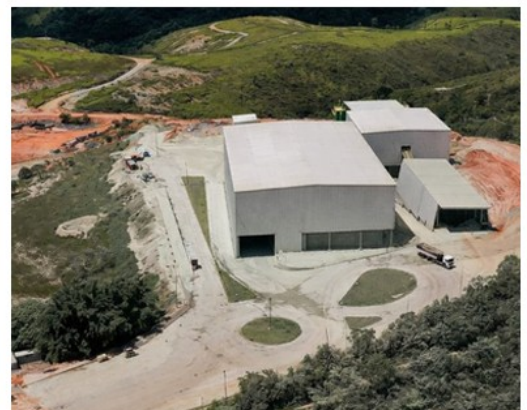
Fundações de obras Industriais
