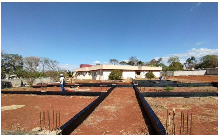
Figura 12 - Impermeabilização de baldrame com a correta aplicação da pintura asfáltica. (Fonte : Obra MP-GO Itumbiara 2023).
