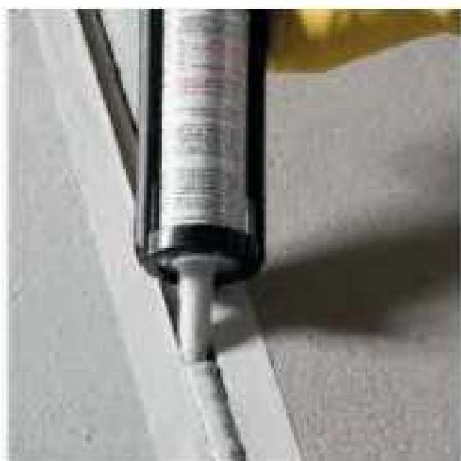
Figura 21 - Aplicação de Selante PU em Juntas de Movimentação
