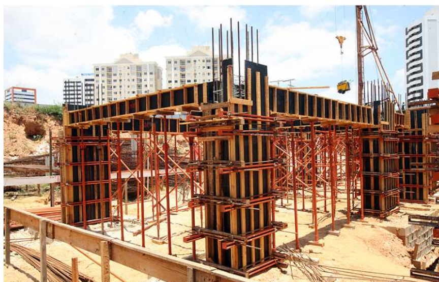
Figura 7 - Foto que mostra o sistema de escoramento e as formas explicitadas neste caderno ( fonte: cimento itambé)
