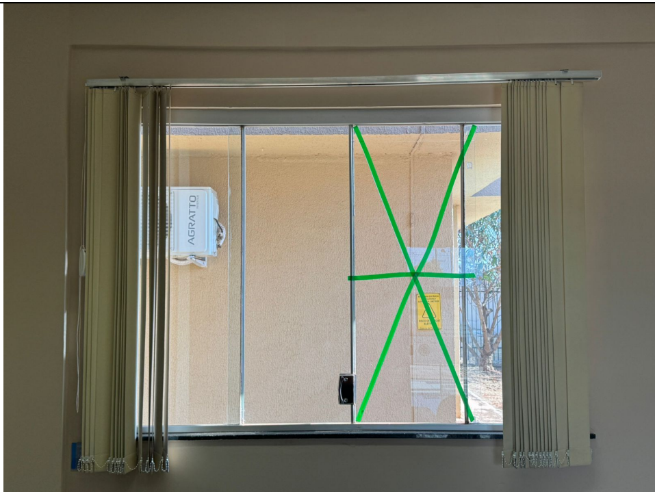
Figura 1 - Folha de vidro estourada na Sede das Promotorias de Justiça de Bom Jesus de Goiás/GO
