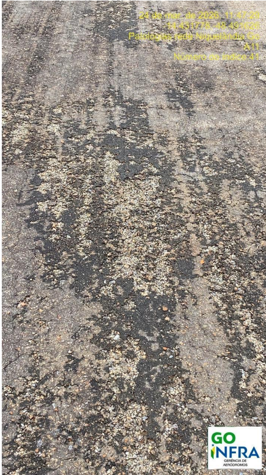
FOTO 3.: Desagregação Alta
