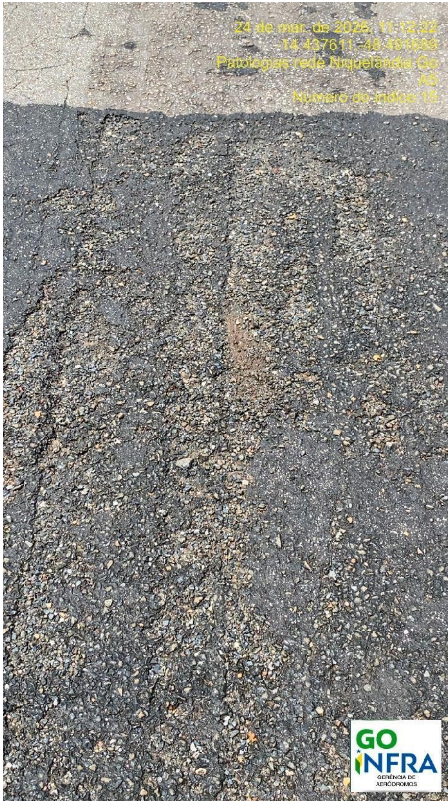
FOTO 2.: Desagregação Alta
