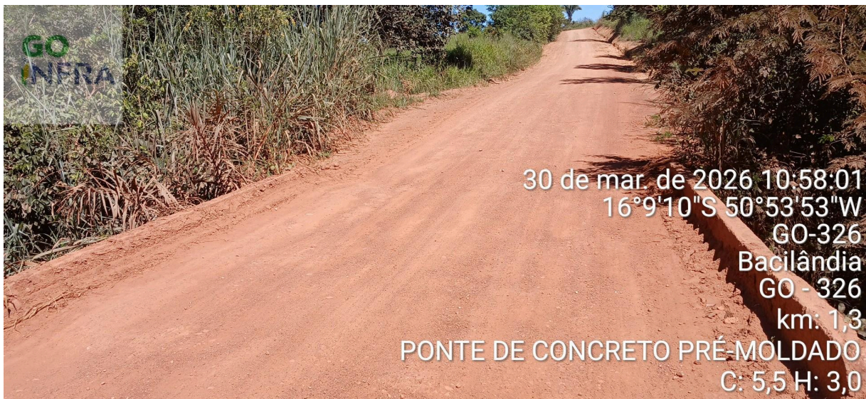
Km 1,3 – Ponte de Concreto Pré-Moldado C:5,5m H: 3,00m
