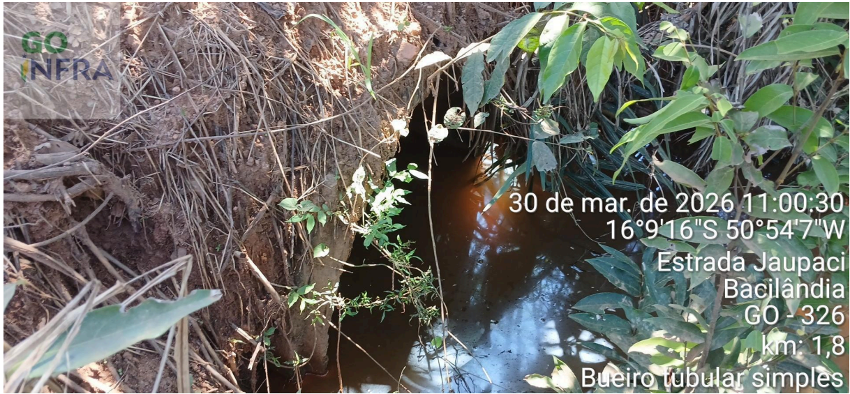
Km 1,8 — Bueiro Tubular Simples
