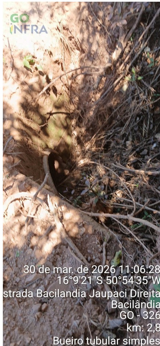
Km 2,8 — Bueiro Tubular Simples
