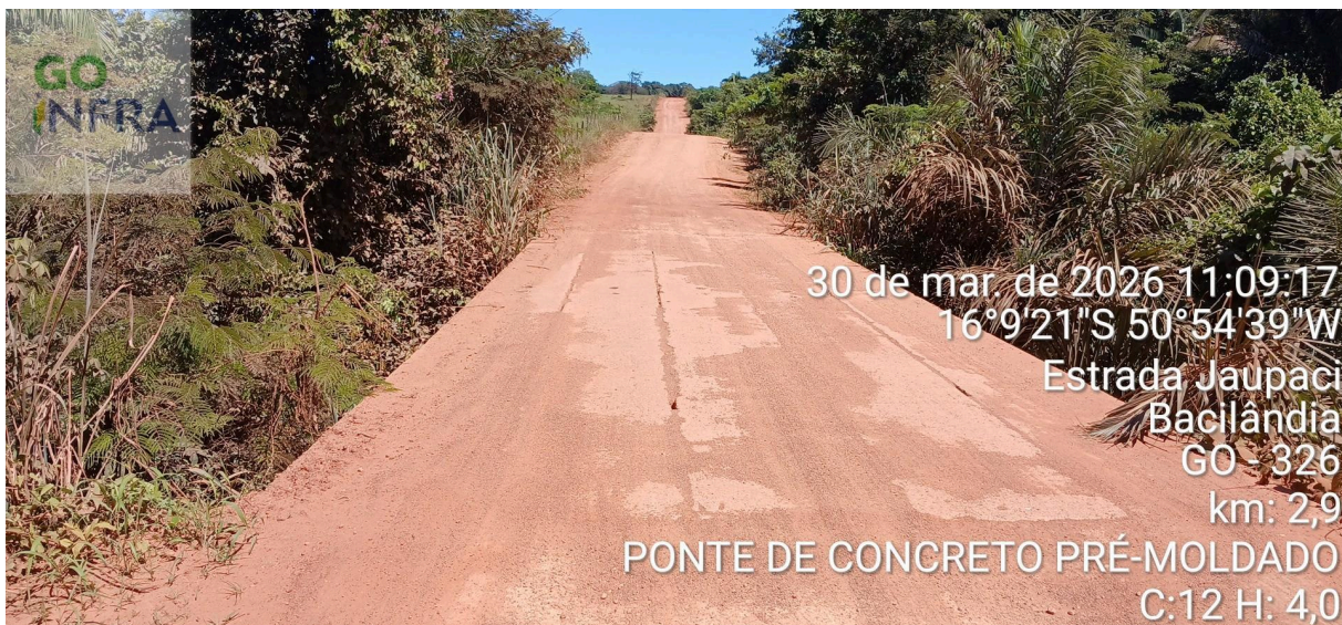
Km 2,9 — Ponte de Concreto Pré-Moldado C:12,00, H:4,00m
