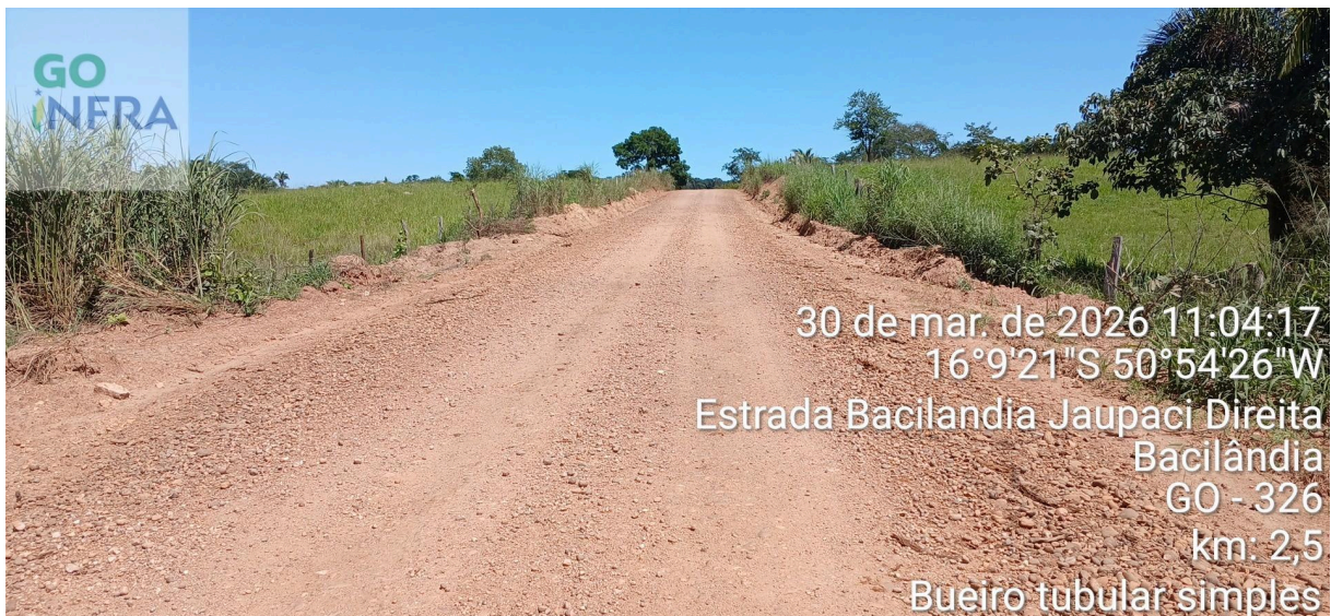
Km 2,5 — Bueiro Tubular Simples
