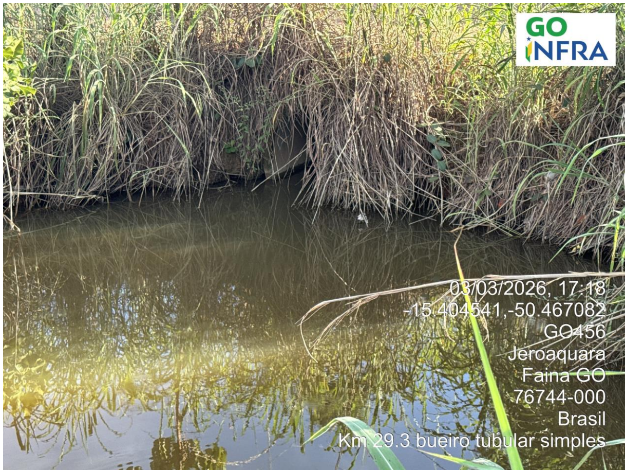
Km 29,3 – Bueiro Tubular Simples
