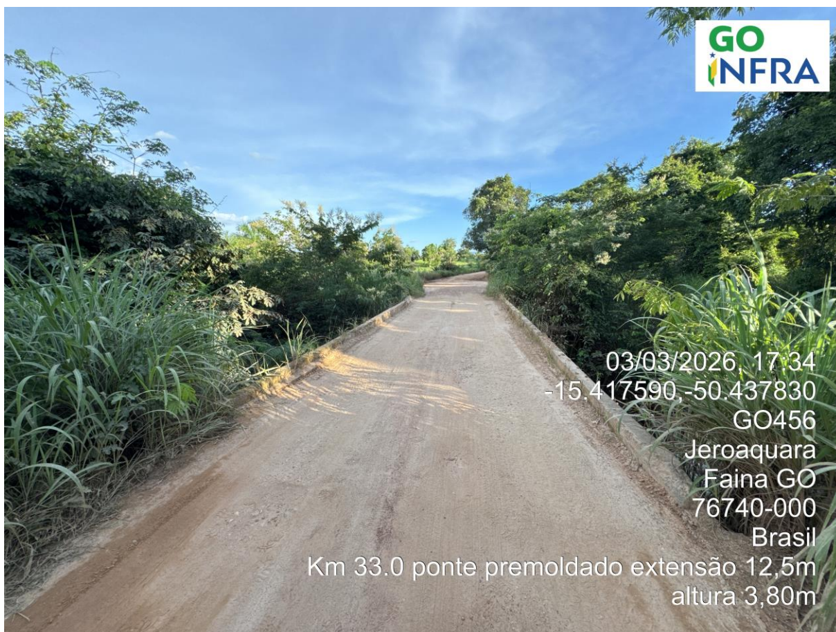
Km 33,0 – Ponte de Concreto Pré-Moldado C: 12,5m H: 3,8m
