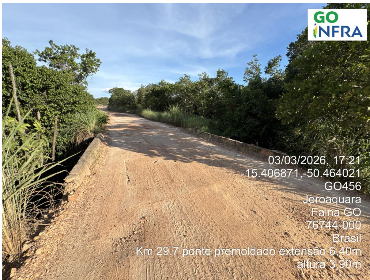
Km 29,7 – Ponte de Concreto Pré-Moldado C:6,4m H : 3,9m
