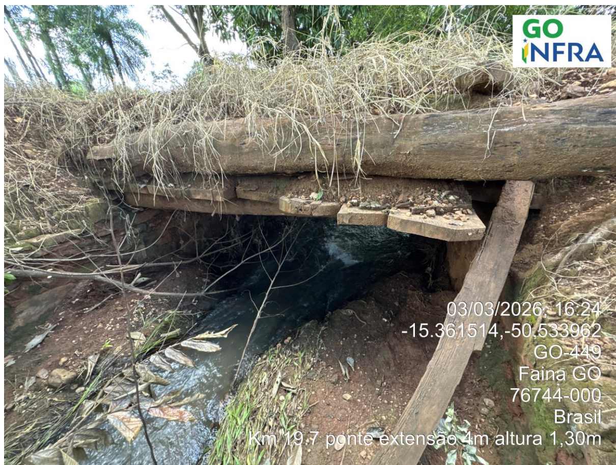
Km 19,7– Ponte de Madeira C:4m H:1,3m
