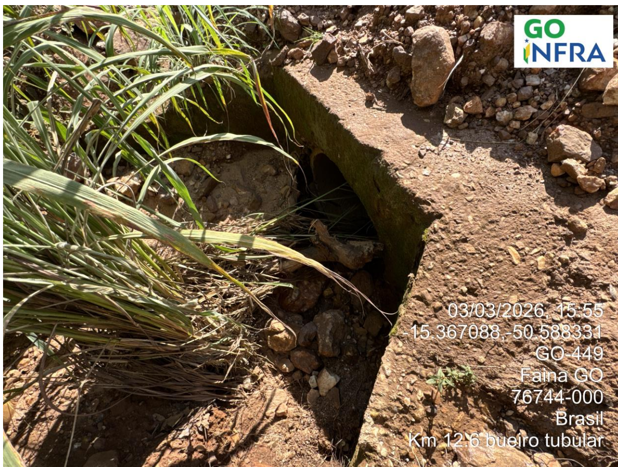
Km 12,6 — Bueiro Tubular Simples
