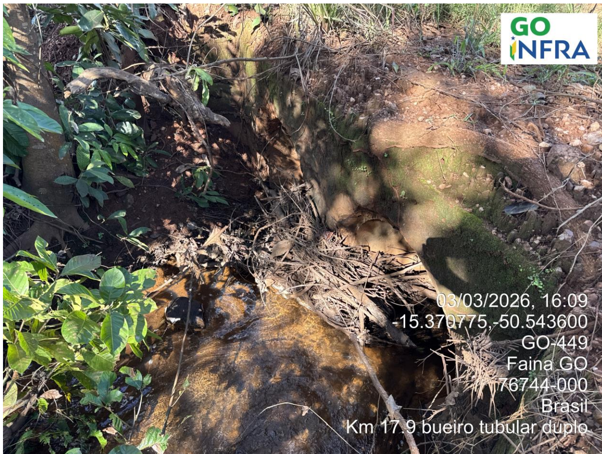
Km 17,9 – Bueiro Tubular Duplo
