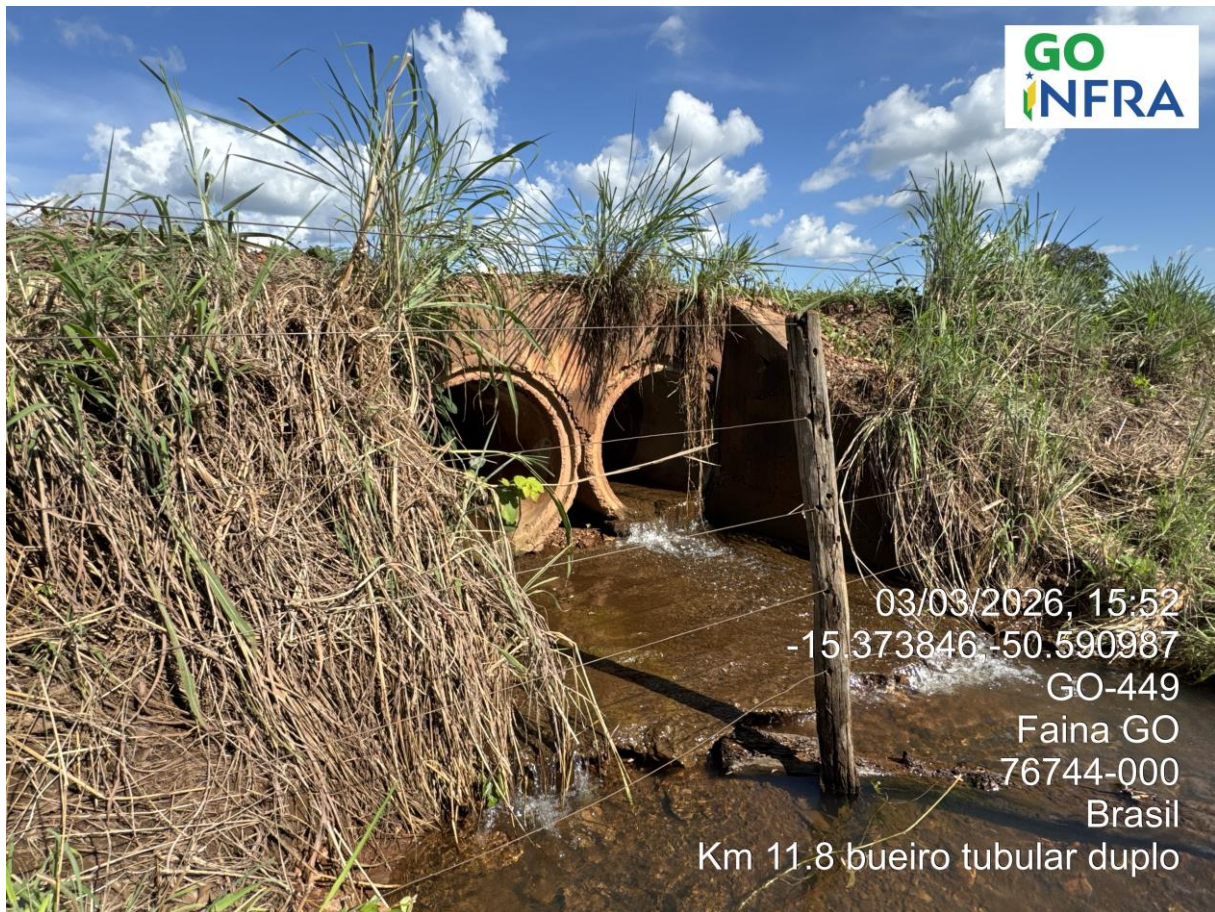
Km 11,8 – Bueiro Tubular Duplo
