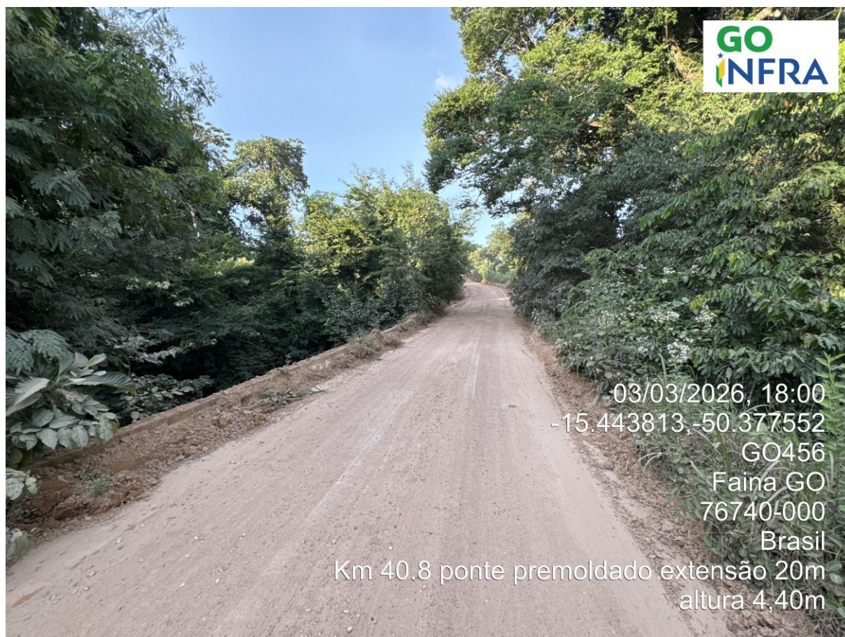
Km 40,8 – Ponte de Concreto Pré-Moldado C:20,0m H:4,40m
