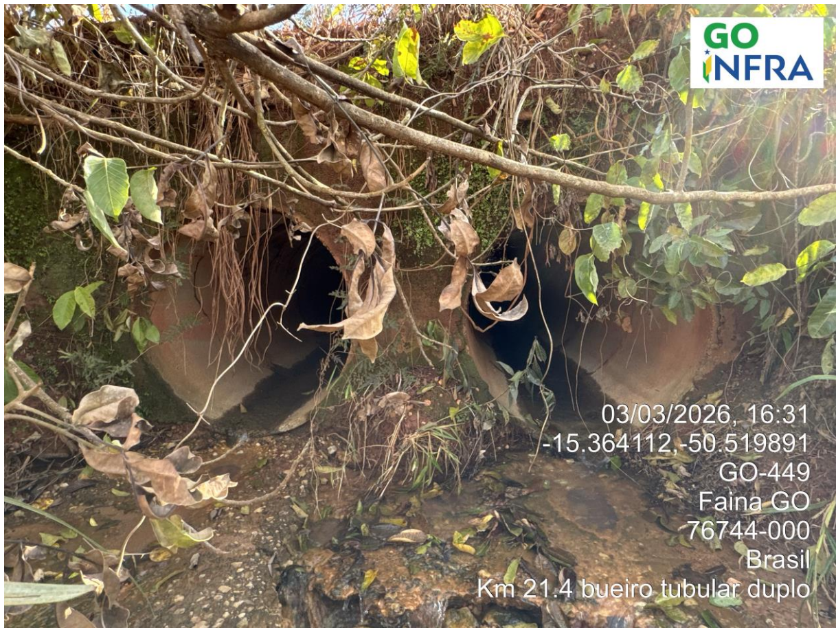
Km 21,4 – Bueiro Tubular Duplo
