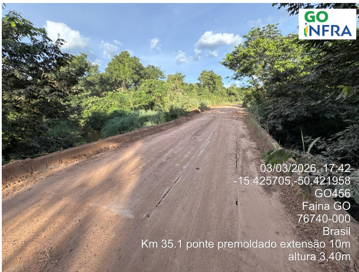
Km 35,1 – Ponte de Concreto Pré-Moldado C:10,0m H: 3,40m
