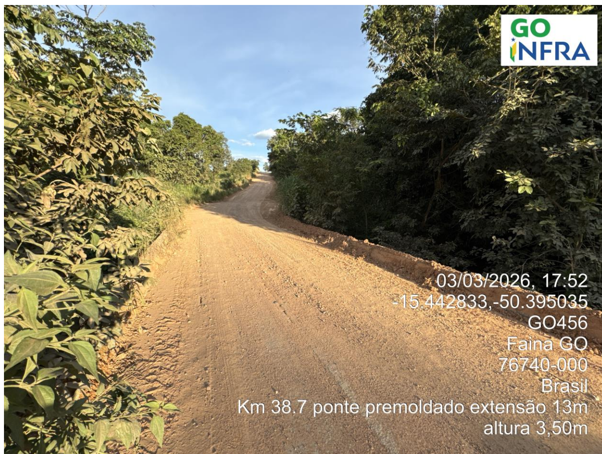
Km 38,7 – Ponte de Concreto Pré-Moldado C:13,0m H: 3,50m
