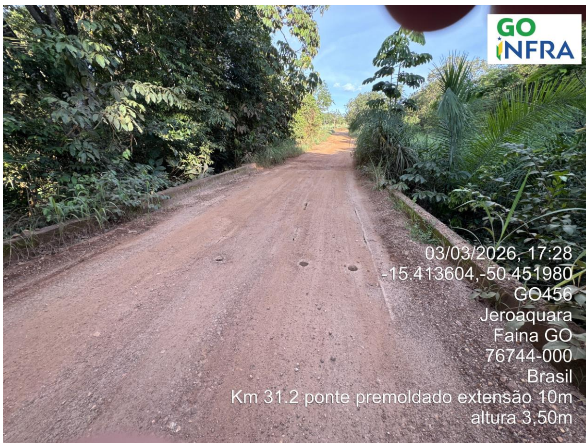
Km 31,2 – Ponte de Concreto Pré-Moldado C: 10,0m H: 3,5m
