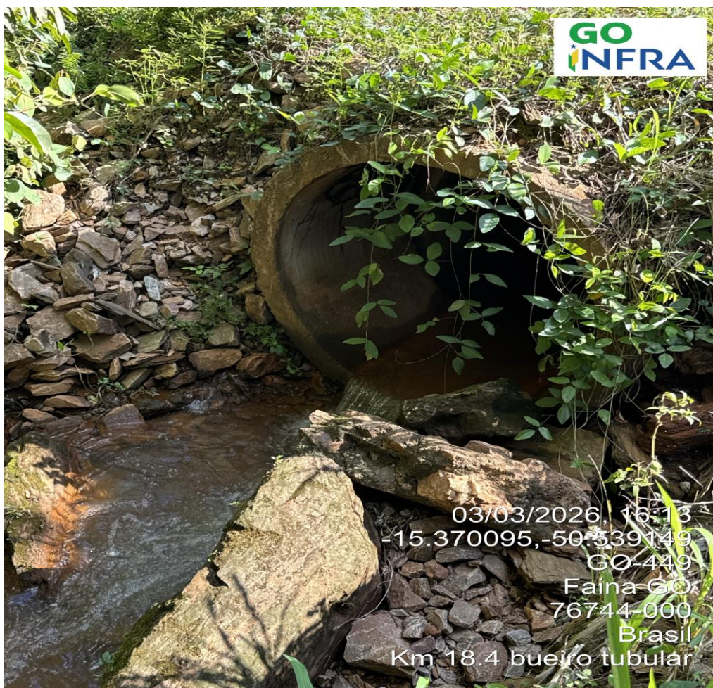
Km 18,4– Bueiro Tubular Simples
