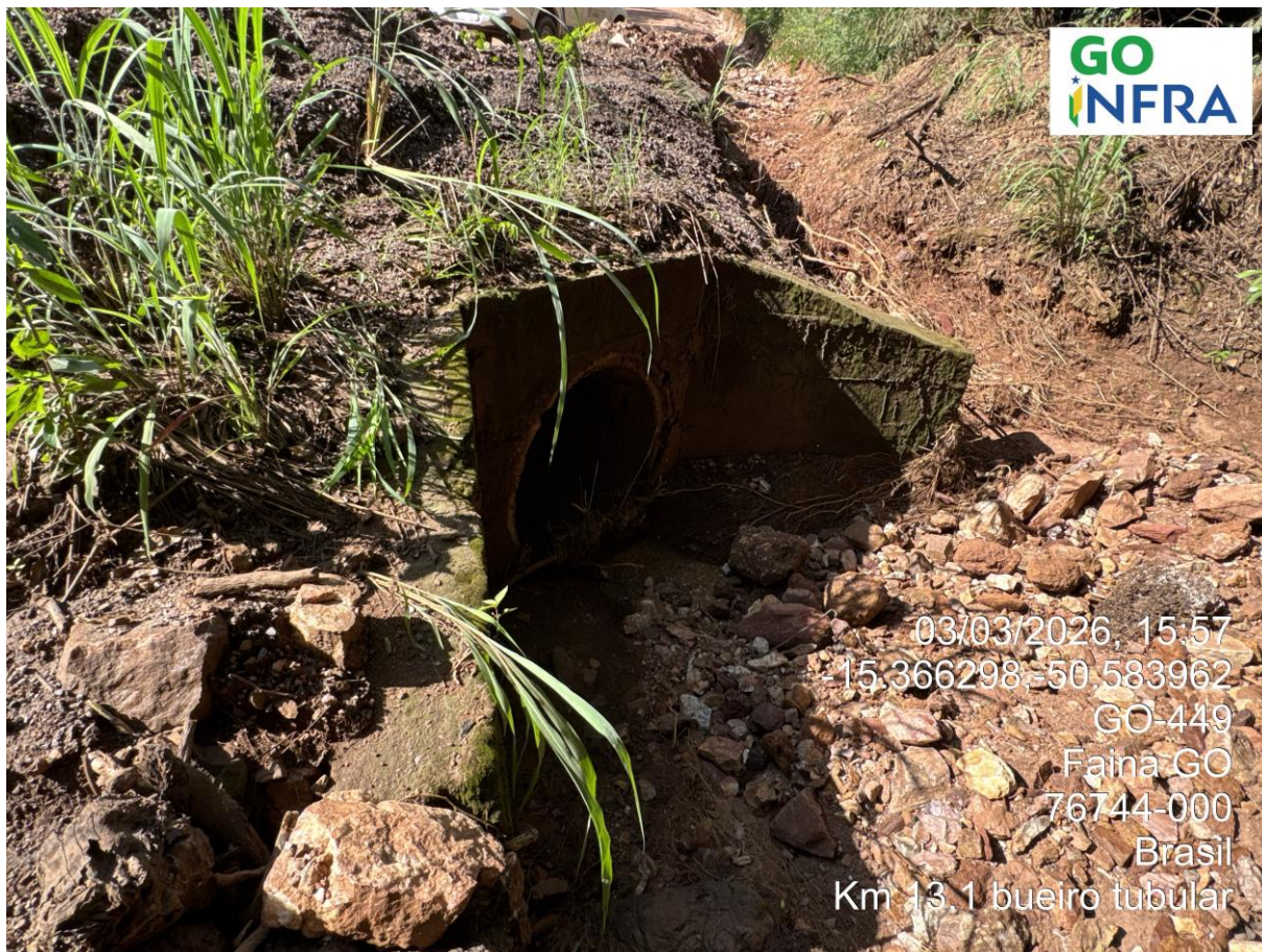
Km 13,1 – Bueiro Tubular Simples
