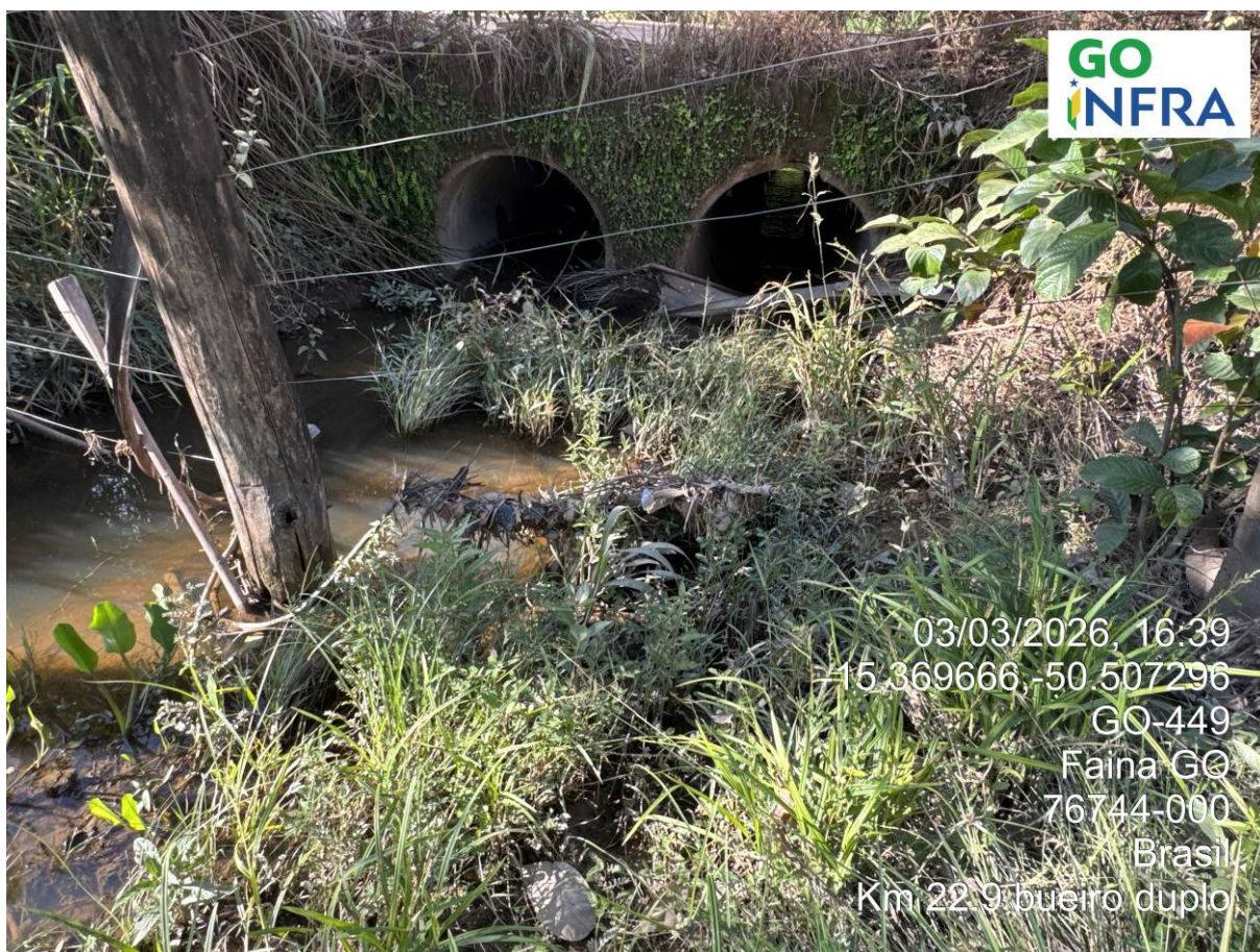
Km 22,9 – Bueiro Tubular Duplo
