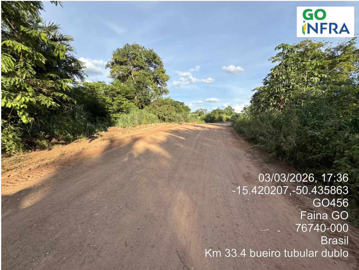
Km 33,4 – Bueiro Tubular Duplo
