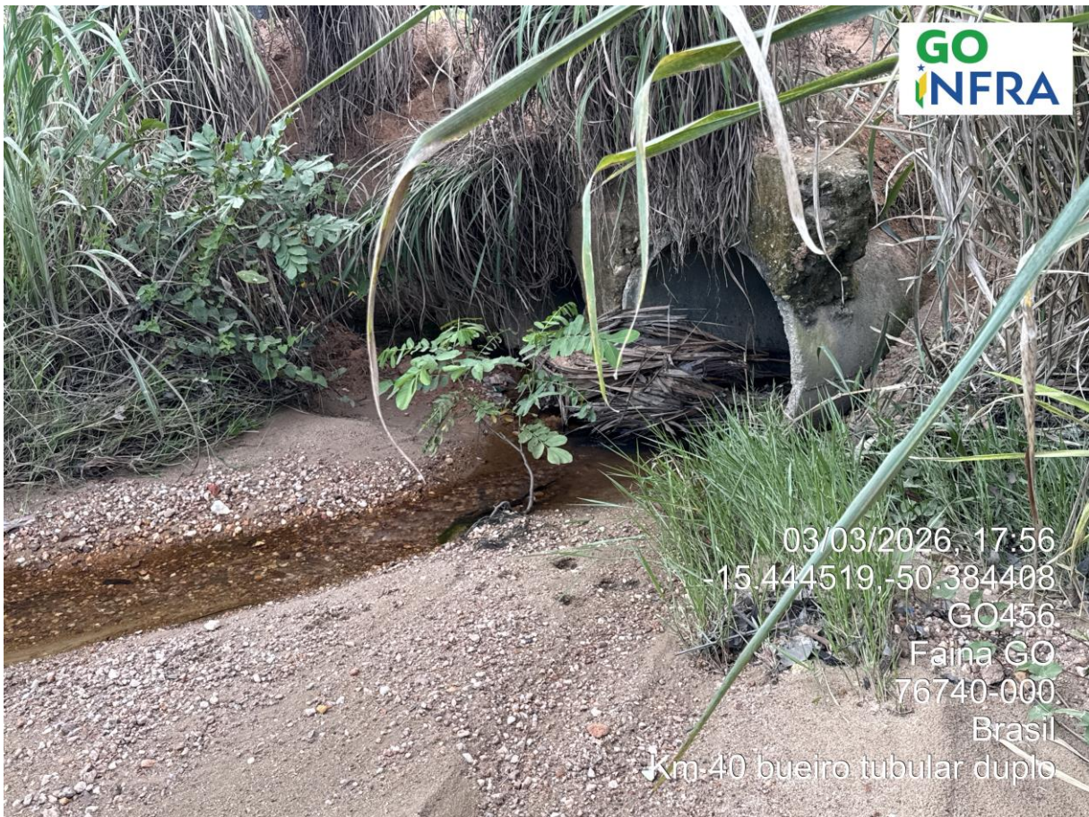
Km 40,0 – Bueiro Tubular Duplo
