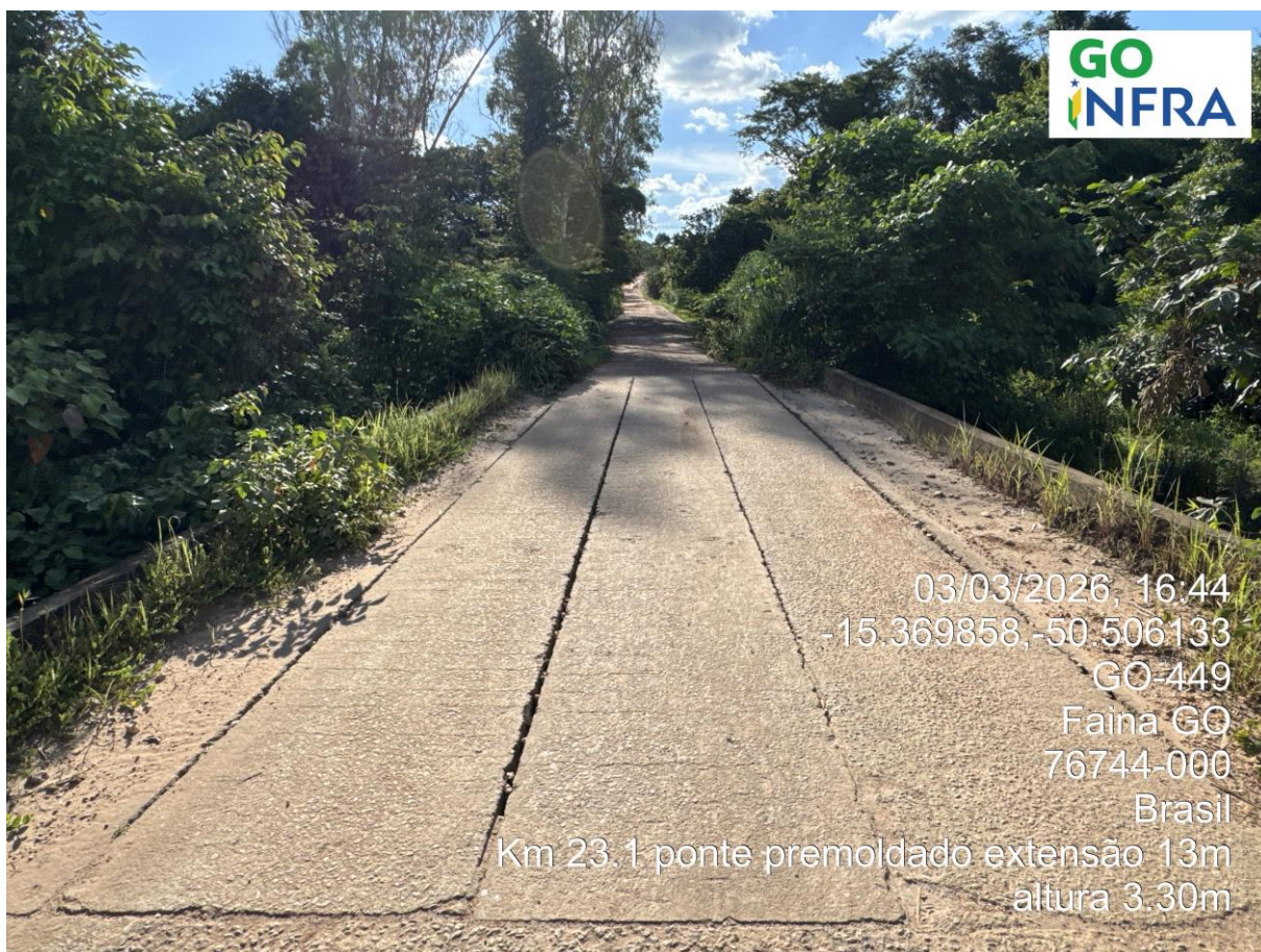
Km 23,1 – Ponte de Concreto Pré-Moldado C:13,0m H: 3,30m
