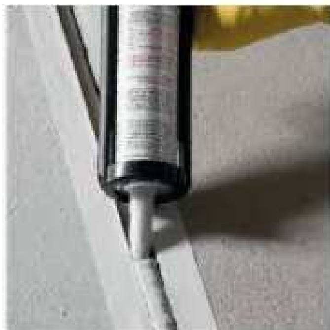
Figura 13 - Aplicação de Selante PU em Juntas de Movimentação
