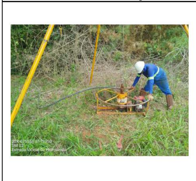
Foto 03 - Vista do local da sondagem
