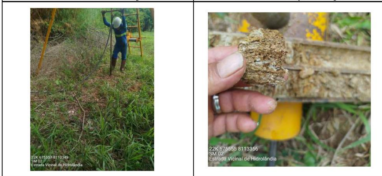
Foto 03 - Vista do local da sondagem
