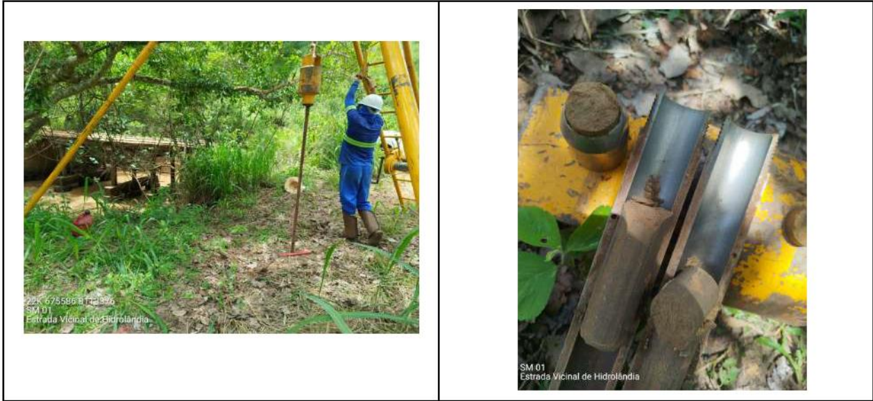
Foto 01 - Vista do local da sondagem
