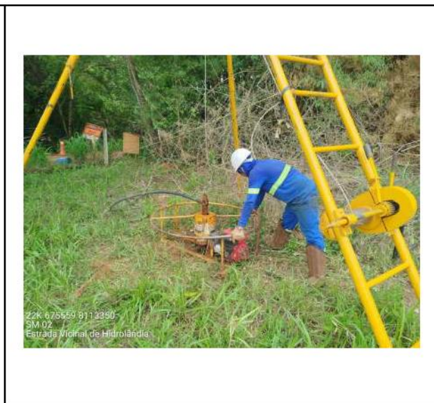
Foto 02 - Vista da execução da sondagem
