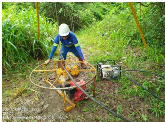
Foto 03 - Vista do local da sondagem
