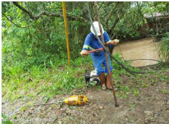
Foto 01 - Vista do local da sondagem
