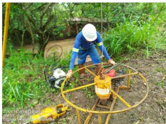
Foto 02 - Vista da execução da sondagem
