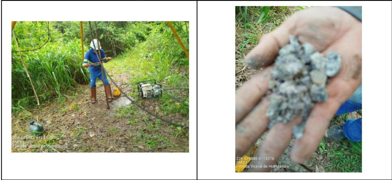
Foto 03 - Vista do local da sondagem
