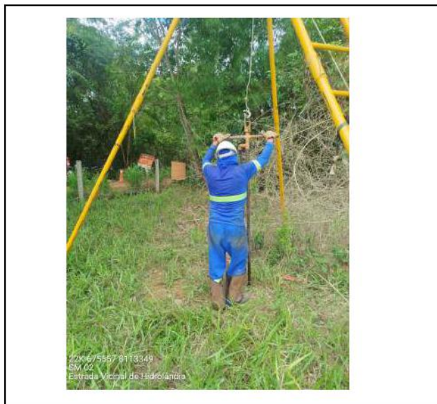
Foto 01 - Vista do local da sondagem
