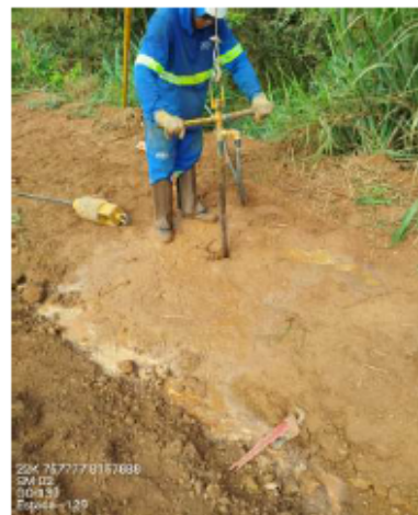
Foto 04 - Vista da execução da sondagem
