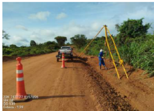
Foto 02 - Vista da execução da sondagem
