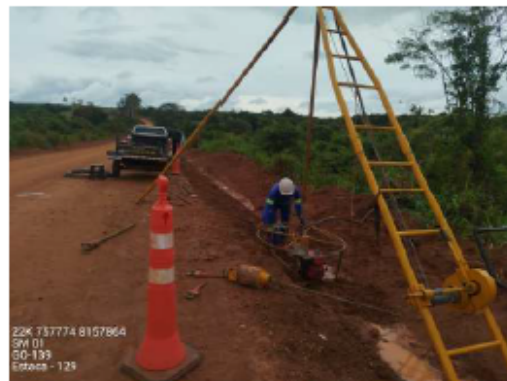
Foto 02 - Vista da execução da sondagem
