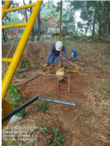
Foto 01 - Vista do local da sondagem
