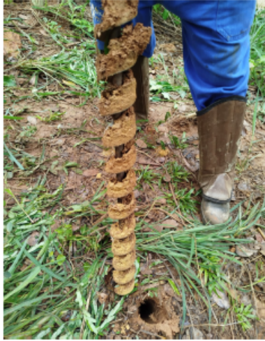
Foto 01 - Vista do local da sondagem
