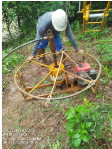
Foto 03 - Vista do local da sondagem
