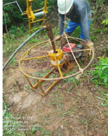
Foto 02 - Vista da execução da sondagem
