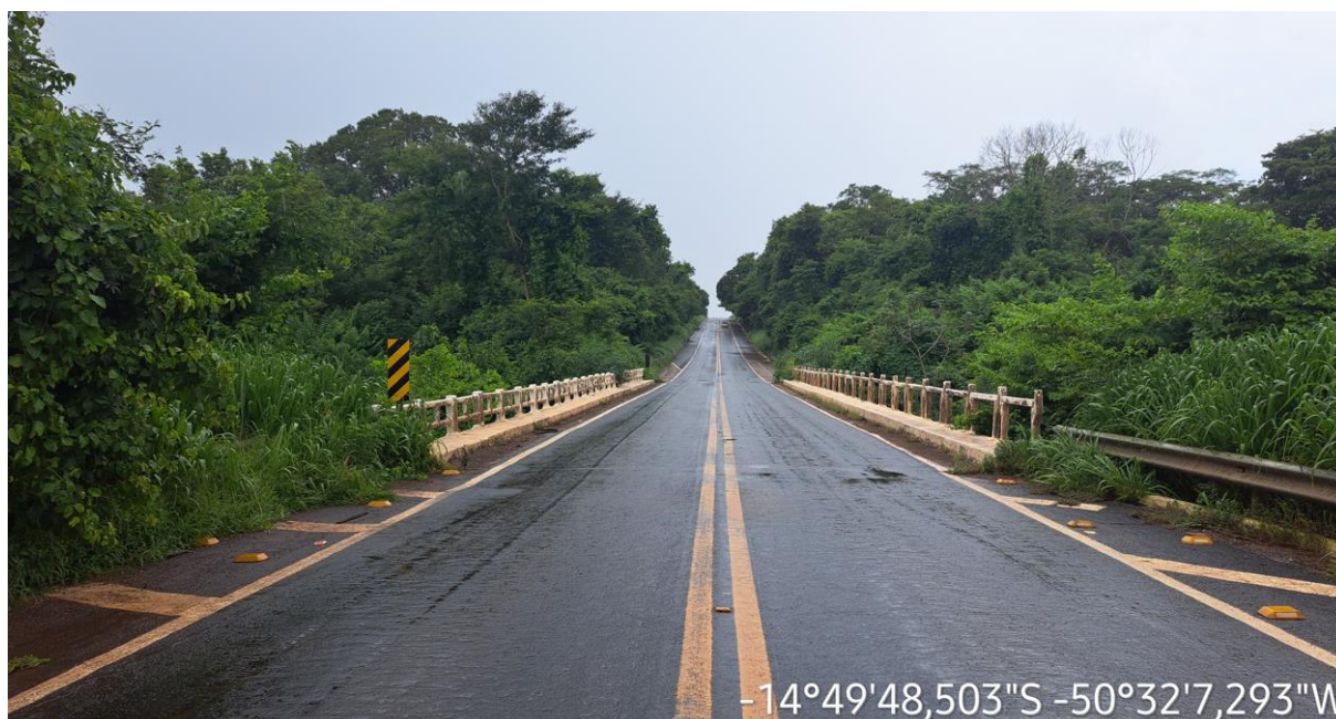
Km: 33,20 - Ponte em Concreto Armado.
