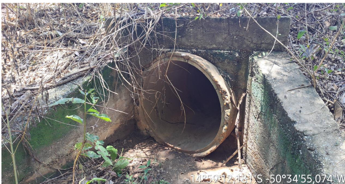
Km: 13,70 - Bueiro tubular.
