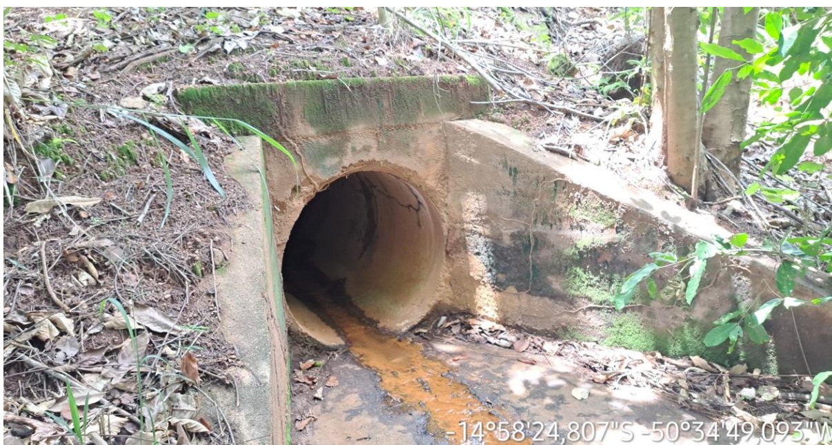
Km: 15,20 - Bueiro tubular.
