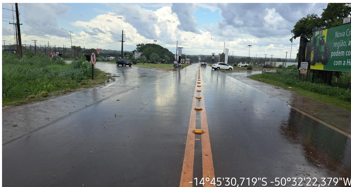
Km: 41,40 - GO-164 – Entroncamento GO-334, Entroncamento GO-347.
