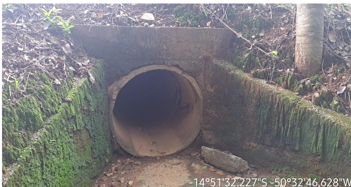
Km: 29,70 - Bueiro tubular.
