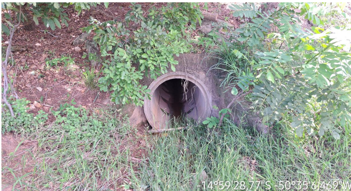
Km: 13,10 - Bueiro tubular.
