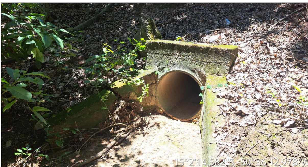
Km: 7,60 - Bueiro tubular.
