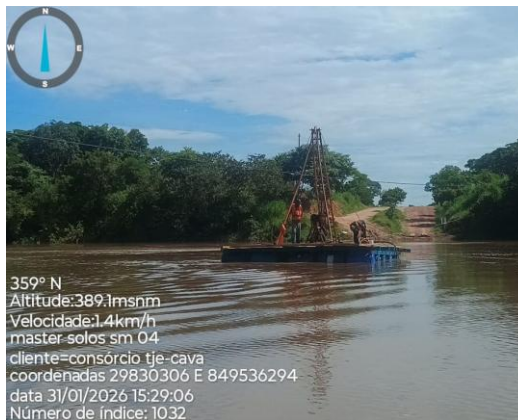
Foto 02 - Vista da execução da sondagem
