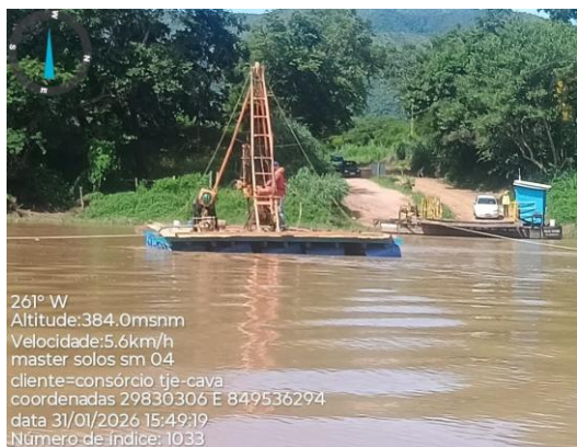
Foto 03 - Vista do local da sondagem
