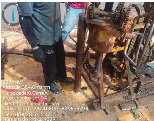
Foto 04 - Vista da execução da sondagem
