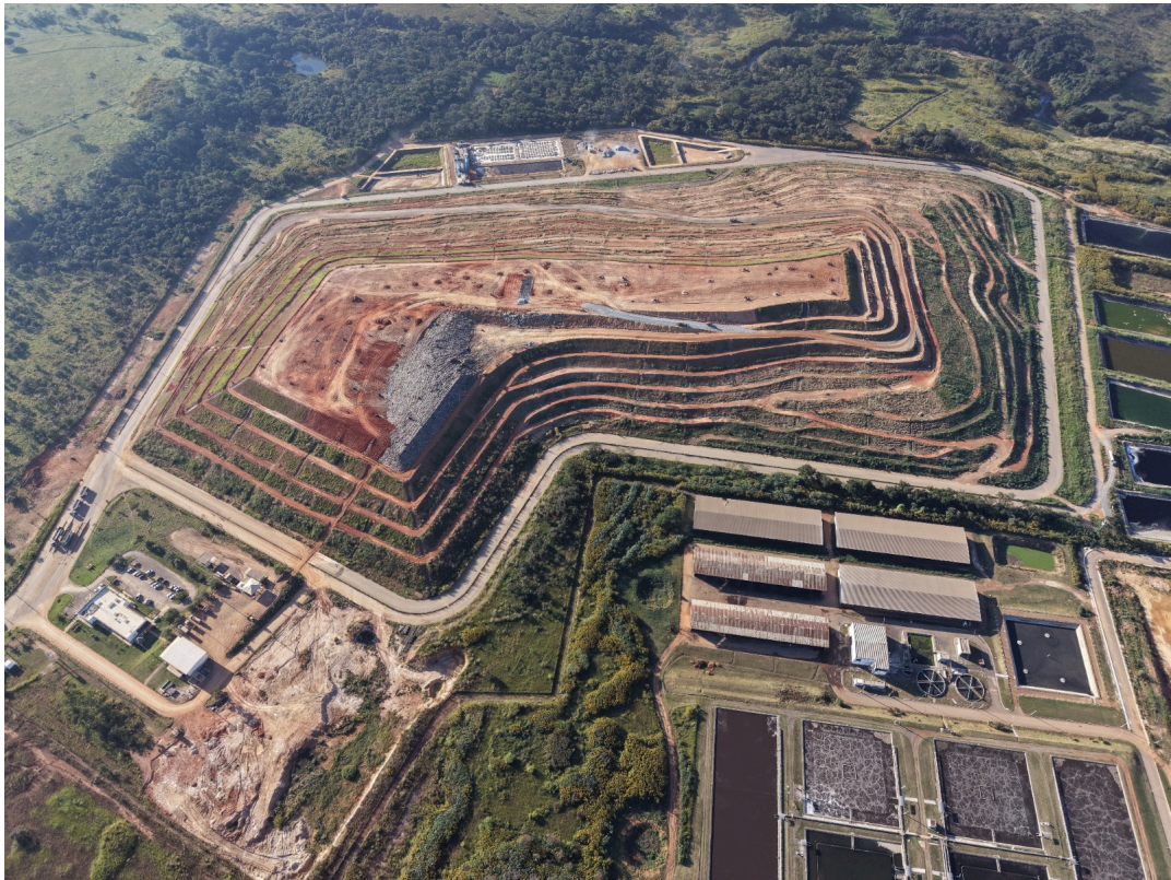
Figura 1 - Aterro Sanitário de Brasília Atual -Etapas 3 e 4 (maio/2026)
