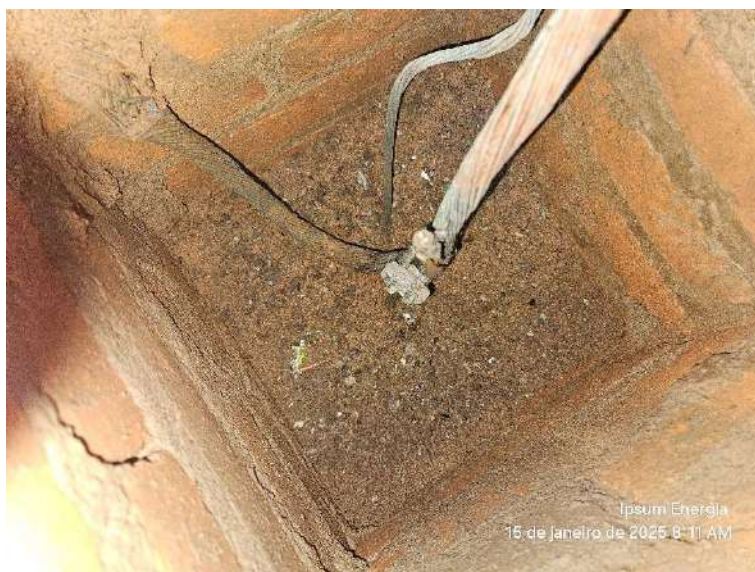
Figura 20-Haste de aterramento
