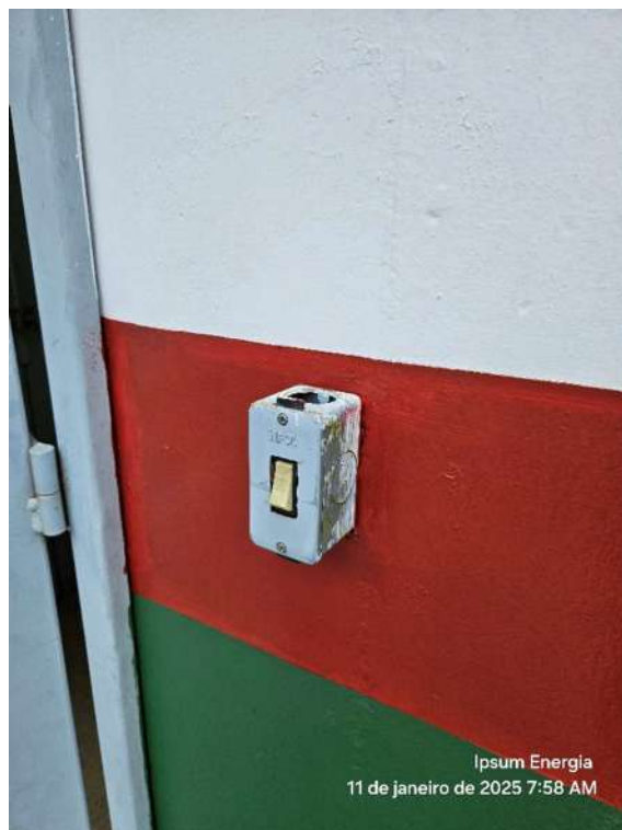
Figura 9-Interruptor danificado
