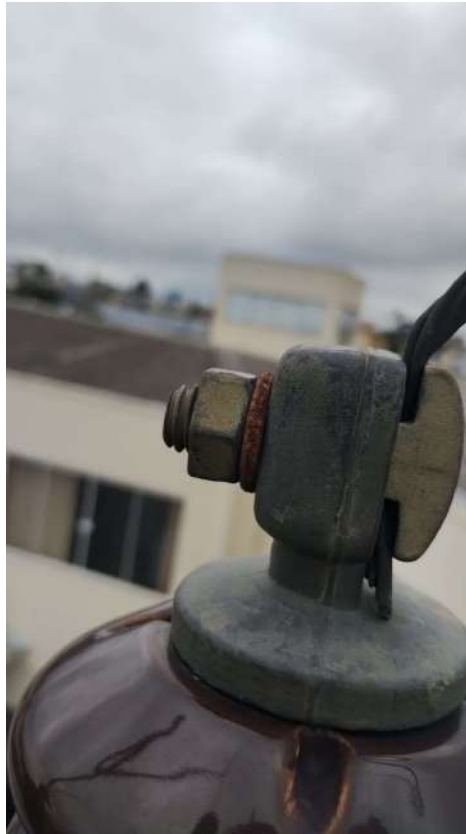
Figura 36-Conexão AT lixada e reapertada
