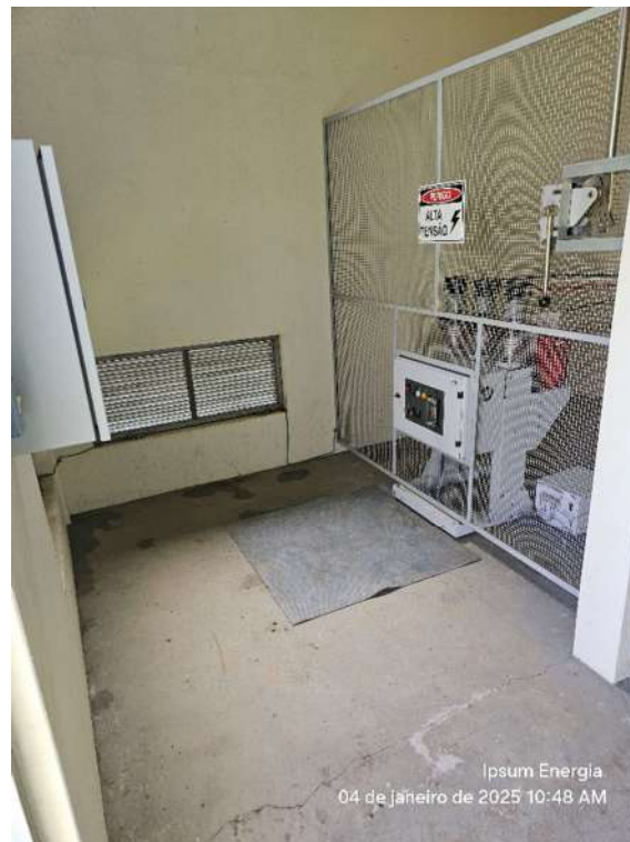
Figura 65-Frente do cubículo de Proteção após limpeza
