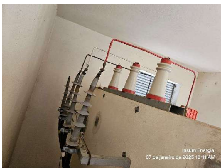
Figura 31-Muflas e isoladores
