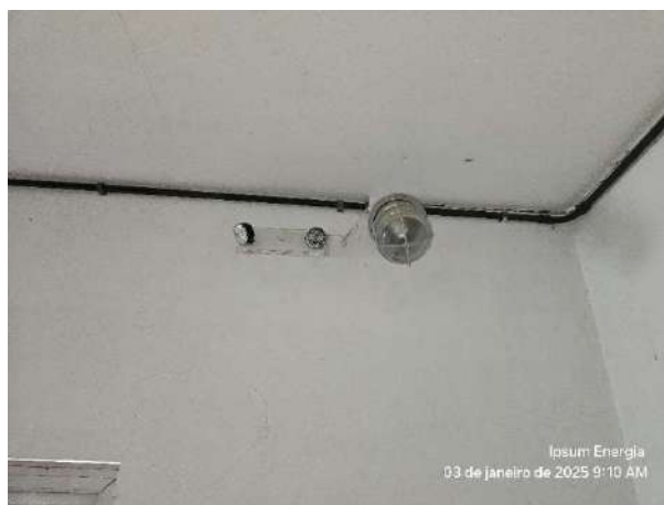
Figura 8-Iluminação de emergência e artificial
