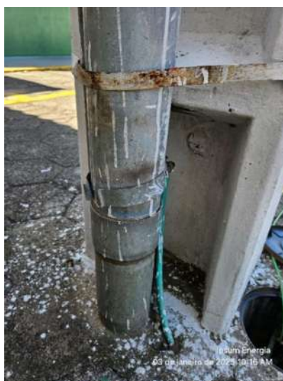
Figura 2-Aterramento eletroduto da média tensão
