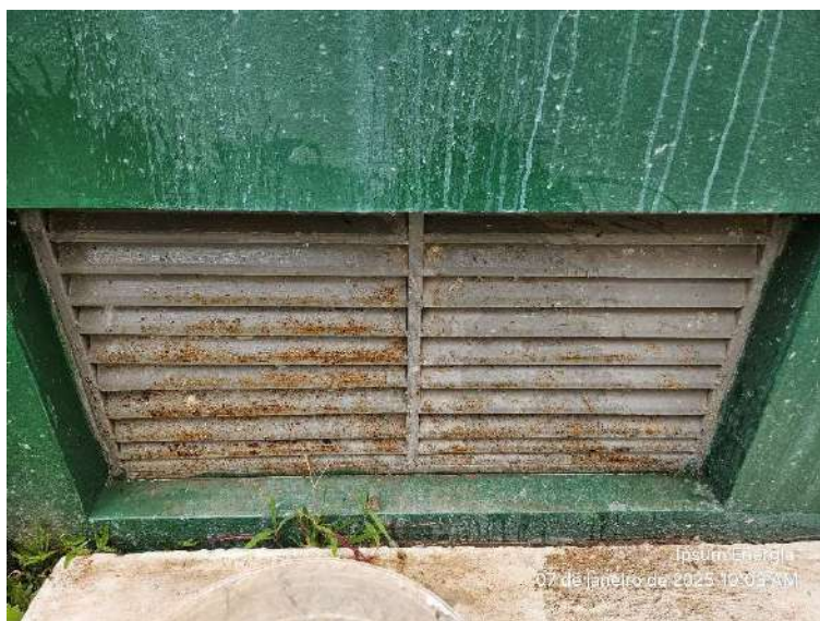
Figura 3-Janela de ventilação
