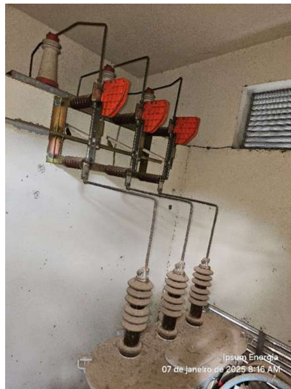
Figura 10-Seccionadora e isoladores
