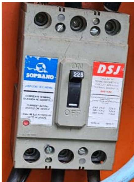
Figura 3-Disjuntor Geral - 225A
