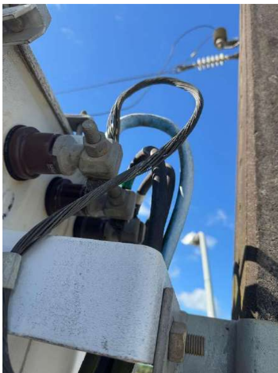
Figura 15-Conexão do aterramento do transformador
