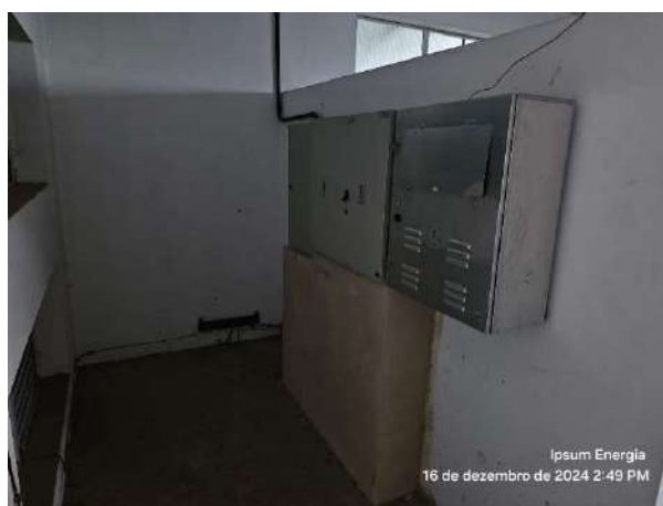
Figura 44-Área da medição após limpeza
