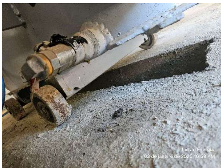
Figura 18-Vazamento de óleo no transformador
