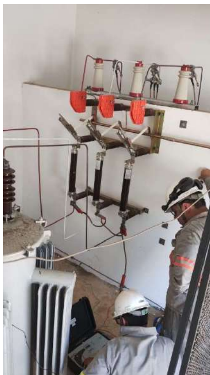
Figura 38-Medição de Resistência de isolamento
