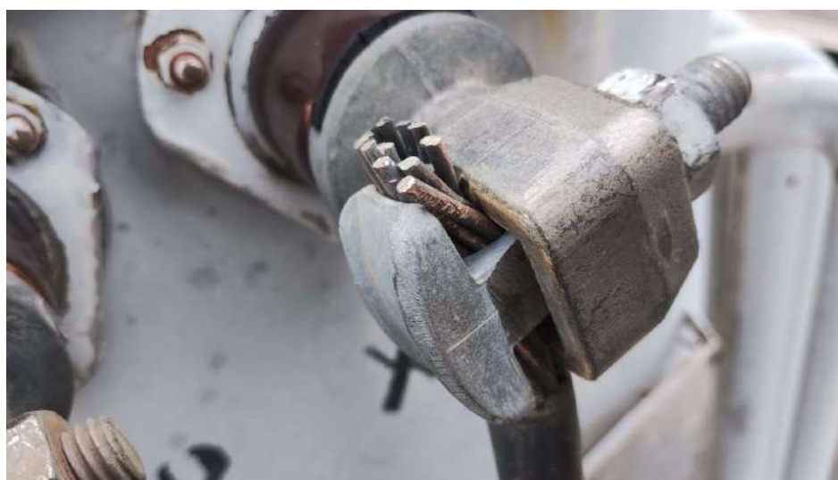
Figura 35-Conexão BR reapertada
