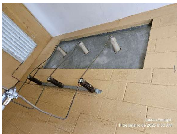
Figura 20-Isoladores cubiculo entrada
