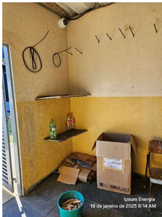
Figura 12-Objetos inadequados a instalação
