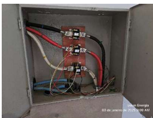
Figura 4-Quadro dos TC's antes da manutenção
