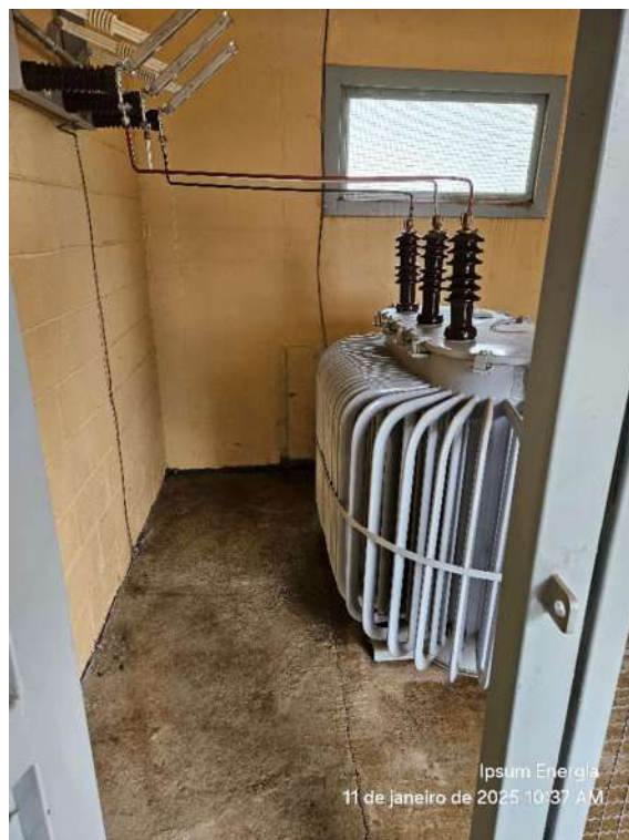
Figura 58-Cubiculo de transformação
