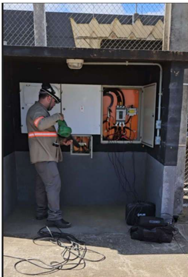
Figura 43-Limpeza da SE com soprador
