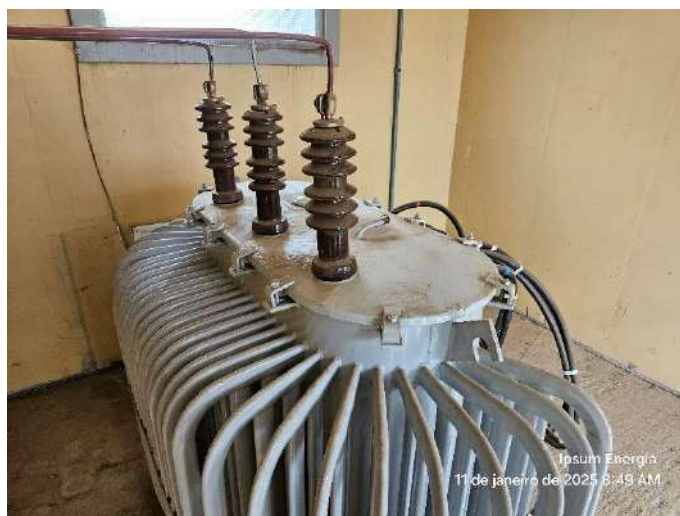
Figura 12-Transformador de 500KVA
