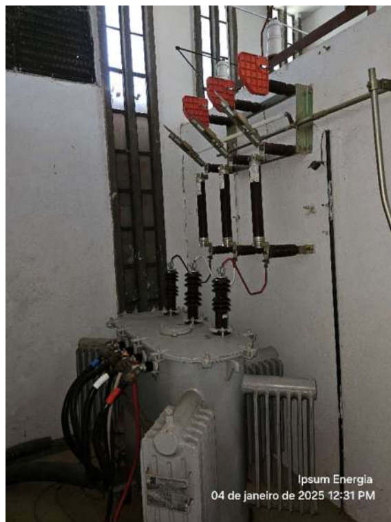
Figura 74-Transformador Principal 225KVA
