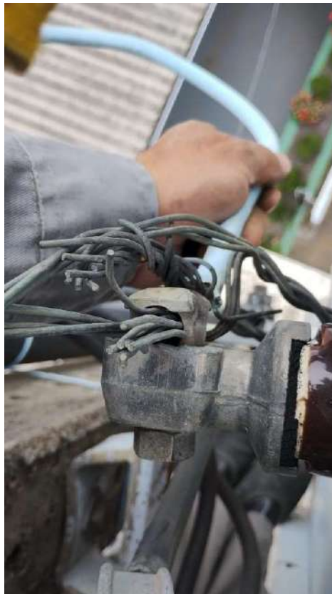
Figura 10-Cabo neutro frouxo e arrebitado
