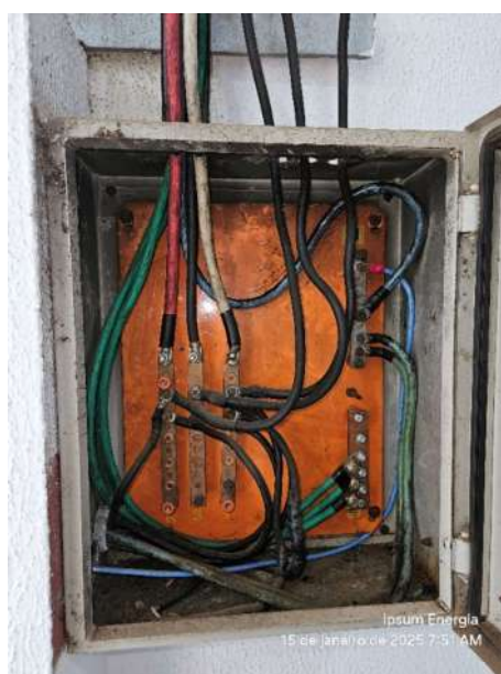
Figura 1-Quadro de barramentos
