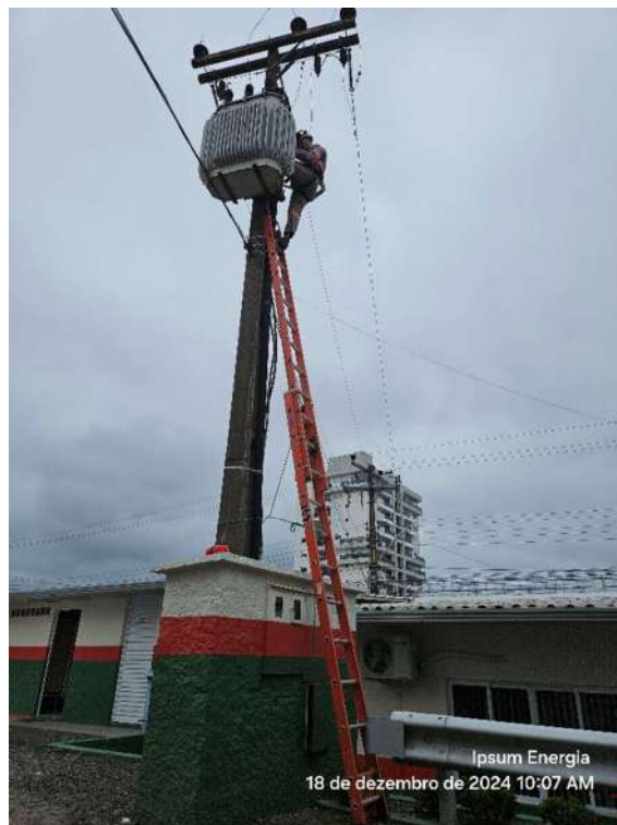
Figura 37-Realização da Manutenção no Trafo
