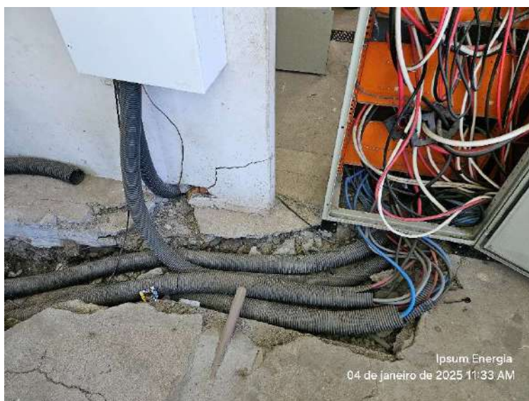
Figura 40-Desníveis no piso
