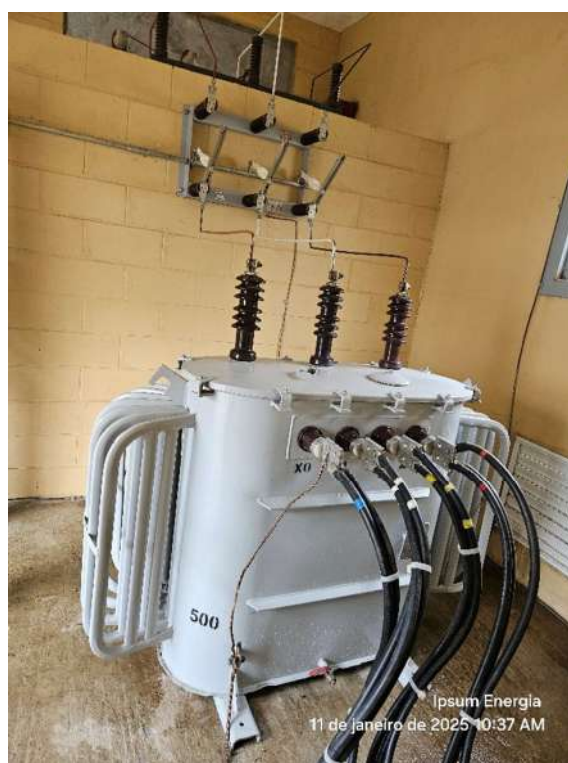
Figura 59-Cubiculo de transformação
