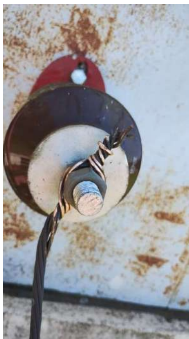
Figura 62-Conexão da bucha de passagem após manutenção
