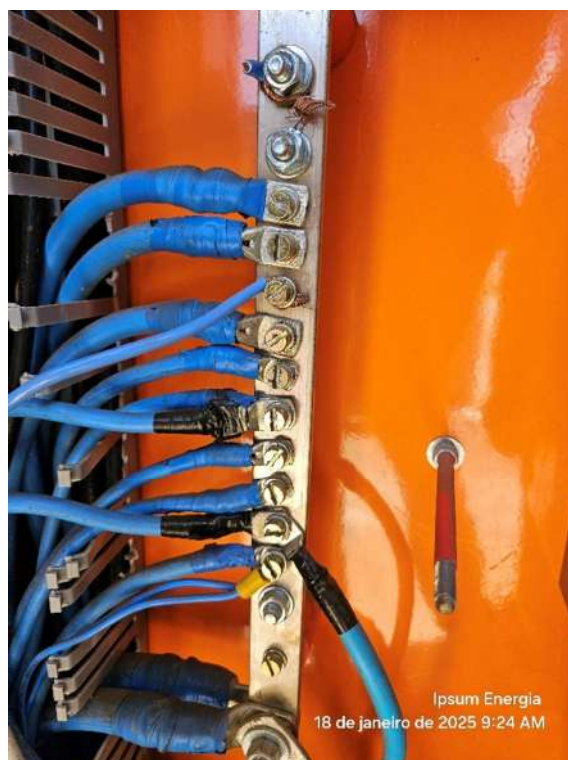
Figura 6-Barramento de neutro
