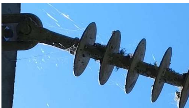
Figura 5-Bastões com excesso de sujeira
