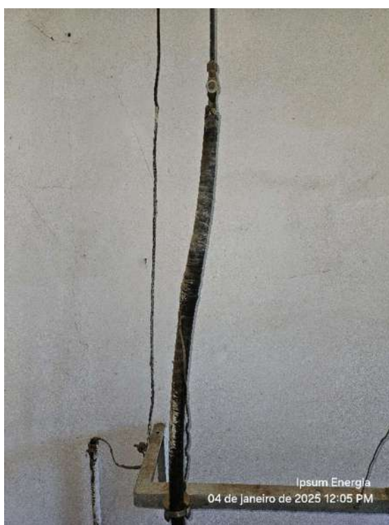
Figura 24-Mufla da fase T – isolada
