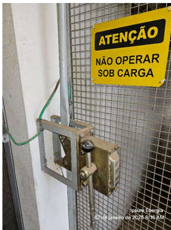
Figura 12-Braço de Manobra da Seccionadora
