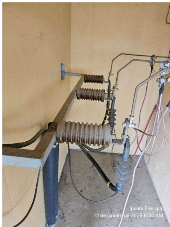
Figura 19-Entrada muflas – isoladores
