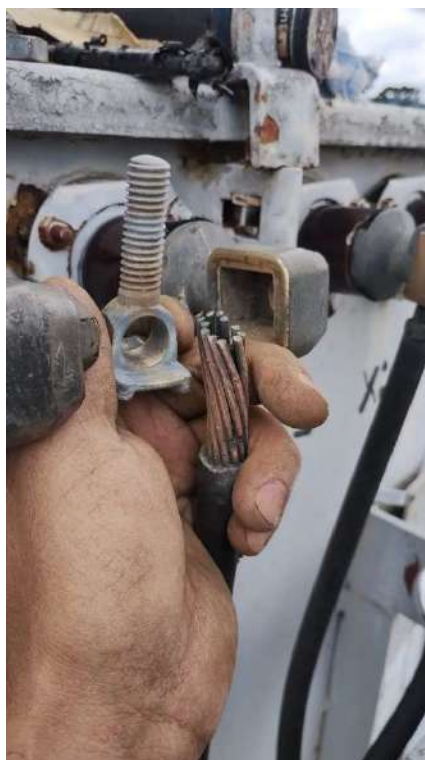
Figura 34-Conexão BT lixada
