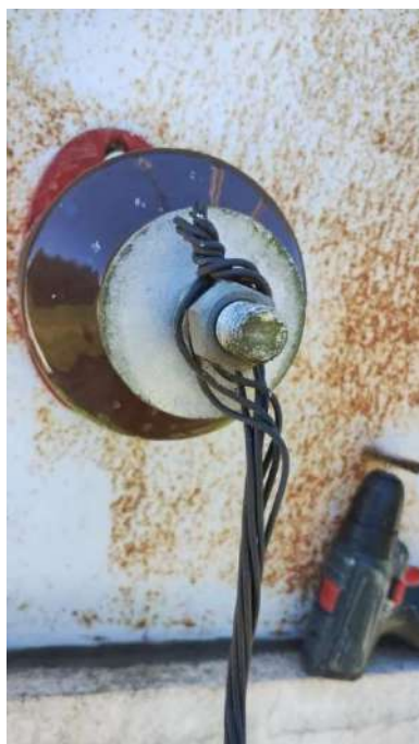
Figura 4-Bucha de passagem sem terminais e arruelas
