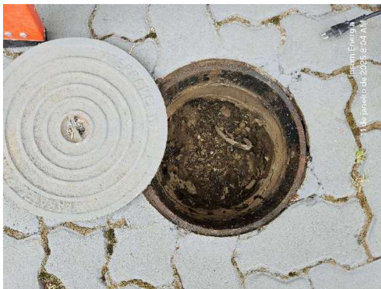
Figura 25-Caixa de inspeção 01 – concretada
