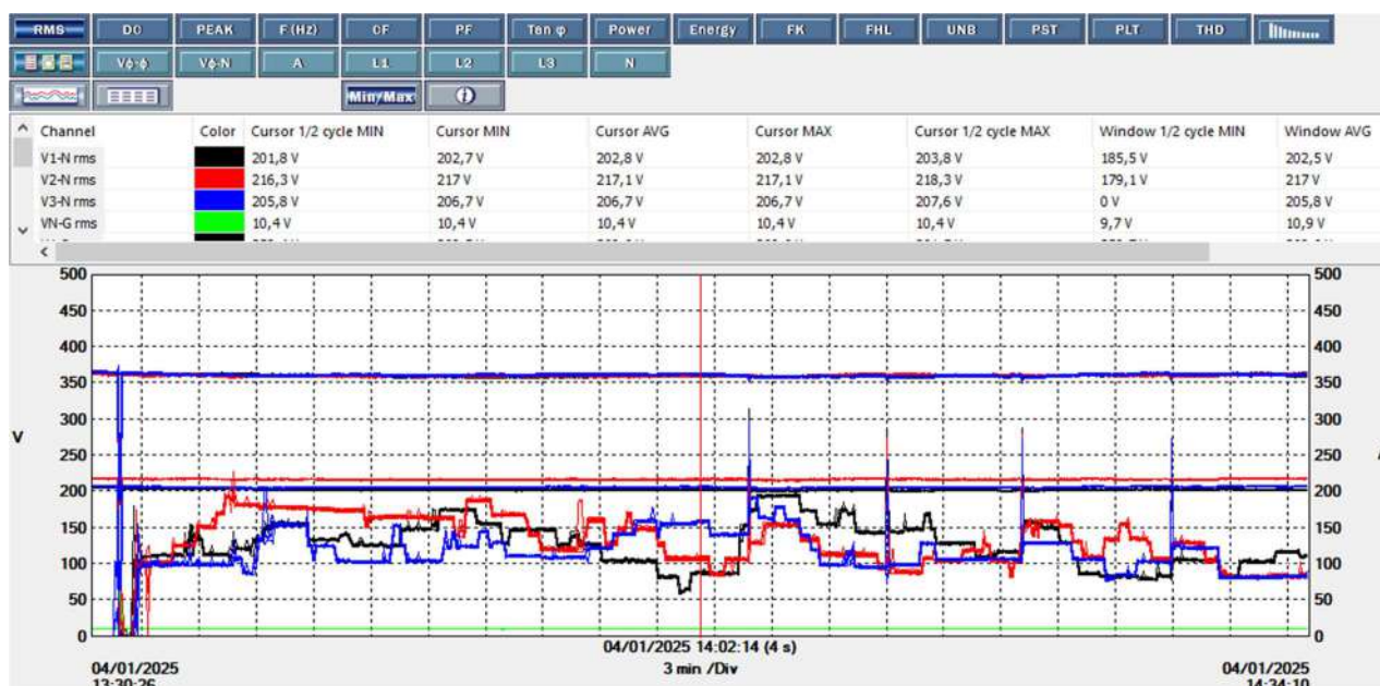
Figura 50-Visão geral da AQEE – com início na energização
