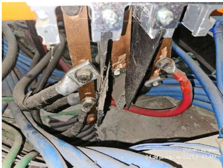
Figura 35-Chave de entrada do QGBT
