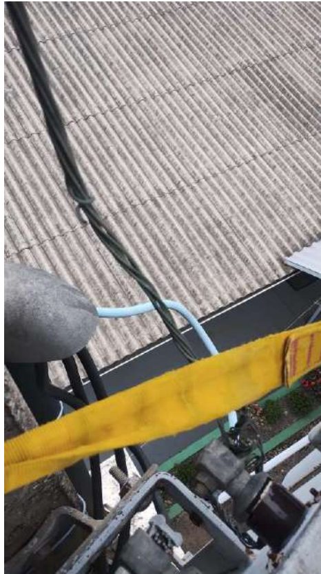
Figura 9-Cabo com secção reduzida - arrebitado
