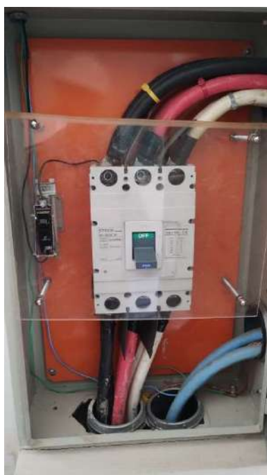
Figura 39-Quadro do Disjuntor Geral após manutenção
