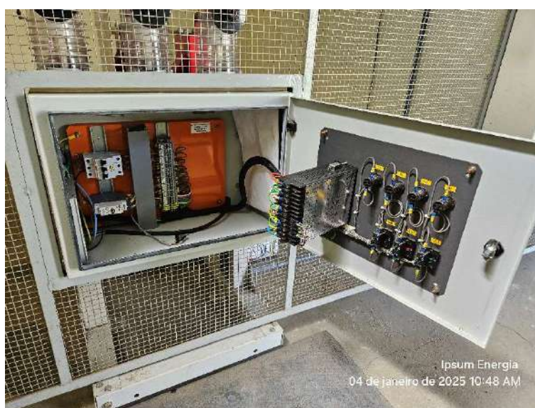
Figura 68-Painel da Proteção após limpeza e reaperto geral
