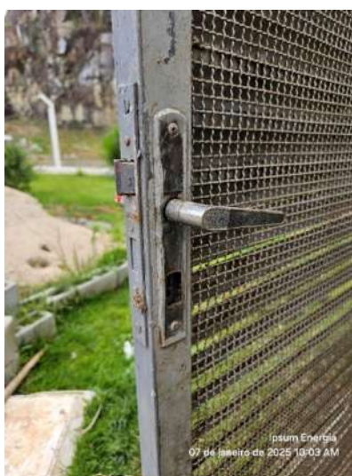
Figura 2-Fechadura danificada
