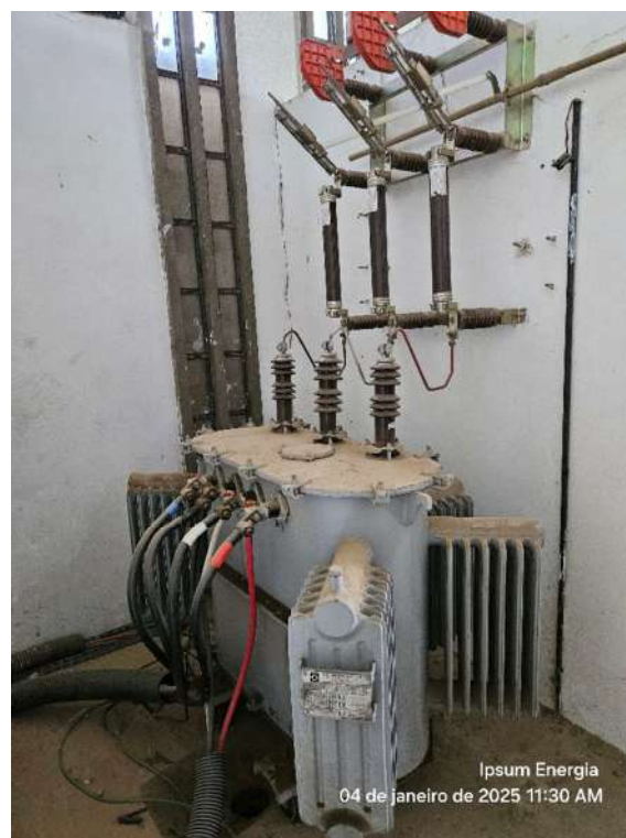
Figura 30-Transformador 225KVA
