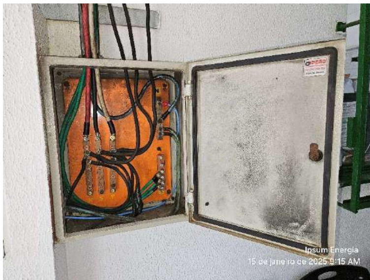
Figura 43-Quadro de barramentos após manutenção
