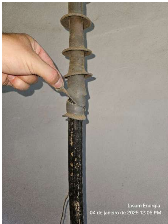
Figura 23-Mufla da fase S – rasgada
