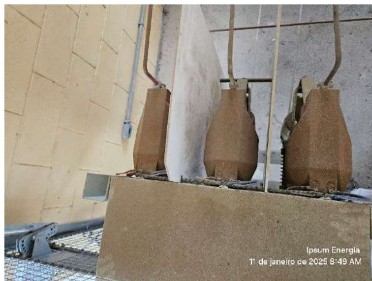
Figura 16-TC's do Disjuntor da unidade
