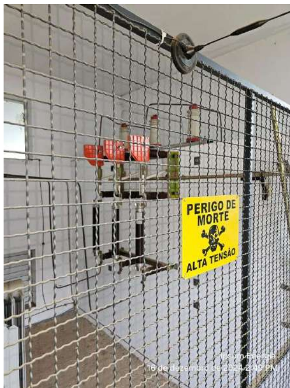
Figura 45-Área da Seccionadora e isoladores após limpeza
