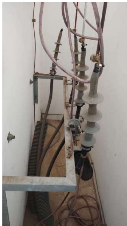
Figura 22-Muflas empoeiradas
