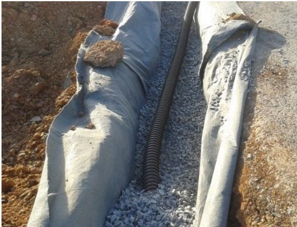
Figura 6 -Colocação da brita sobre a manta geotêxtil.
