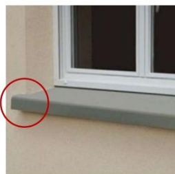
Figura 1 - Peitoril embutido 1 cm na alvenaria
