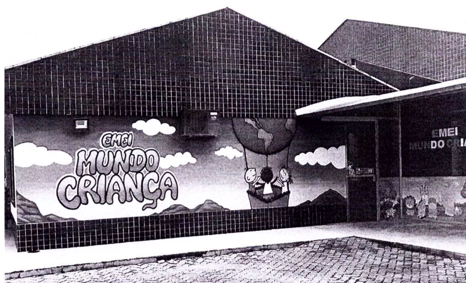
Fachada de escola infantil de Capitão
