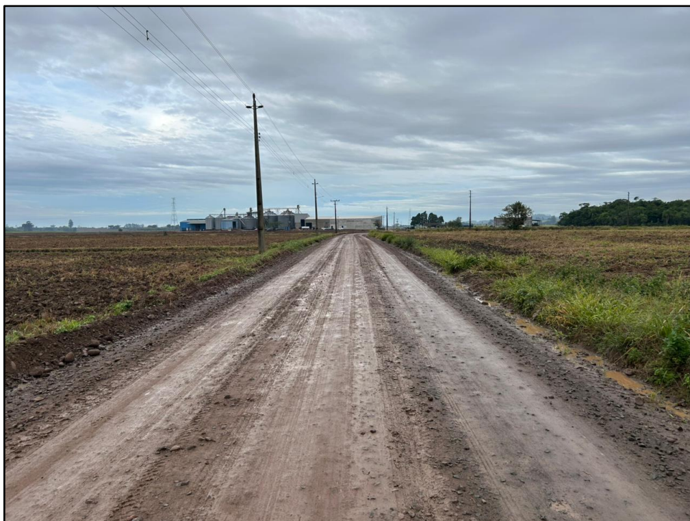
Figura 4 - Trecho da ERM 130 a ser pavimentado
