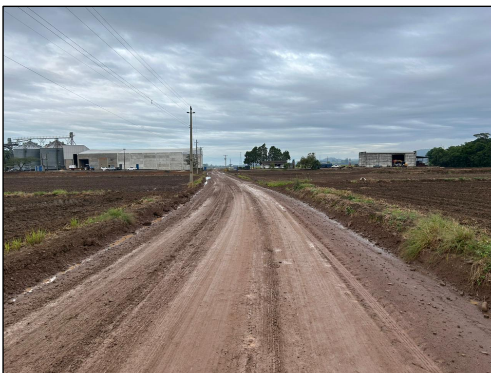
Figura 7 - Trecho da ERM 130 a ser pavimentado
