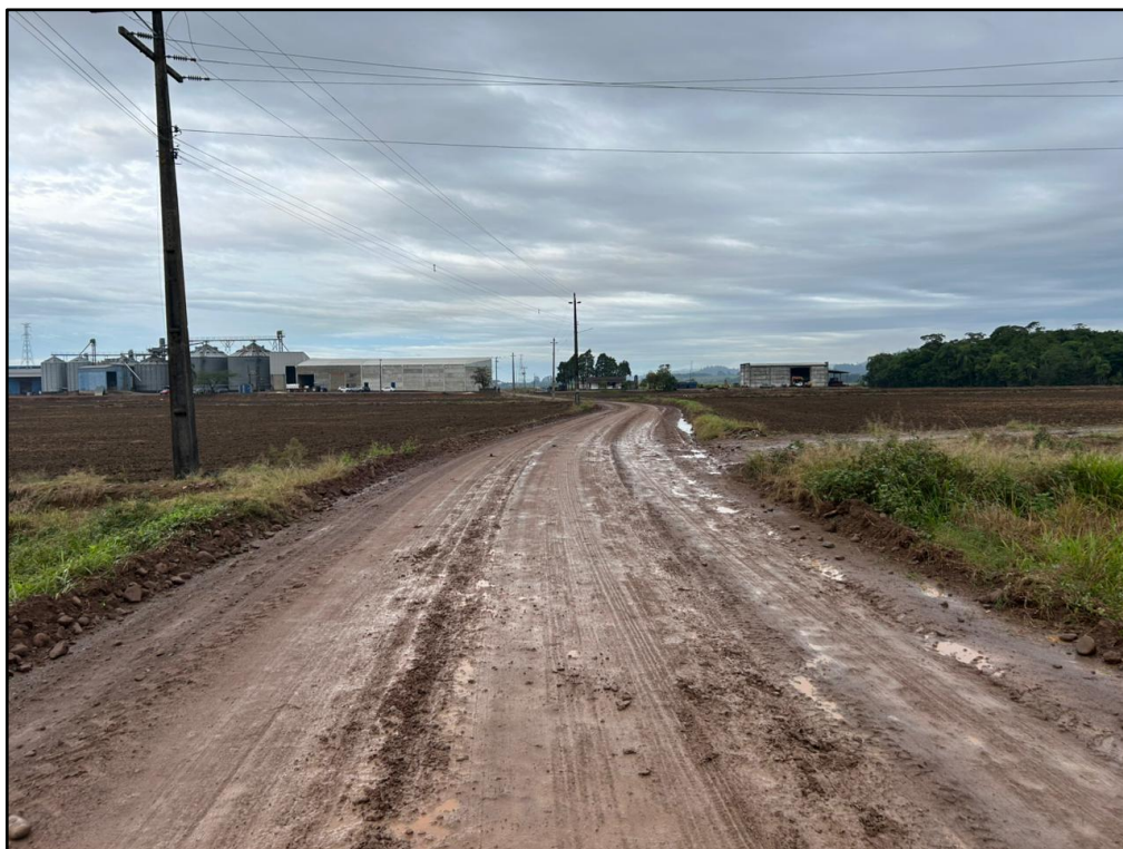
Figura 6 - Trecho da ERM 130 a ser pavimentado
