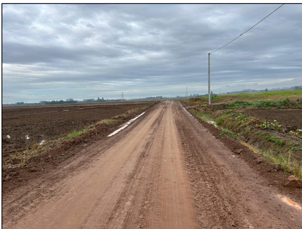
Figura 11 - Trecho da TVO 350 a ser pavimentado
