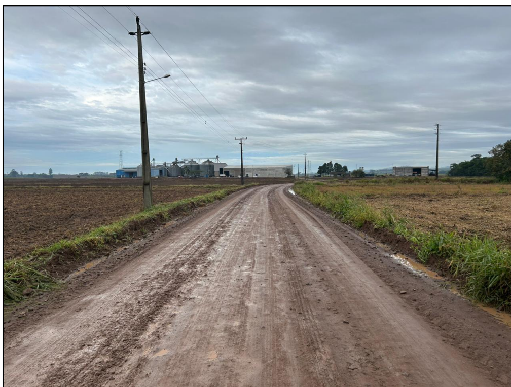
Figura 5 - Trecho da ERM 130 a ser pavimentado
