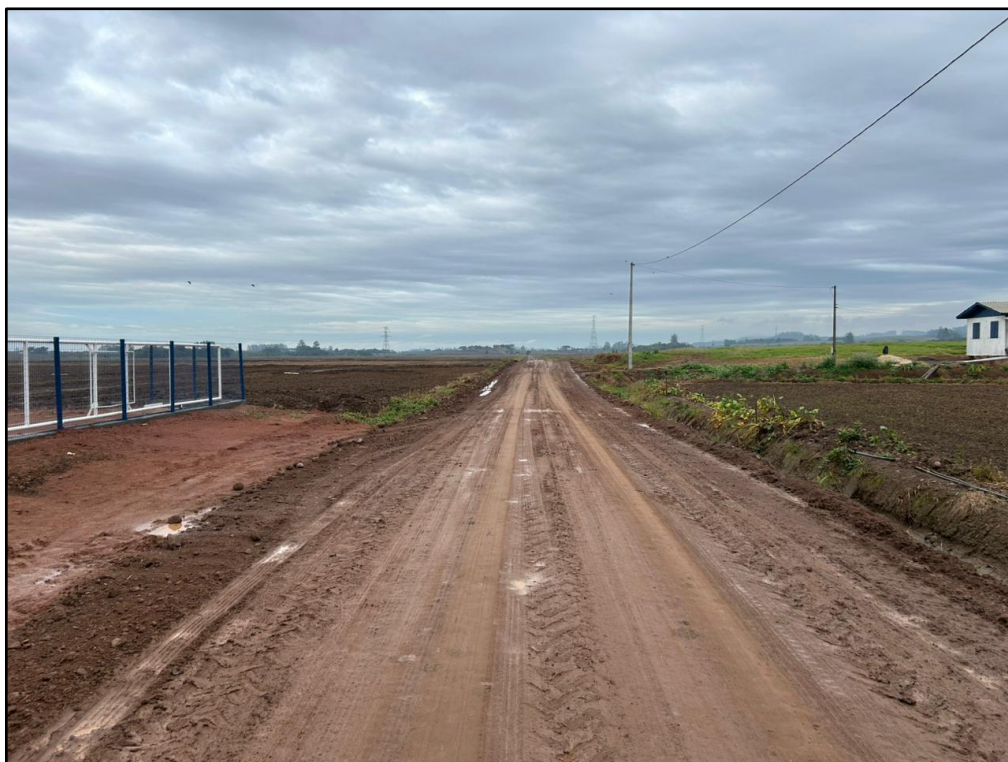
Figura 10 - Trecho da ERM 130 a ser pavimentado
