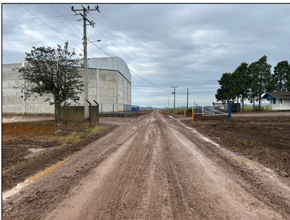
Figura 9 - Trecho da ERM 130 a ser pavimentado
