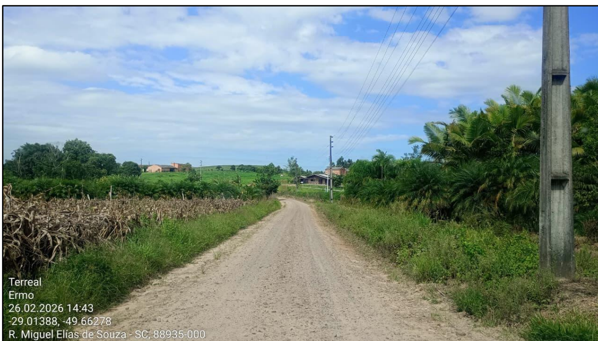
Figura 12 - Trecho da Rodovia Municipal ERM 125 a ser pavimentado
