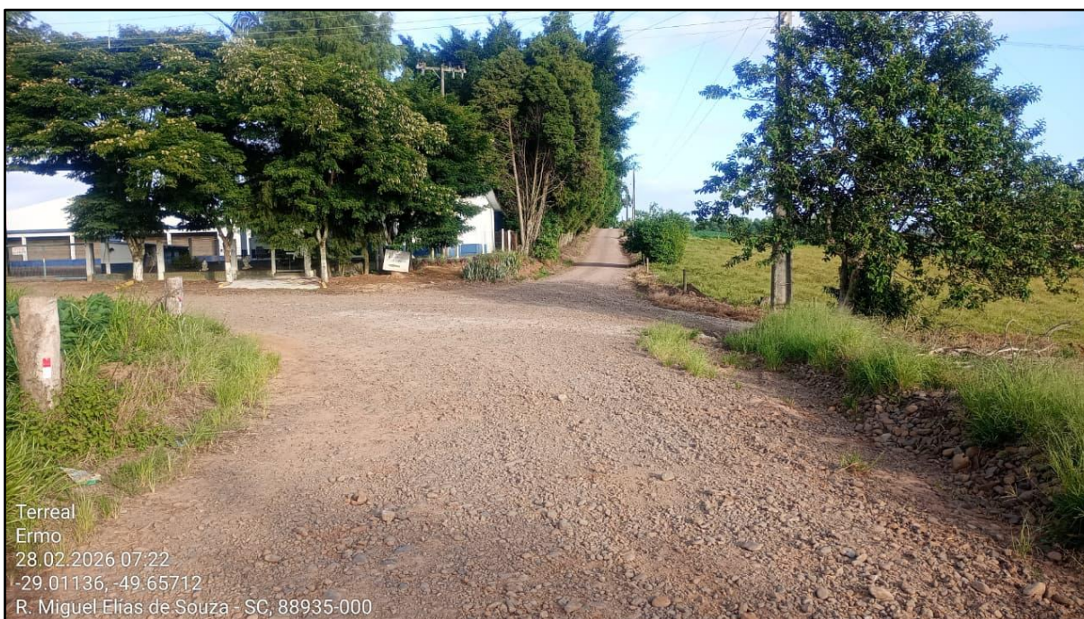
Figura 20 - Trecho da Rodovia Municipal ERM 125 a ser pavimentado
