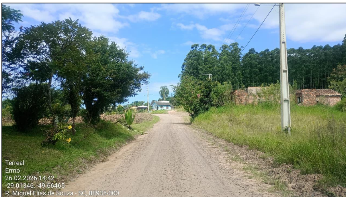
Figura 10 - Trecho da Rodovia Municipal ERM 125 a ser pavimentado
