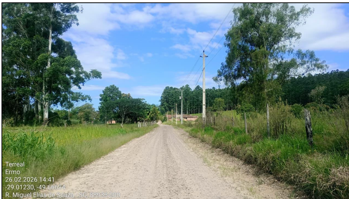
Figura 9 - Trecho da Rodovia Municipal ERM 125 a ser pavimentado
