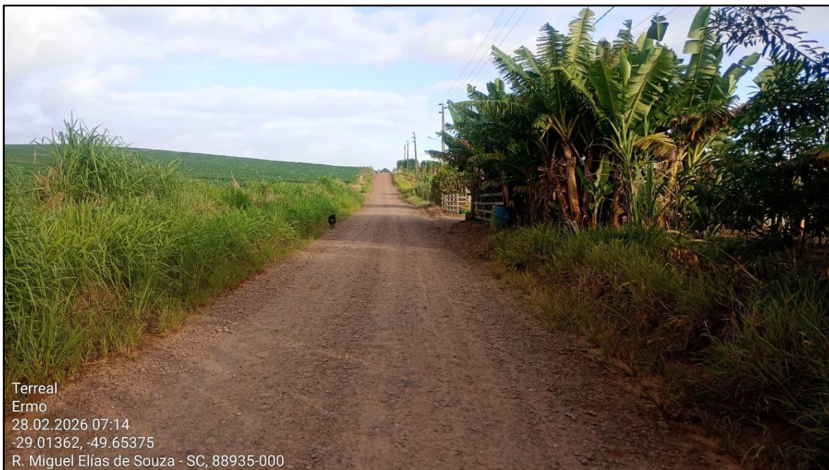
Figura 25 – Trecho da Rodovia Municipal ERM 125 a ser pavimentado
