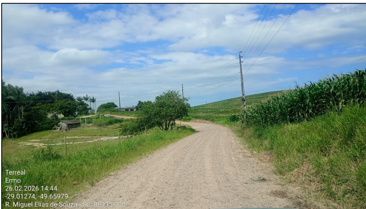
Figura 16 - Trecho da Rodovia Municipal ERM 125 a ser pavimentado
