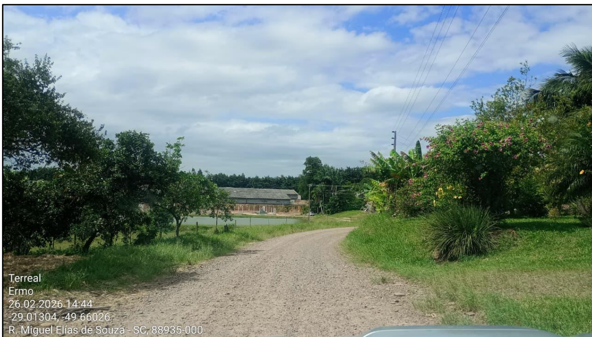
Figura 15 - Trecho da Rodovia Municipal ERM 125 a ser pavimentado
