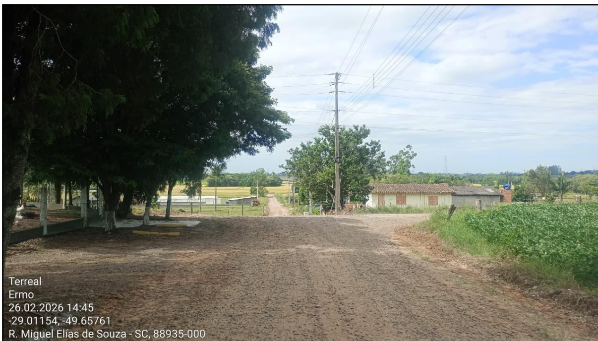
Figura 19 – Trecho da Rodovia Municipal ERM 125 a ser pavimentado
