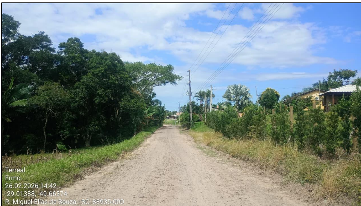
Figura 11 - Trecho da Rodovia Municipal ERM 125 a ser pavimentado
