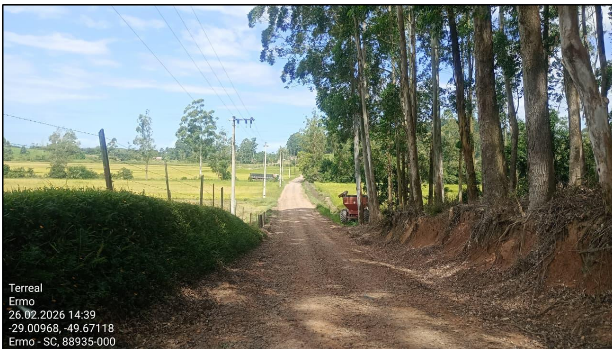
Figura 7 - Trecho da Rodovia Municipal ERM 125 a ser pavimentado
