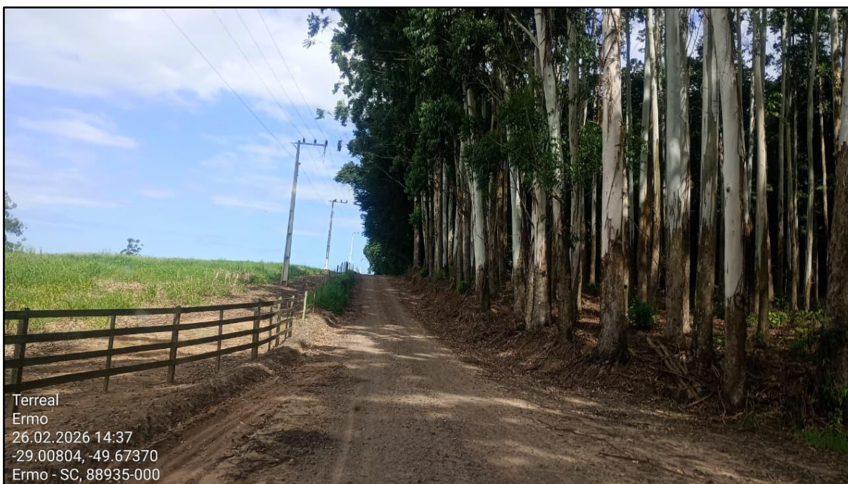
Figura 6 - Trecho da Rodovia Municipal ERM 125 a ser pavimentado
