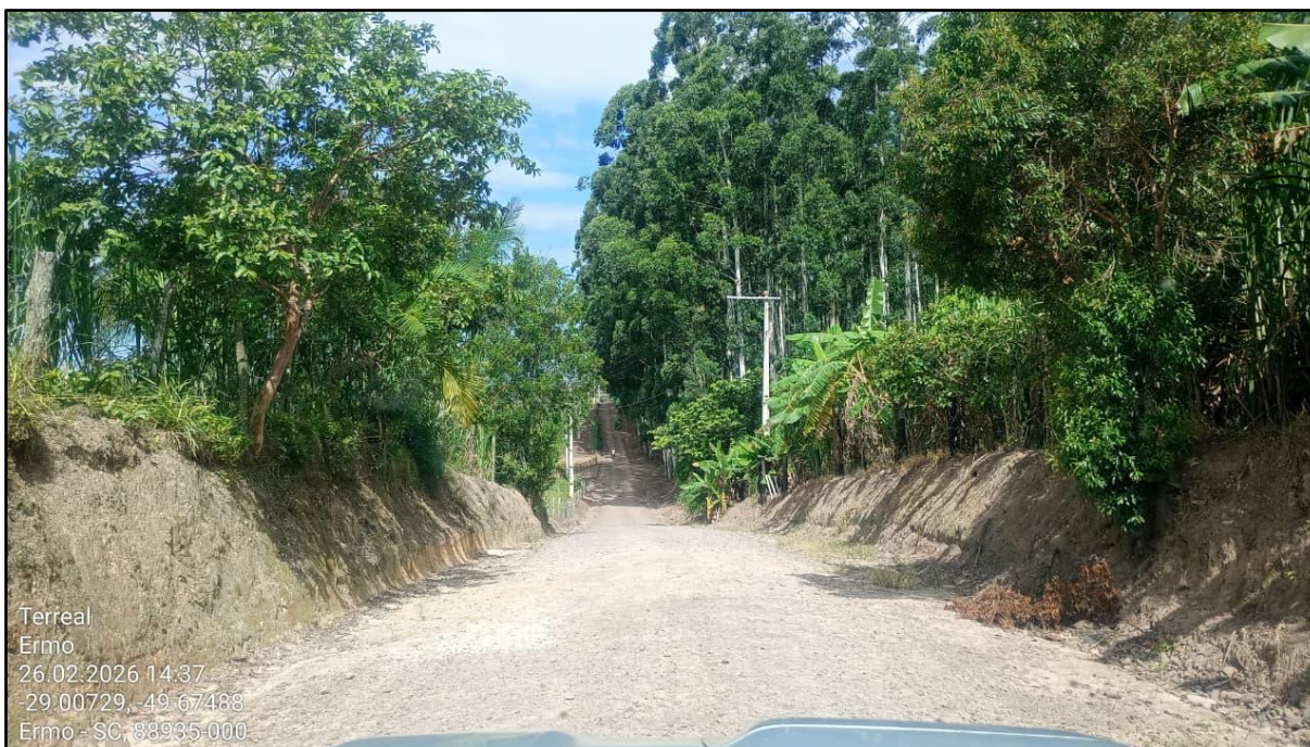
Figura 5 - Trecho da Rodovia Municipal ERM 125 a ser pavimentado
