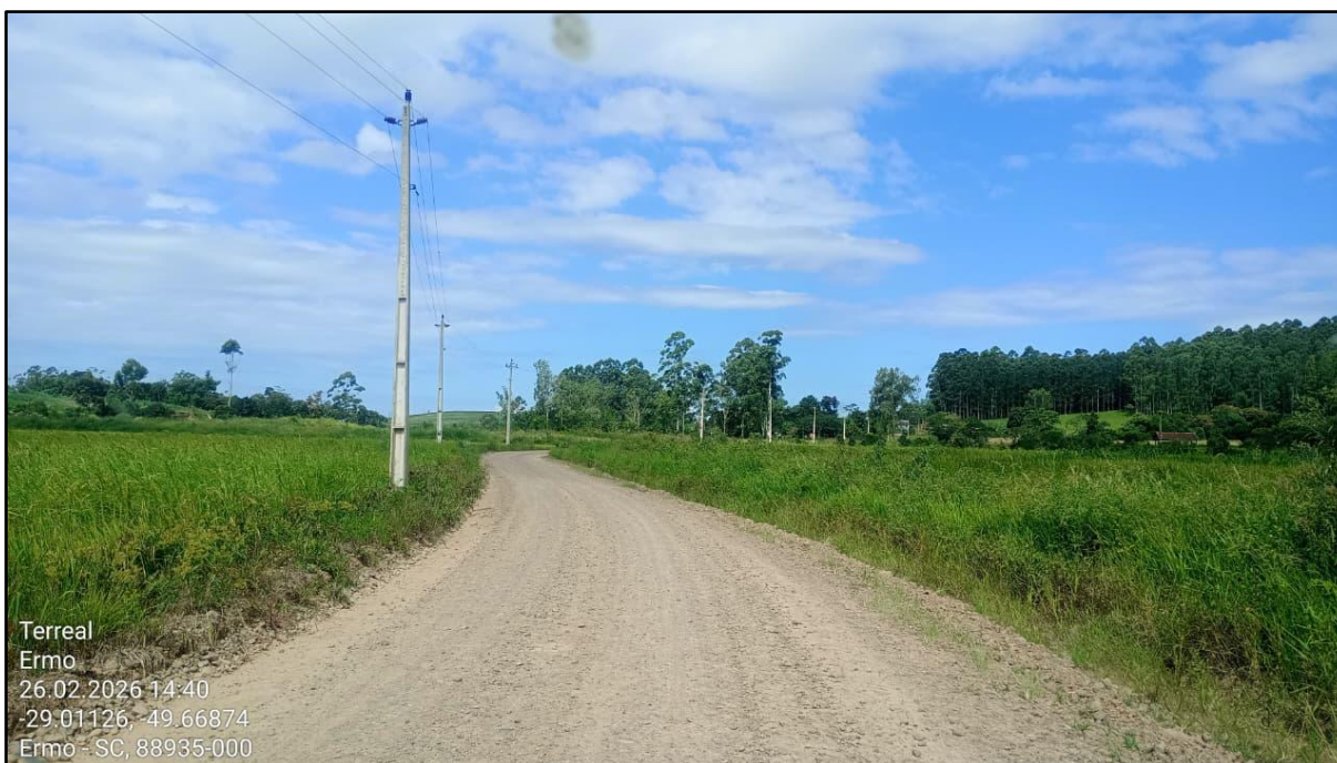
Figura 8 - Trecho da Rodovia Municipal ERM 125 a ser pavimentado
