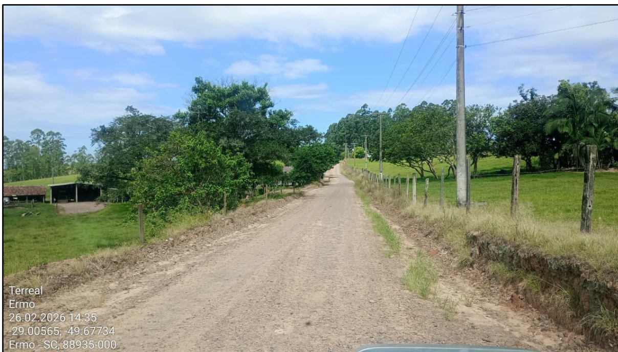
Figura 3 - Trecho da Rodovia Municipal ERM 125 a ser pavimentado
