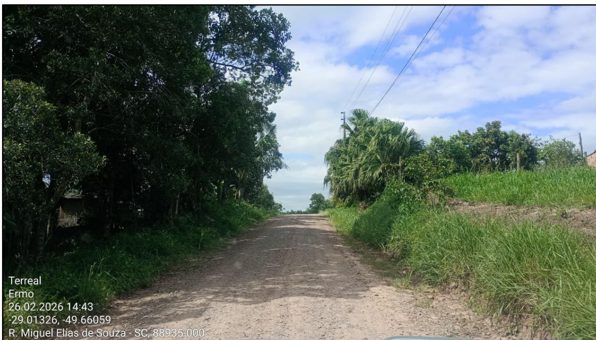
Figura 14 - Trecho da Rodovia Municipal ERM 125 a ser pavimentado
