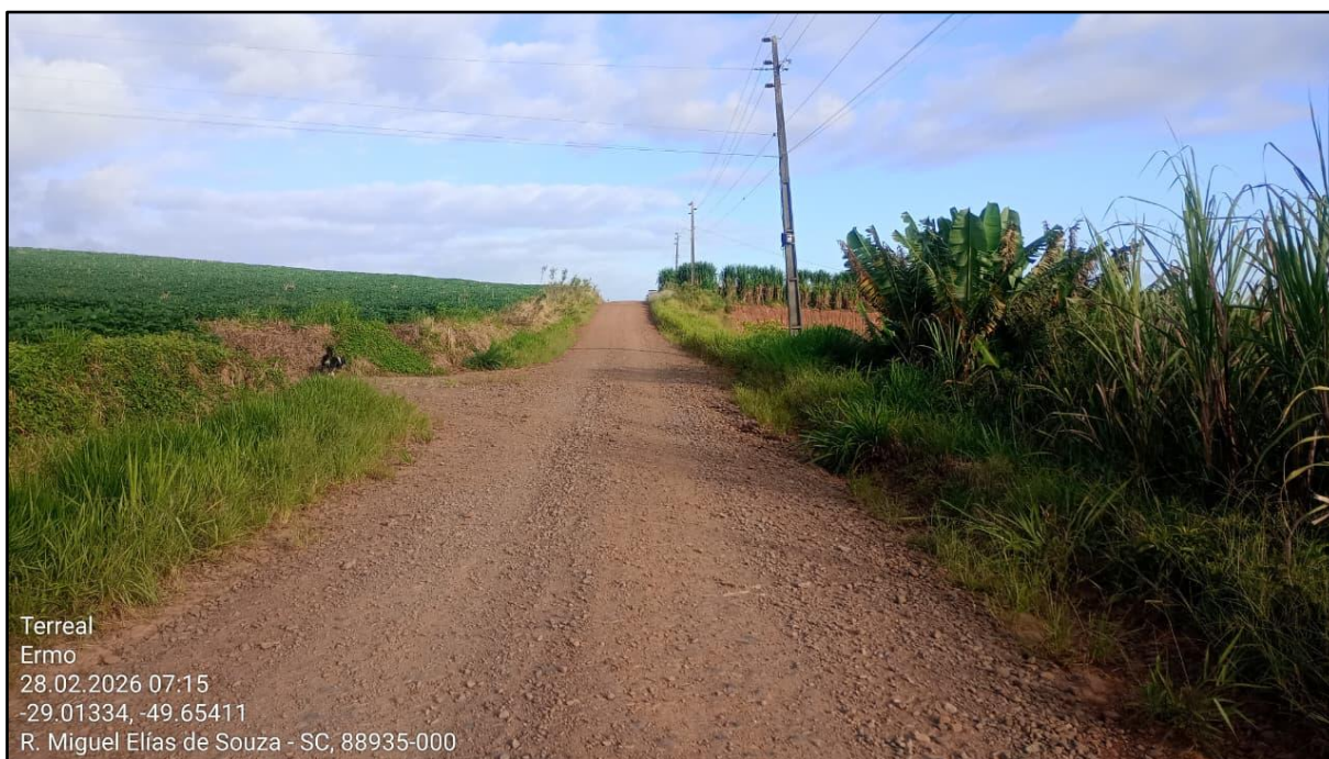
Figura 24 - Trecho da Rodovia Municipal ERM 125 a ser pavimentado
