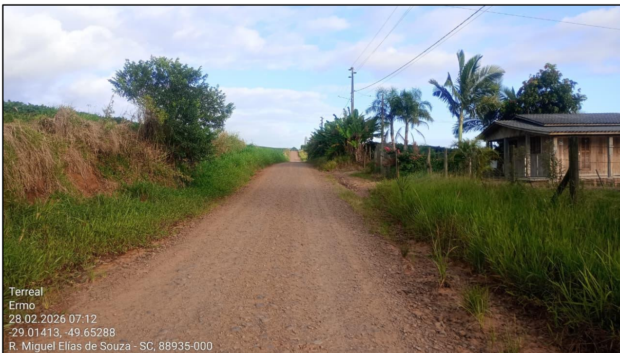
Figura 26 - Trecho da Rodovia Municipal ERM 125 a ser pavimentado
