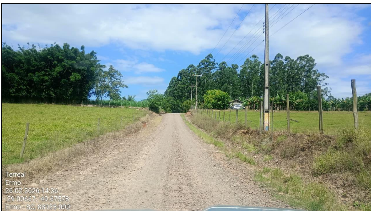
Figura 4 - Trecho da Rodovia Municipal ERM 125 a ser pavimentado
