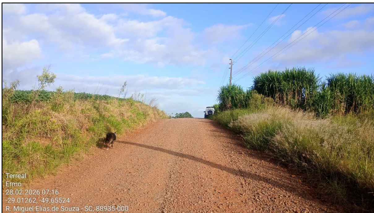
Figura 23 – Trecho da Rodovia Municipal ERM 125 a ser pavimentado
