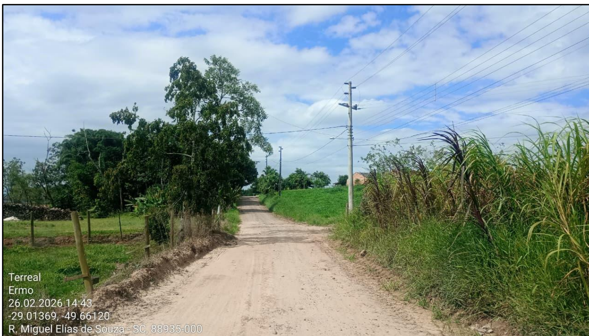
Figura 13 – Trecho da Rodovia Municipal ERM 125 a ser pavimentado
