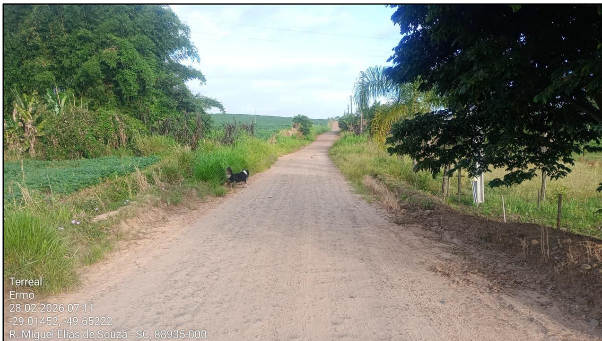
Figura 27 – Trecho da Rodovia Municipal ERM 125 a ser pavimentado
