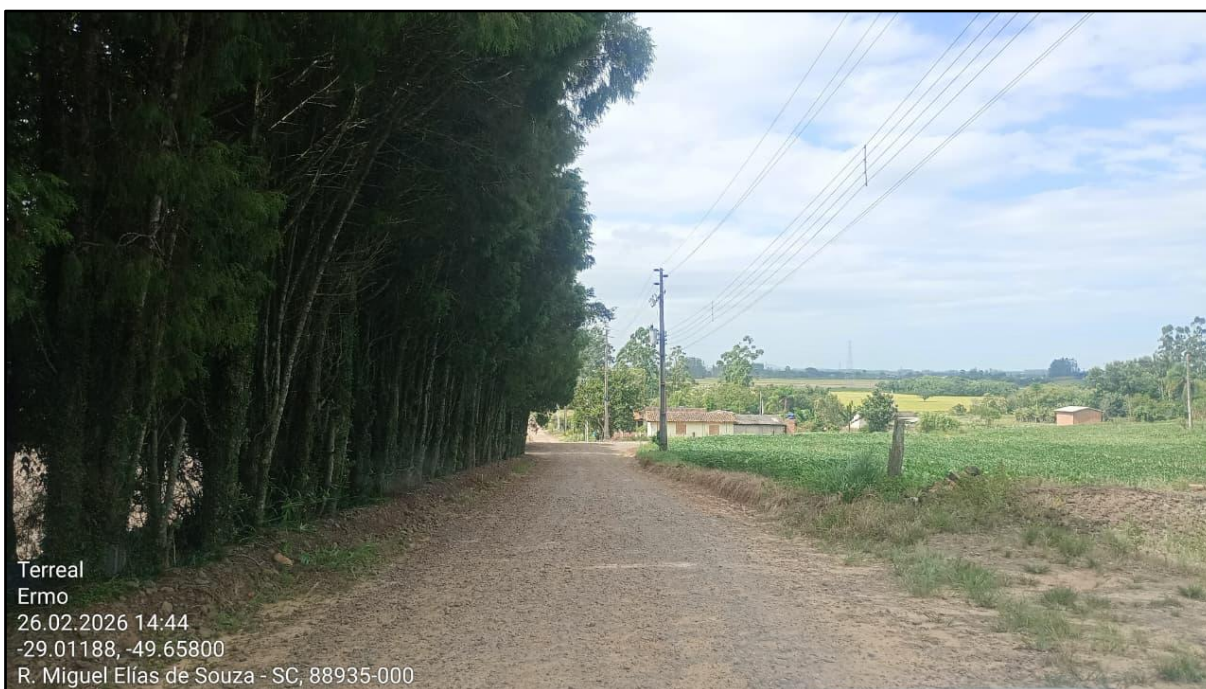
Figura 18 - Trecho da Rodovia Municipal ERM 125 a ser pavimentado
