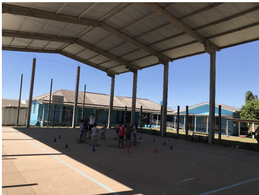
Registro fotográfico 01 - Quadra poliesportiva a ser ampliada e reformada
