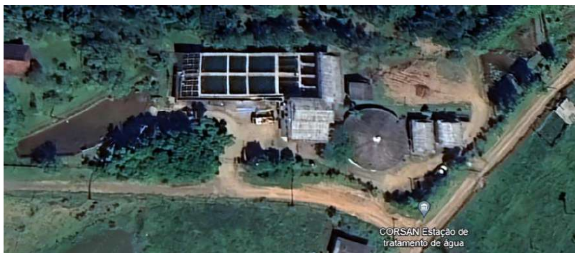
Figura 99 – Vista superior – ETA de Parobé.
