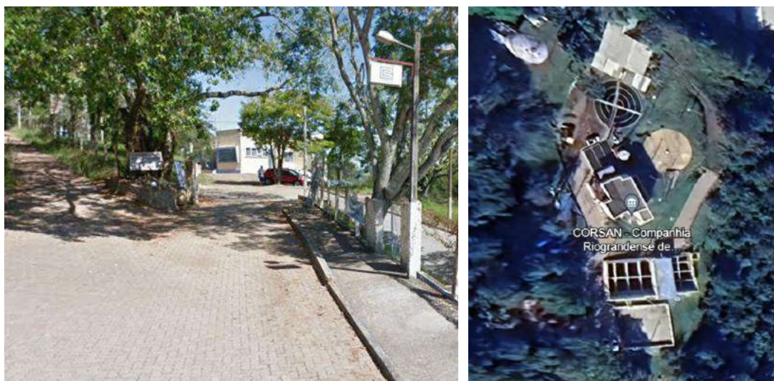
Figura 103 – ETA de São Sebastião do Caí.
