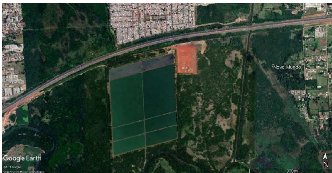
Figura 121 – Vista da ETE Freeway.
