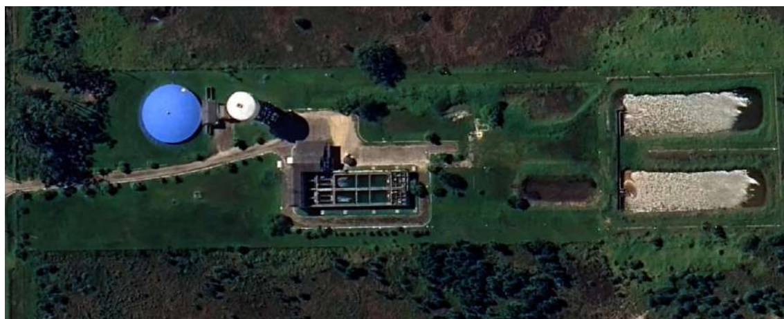
Figura 72 – Vista superior da ETA Curumim.
