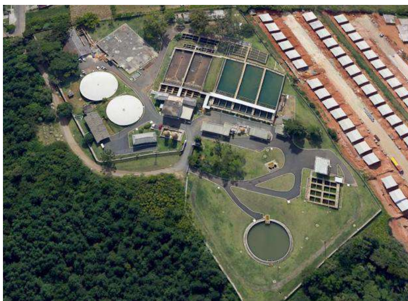
Figura 78 – ETA Campo Bom.
