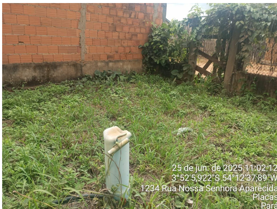
Foto 6- Vista do Poço existente.
