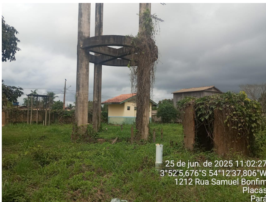
Foto 3: poço, casa de bomba e edificação ao fundo -setor1.
