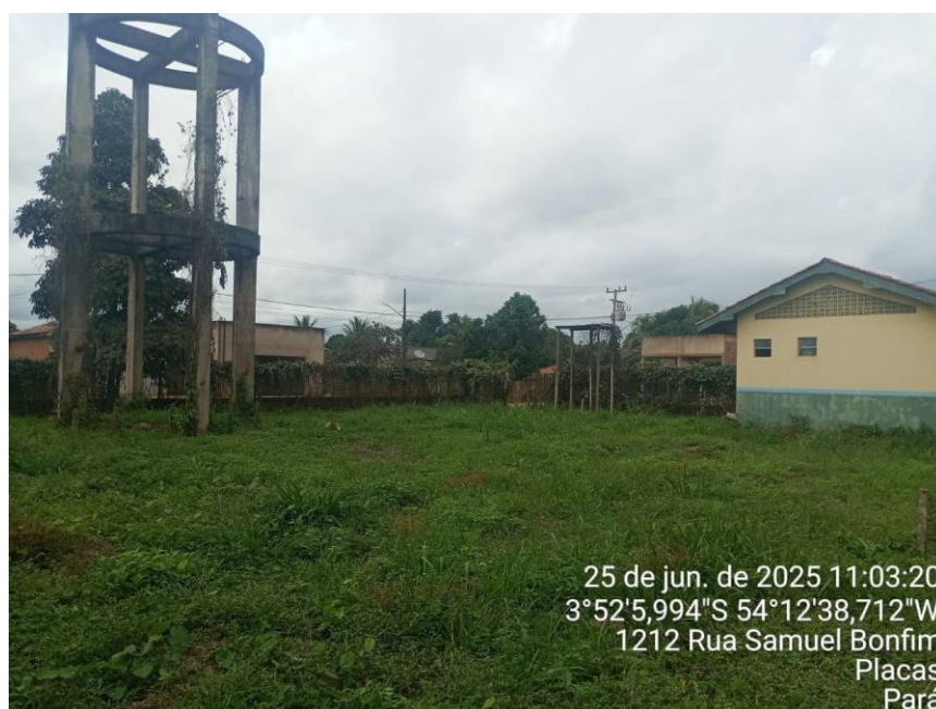
Figura 10– Terreno para implantação do Sistema de Abastecimento de água do município de Placas -Pa. Ainda sem o reservatório.
