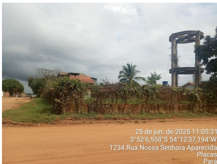
Foto 2– Vista do Terreno e da Torre do Reservatório pela Rua Nossa Senhora Aparecida.
