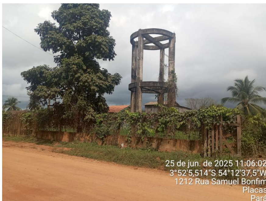
Figura 9– Imagem da torre do Reservatório do Sistema de Abastecimento do município de Placas -Pa. Ainda sem o reservatório.
