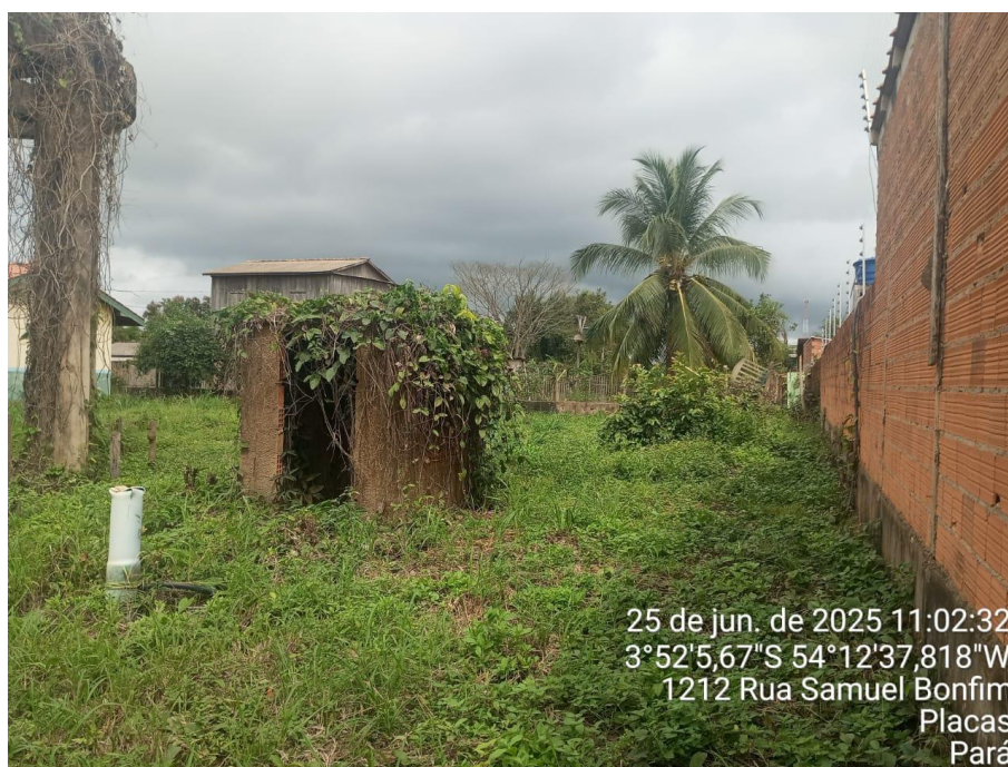
Foto 5- Casa de bomba e poço
