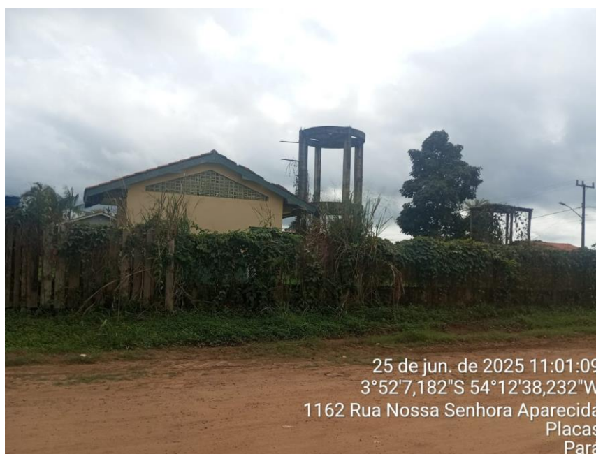
Foto 4: é mostrado o poço, casa de bomba e edificação ao fundo -setor1.
