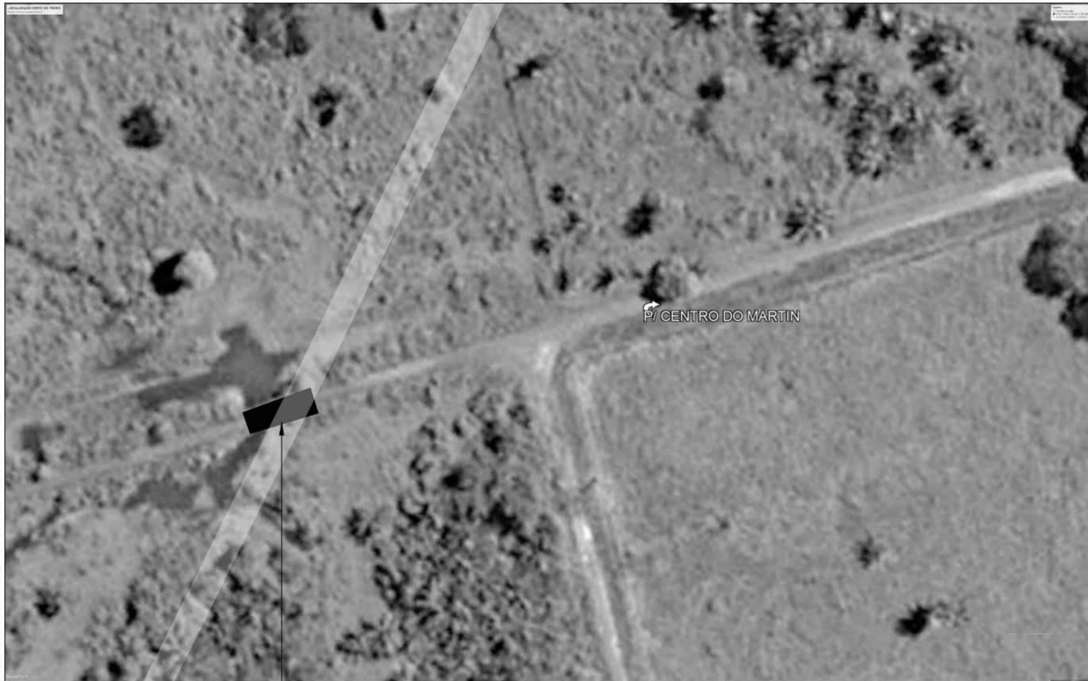
PONTE EXISTENTE A SER DEMOLIDA
