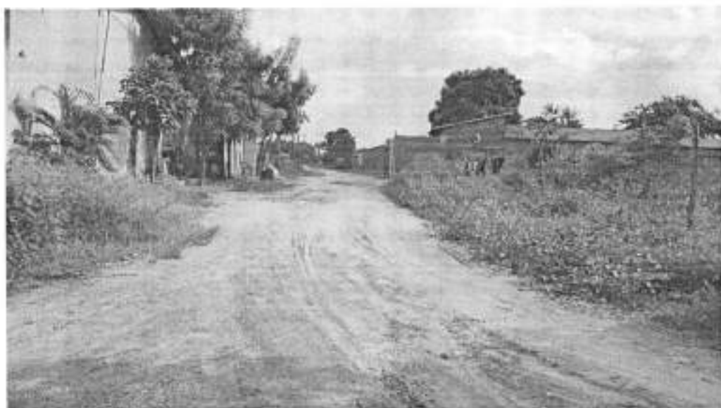
Rua Bom Jesus. Com ponto inicial na estaca P17 e ponto final na estaca P18, com 311 m de comprimento e 6 m de largura.
