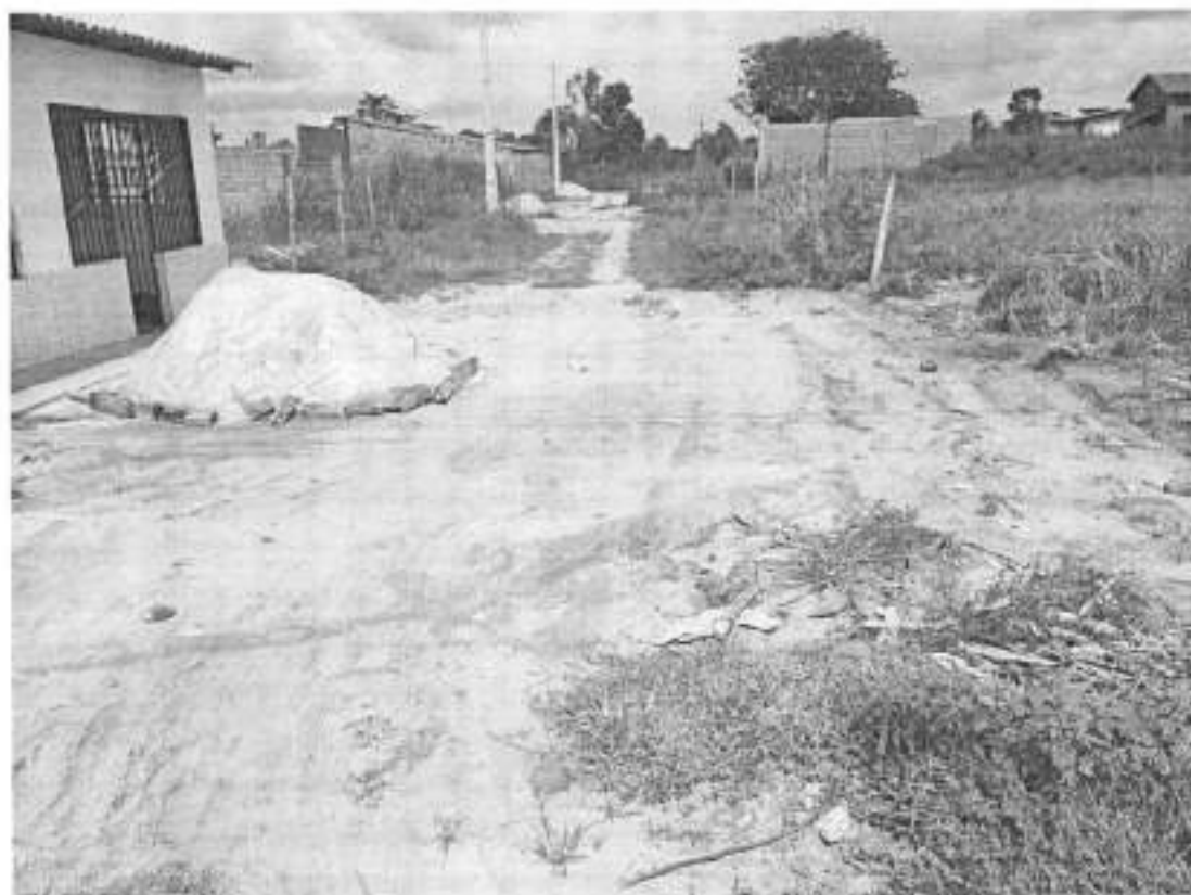
Rua Nazaré. Com ponto inicial na estaca P25 e ponto final na estaca P26, com 73 m de comprimento e 6 m de largura.
