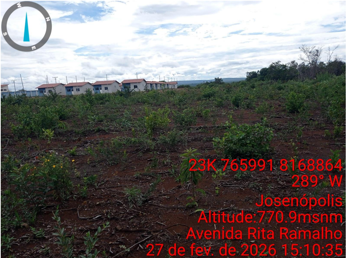
Foto 08- Avenida Rita Ramalho. Local de Intervenção. Fundo das casas populares existentes.
