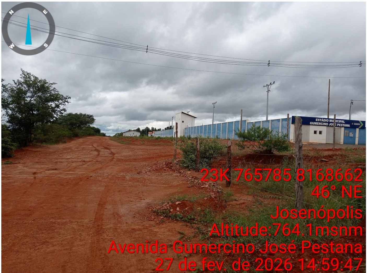
Foto 01- Avenida Gumercino José Pestana, extensão rede elétrica a partir daqui.
