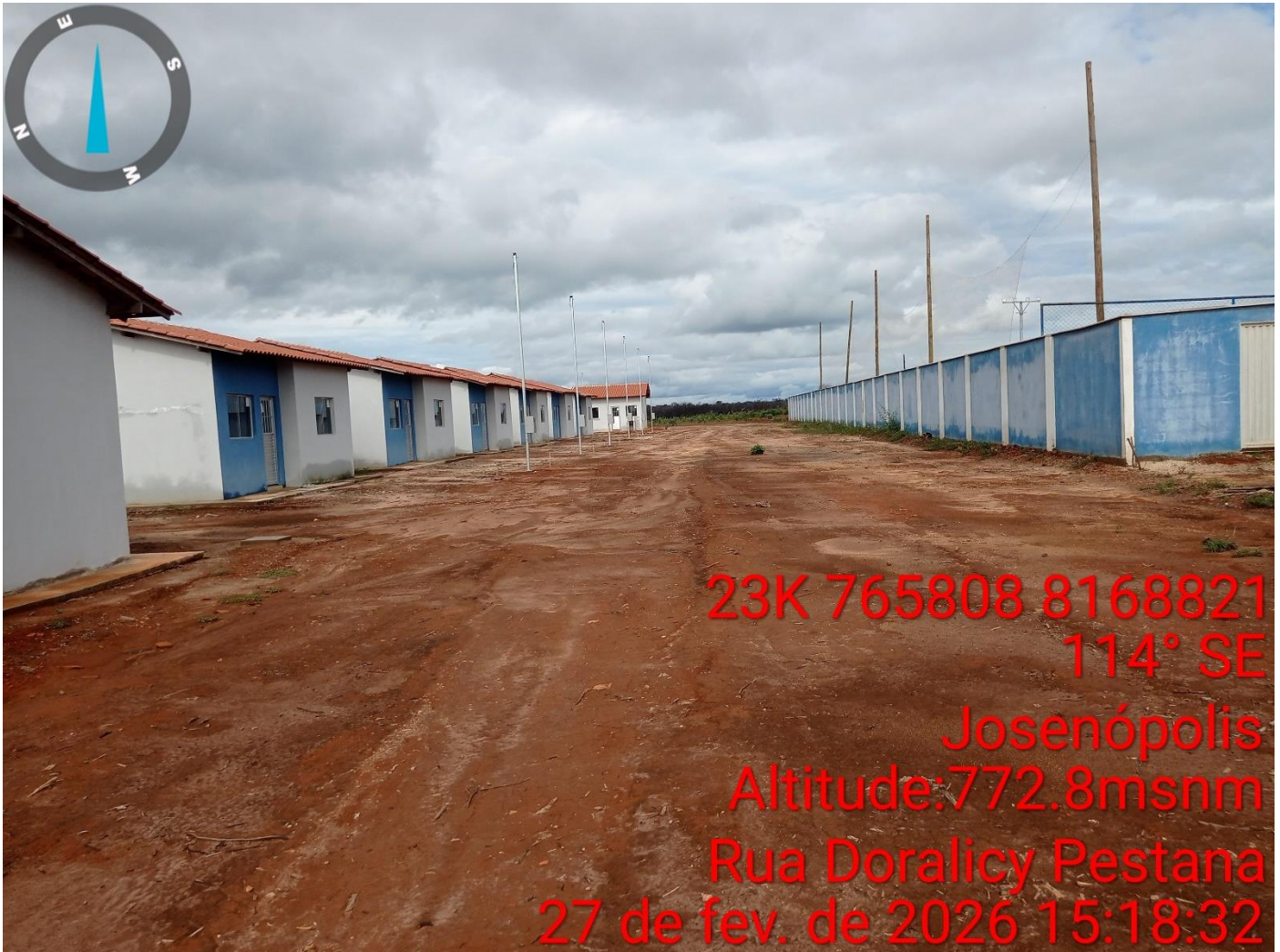
Foto 14- Rua Doralicy Pestana. Vista da Rua Doralicy Pestana entre casas populares existentes e o muro do Estádio Municipal Gumercino José Pestana.
