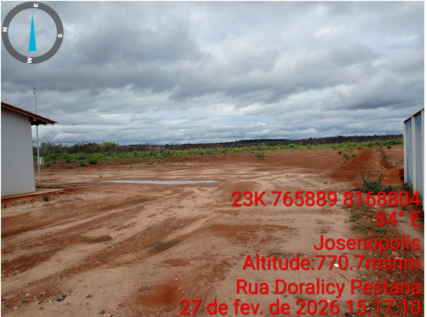
FOTO 13- Vista da Rua Doralicy Pestana, entre o Estádio Municipal Gumercino José Pestana e as casas populares existentes. Local de intervenção no Fundo.
