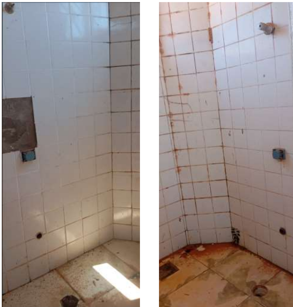
Figura 25 e 26 - Tubulação de água e esgoto executada, registros, válvulas de descarga e caixa sifonada instalados. Fonte: elaboração própria.
