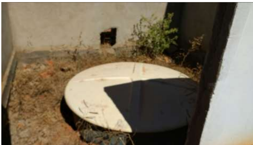
Figura 34 – Reservatório de fibra, com capacidade de 3.000 litros, conforme instalado anteriormente. Fonte: Pasta de acompanhamento da obra.
