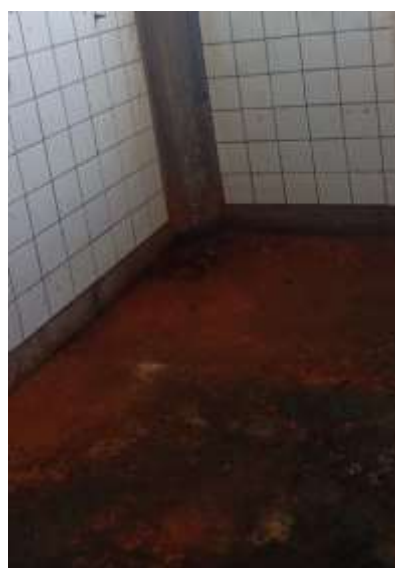
Figura 15 e 16 – Piso cerâmico com espessa camada de sujeira - Fonte: elaboração própria.
