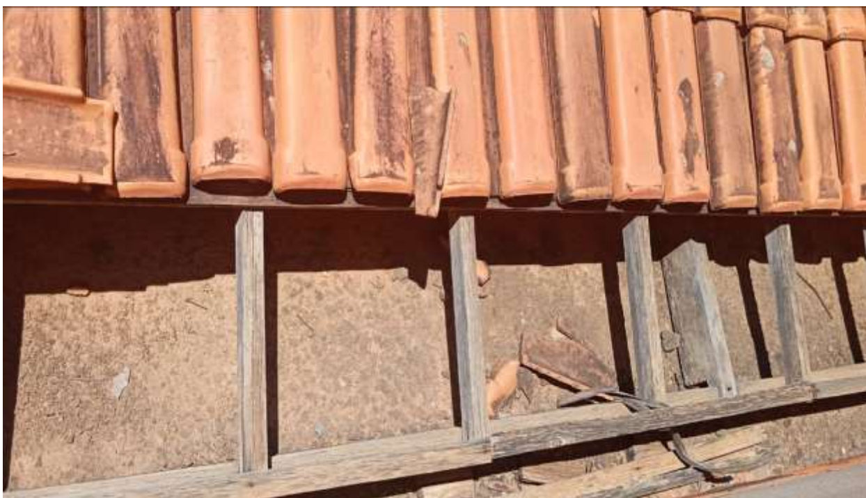
Figura 8 – Peças de madeira retorcidas e apodrecidas. Fonte: elaboração própria.
