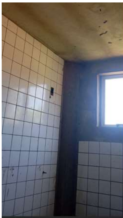
Figura 12 e 13 – Revestimento cerâmico de paredes inacabado – concluir. Fonte: elaboração própria.
