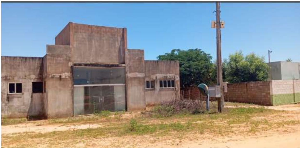
Figura 3 - Vista frontal do terreno mostrando a obra no estágio atual. Fonte: elaboração própria.
