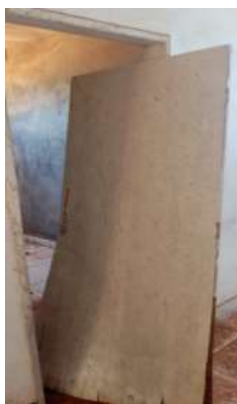
Figura 18 e 19 – Portas de madeira danificadas pela infiltração - Fonte: elaboração própria.
