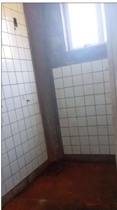
Figura 12 e 13 – Revestimento cerâmico de paredes inacabado – concluir. Fonte: elaboração própria.
