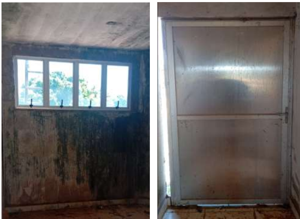
Figura 20 e 21 – Janela e porta metálica instalada e em bom estado de conservação - Fonte: elaboração própria.
