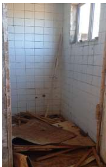
Figura 18 e 19 – Portas de madeira danificadas pela infiltração - Fonte: elaboração própria.
