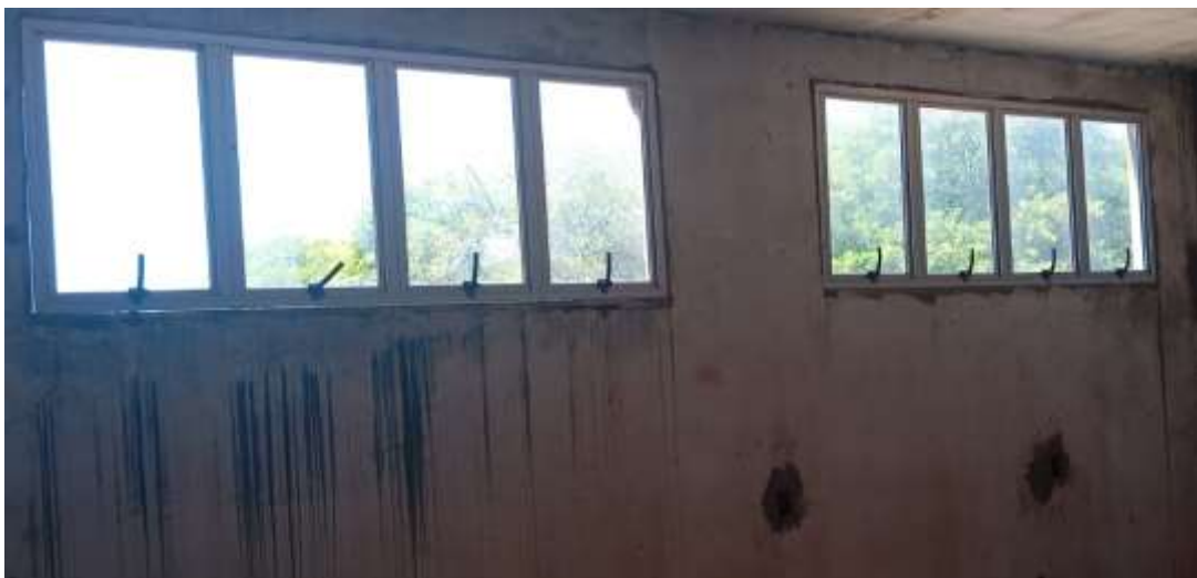
Figura 23 – Janela metálica instalada com vidro em bom estado de conservação - Fonte: elaboração própria.
