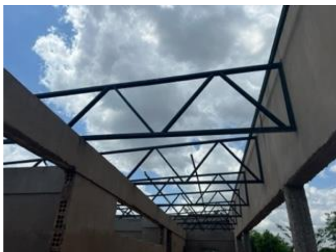
FOTO 11 - ESTRUTURA METÁLICA PARCIALMENTE COLOCADA
