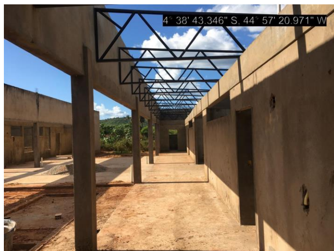
FOTO 12 - ESTRUTURA METÁLICA PARCIALMENTE COLOCADA – 26/06/2024
