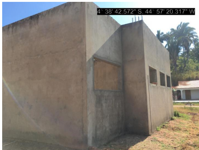
FOTO 8 - FACHADA LATERAL ESQUERDA – 26/06/2024
