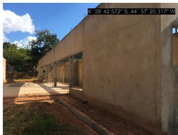
FOTO 24 - VISTA INTERNA PÁTIO - 26/06/2024
