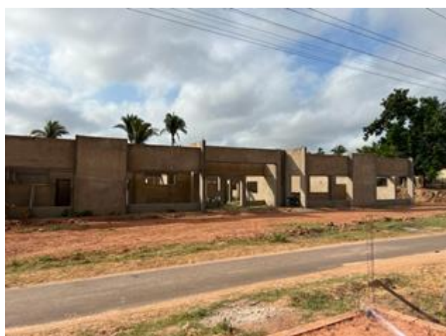
FOTO 5 - VISTA FRONTAL PRINCIPAL
