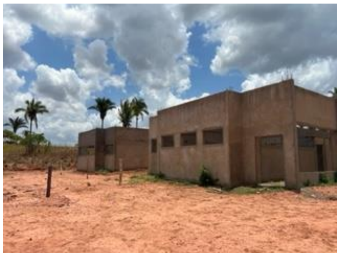
FOTO 7 - FACHADA LATERAL ESQUERDA
