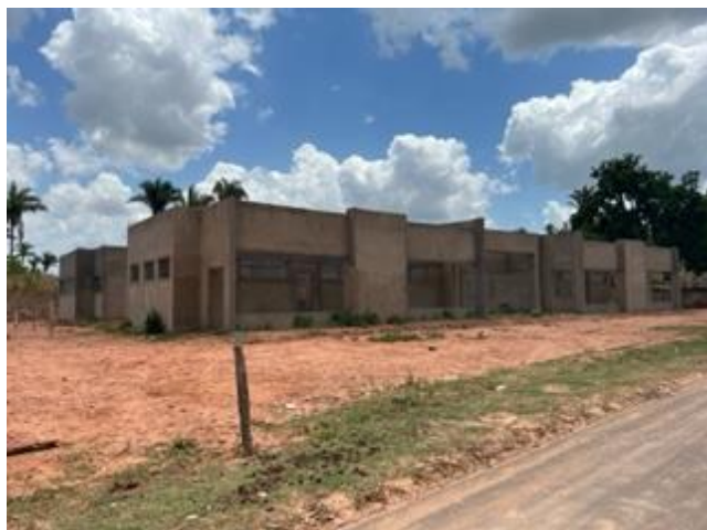
FOTO 1 - FACHADA FRONTAL DA OBRA
