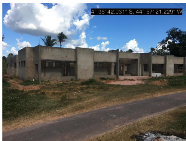
FOTO 2 - FACHADA FRONTAL DA OBRA – 26/06/2024
