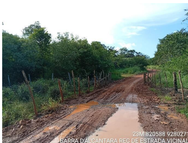
Foto Nº 04 - Trecho de execução da obra Coordenadas geográficas: 6°30'10.87"S 42° 6'5.89"O
