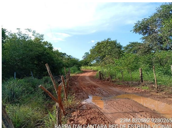
Foto Nº 05 - Trecho de execução da obra Coordenadas geográficas: 6°30'11.07"S 42° 6'5.76"O
