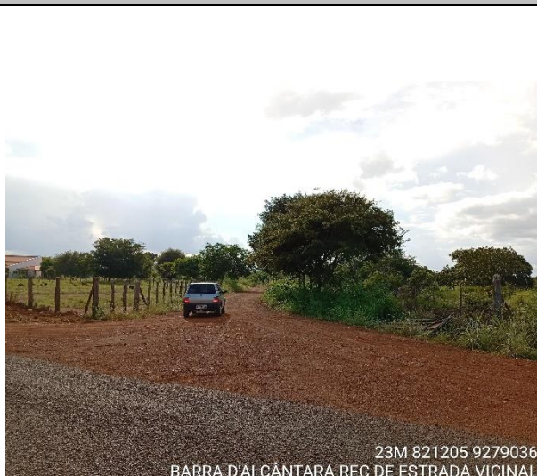
Foto Nº 01 – Início do trecho de execução da obra Coordenadas geográficas: 6°30'50.93"S 42° 5'45.60"O
