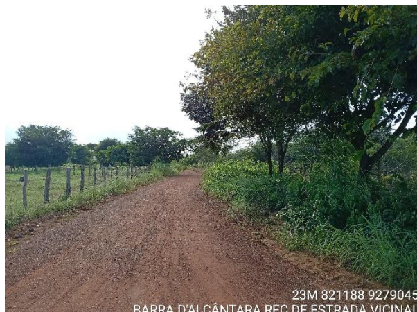
Foto Nº 02 - Trecho de execução da obra Coordenadas geográficas: 6°30'50.64"S 42° 5'46.15"O
