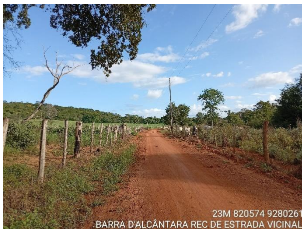
Foto Nº 03 - Trecho de execução da obra Coordenadas geográficas: 6°30'11.20"S 42° 6'6.35"O
