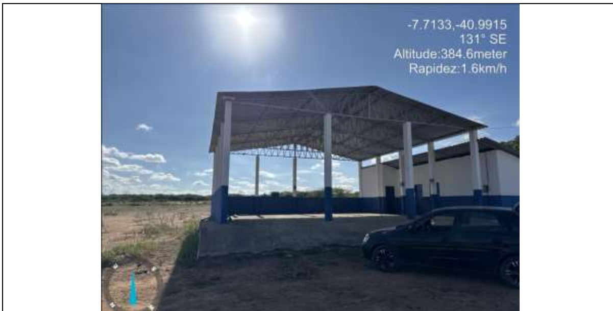
Foto 7.1 – Vista do Galpão – Aterro Sanitário
