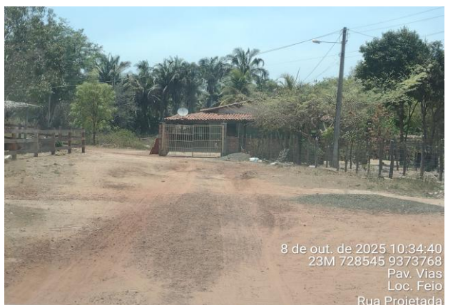
FOTO Nº 12 - RUA PROJETADA - TRECHO 2
