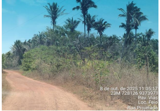
FOTO Nº 02 - RUA PROJETADA - TRECHO 2
