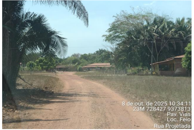
FOTO Nº 08- RUA PROJETADA - TRECHO 2
