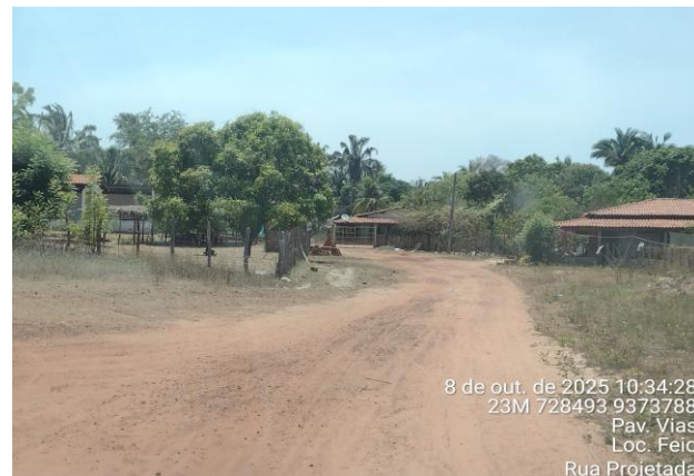
FOTO Nº 11 - RUA PROJETADA - TRECHO 2
