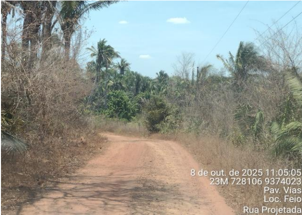
FOTO Nº 01 - RUA PROJETADA - TRECHO 2
