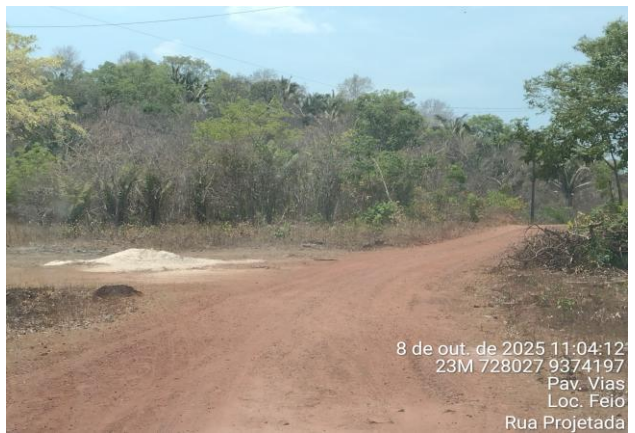
FOTO Nº 14- RUA PROJETADA - TRECHO 1
