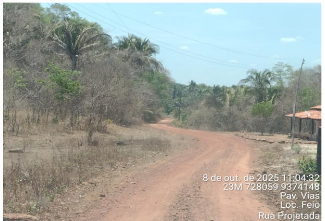
FOTO Nº 16 - RUA PROJETADA - TRECHO 1
