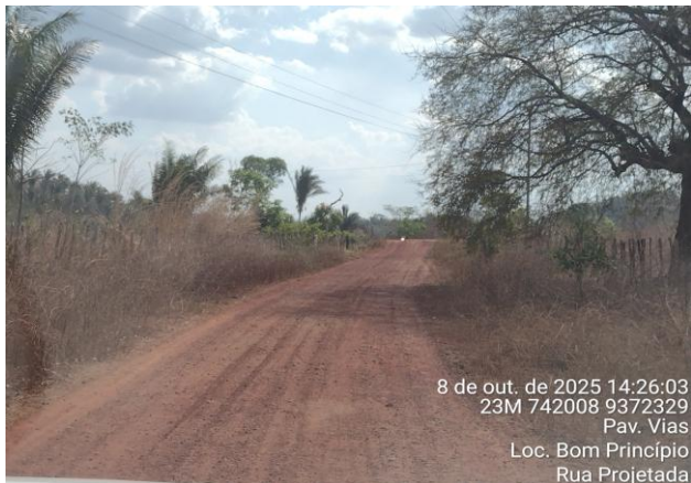
FOTO Nº 03- RUA PROJETADA - TRECHO 3
