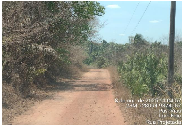
FOTO Nº 18 - RUA PROJETADA - TRECHO 1
