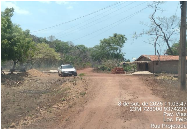
FOTO Nº 13- RUA PROJETADA - TRECHO 1
