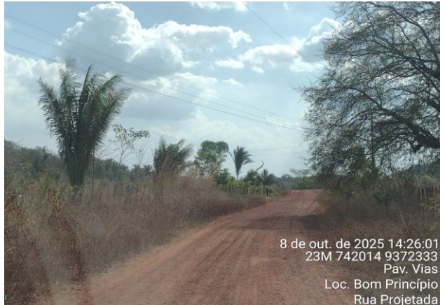
FOTO Nº 02- RUA PROJETADA - TRECHO 3
