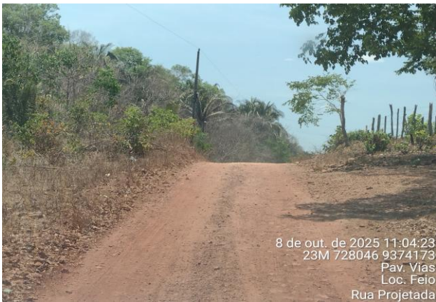
FOTO Nº 15- RUA PROJETADA - TRECHO 1
