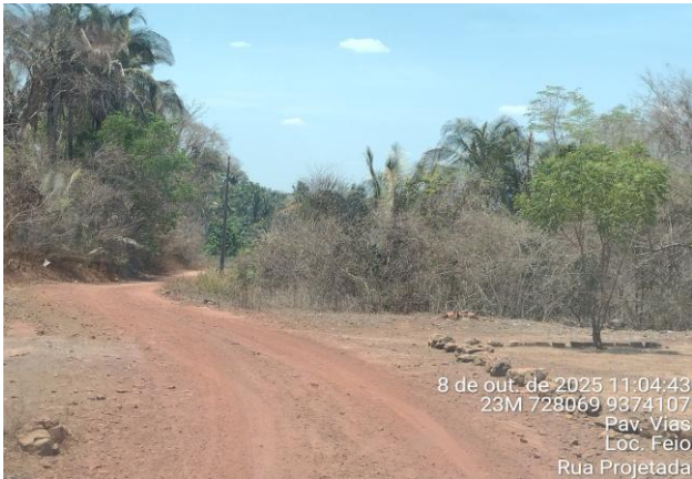
FOTO Nº 17 - RUA PROJETADA - TRECHO 1
