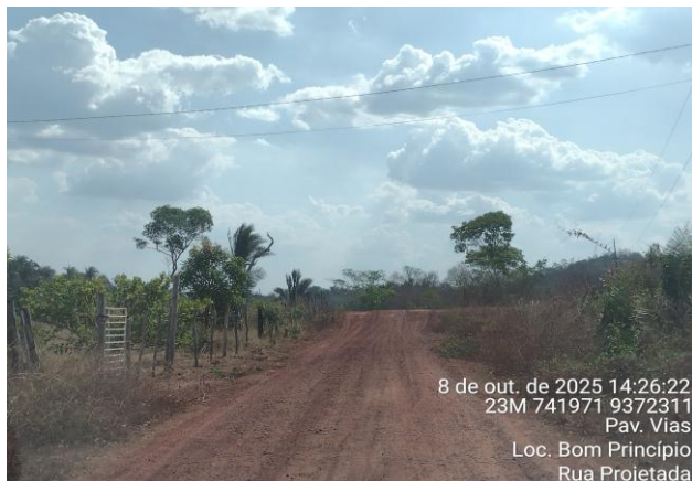
FOTO Nº 05 - RUA PROJETADA - TRECHO 3
