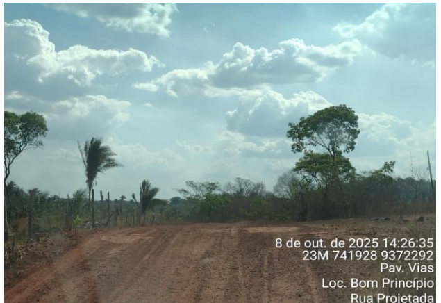
FOTO Nº 06 - RUA PROJETADA - TRECHO 3
