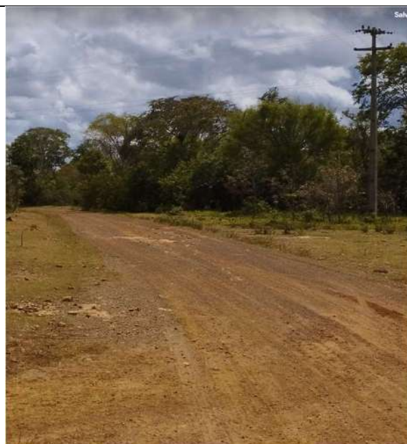
Foto 02 - TRECHO DA ESTRADA 01
