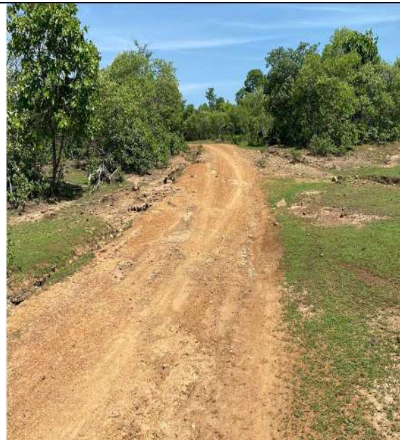
Foto 06 - TRECHO DA ESTRADA 02
