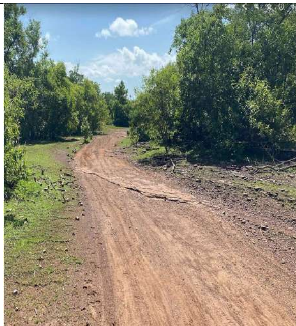
Foto 07 - TRECHO DA ESTRADA 02
