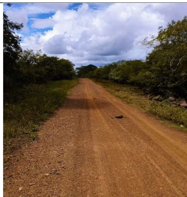
Foto 01 - INÍCIO DO TRECHO 01
