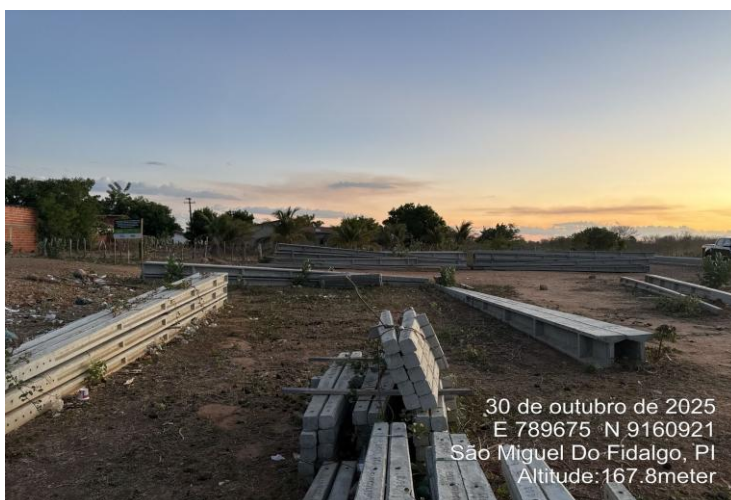
FOTO 05: CONSTRUÇÃO DE PRAÇA
