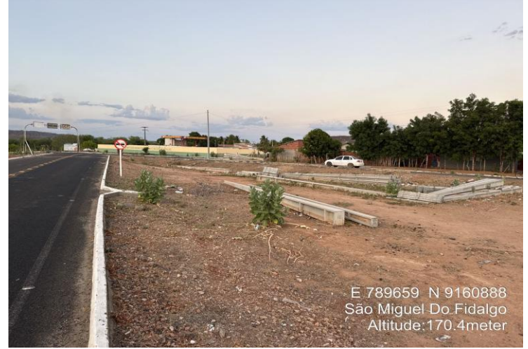
FOTO 02: CONSTRUÇÃO DE PRAÇA
