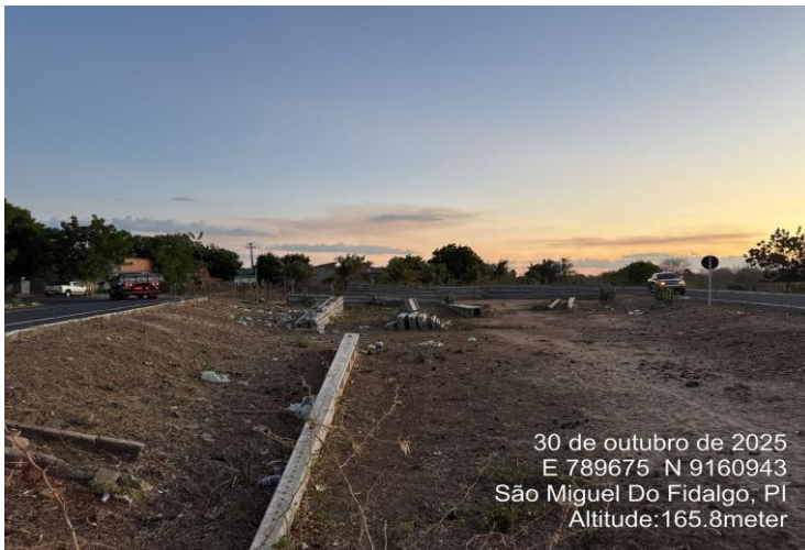
FOTO 03: CONSTRUÇÃO DE PRAÇA
