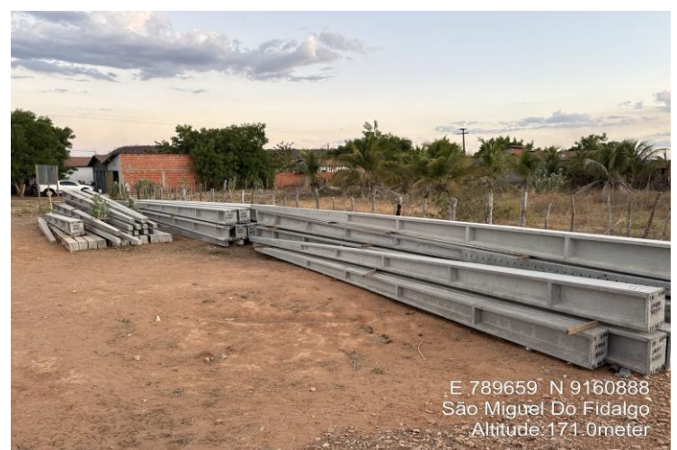
FOTO 06: CONSTRUÇÃO DE PRAÇA
