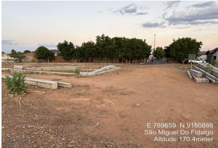
FOTO 01: CONSTRUÇÃO DE PRAÇA
