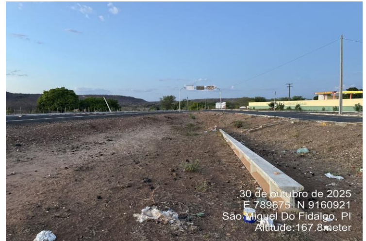
FOTO 04: CONSTRUÇÃO DE PRAÇA
