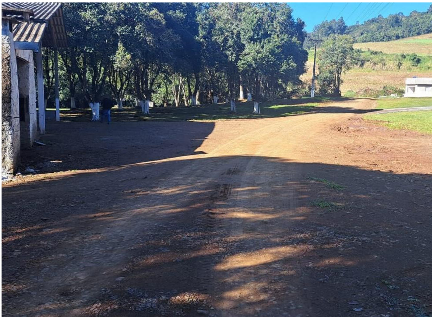
Figura 08 – Trecho da estrada EMS-206 a ser pavimentado (região da Estaca E7-E8 – 26^{\circ}37'50.0''S 52^{\circ}42'12.0''W – imagem com sentido à Sede do Município).
