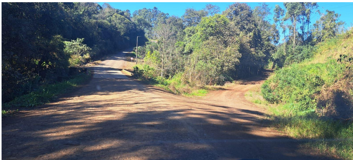
Figura 01 – Ligação da estrada a receber a pavimentação asfáltica com via pavimentada com pedras irregulares (região da estaca E65-E66 – 26^{\circ}38'13.0''S 52^{\circ}41'29.6''W – imagem com sentido à Sede do Município).
