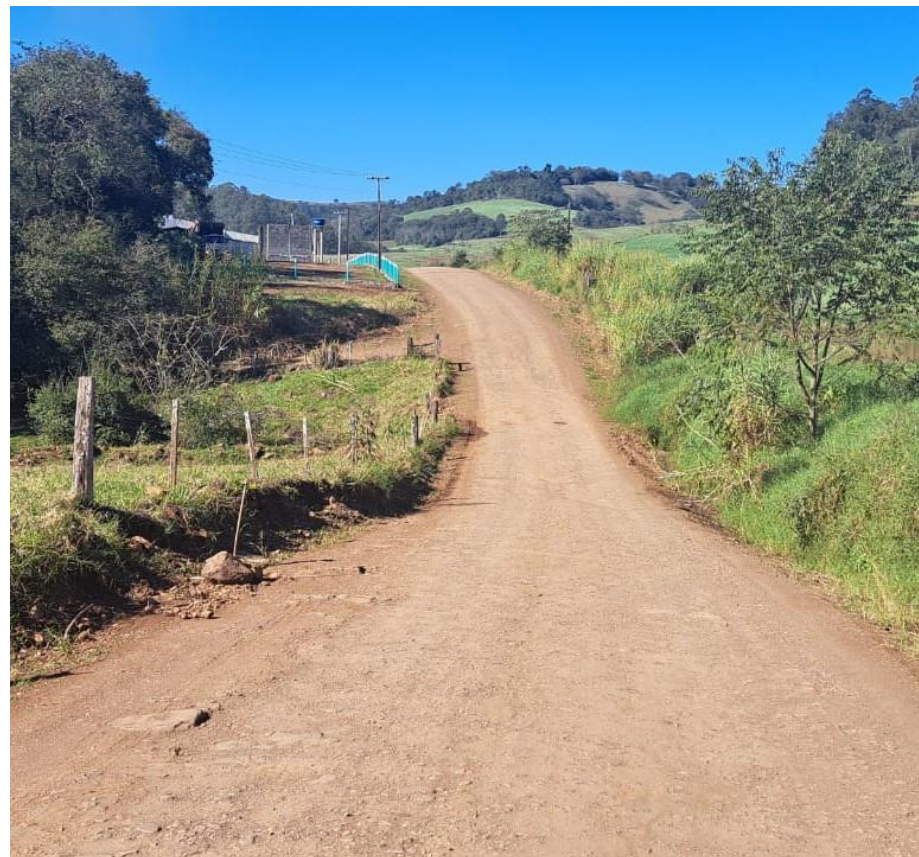
Figura 05 – Trecho da estrada EMS-020 a ser pavimentado (região da Estaca E33-E34 – 26°38'02.9"S 52°41'49.0"W – imagem com sentido à Sede do Município).
