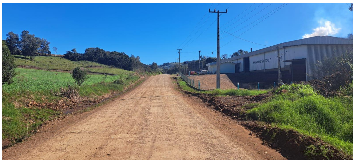
Figura 03 – Trecho da estrada EMS-020 a ser pavimentado (região da Estaca E50 – 26^{\circ}38'09.7''S 52^{\circ}41'39.5''W ).
