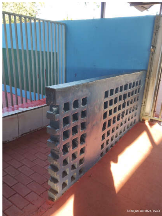
Figura 3 - Cobogó a ser demolido
