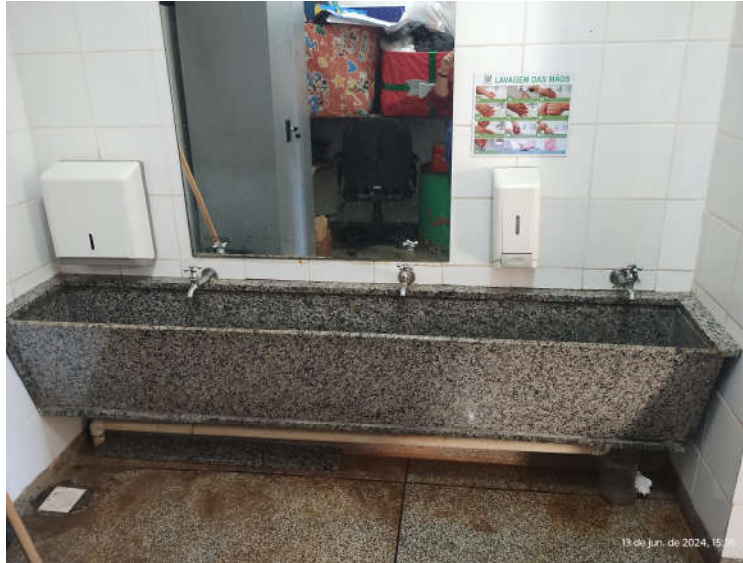
Figura 6 – Lavatório e acessórios a serem removidos
