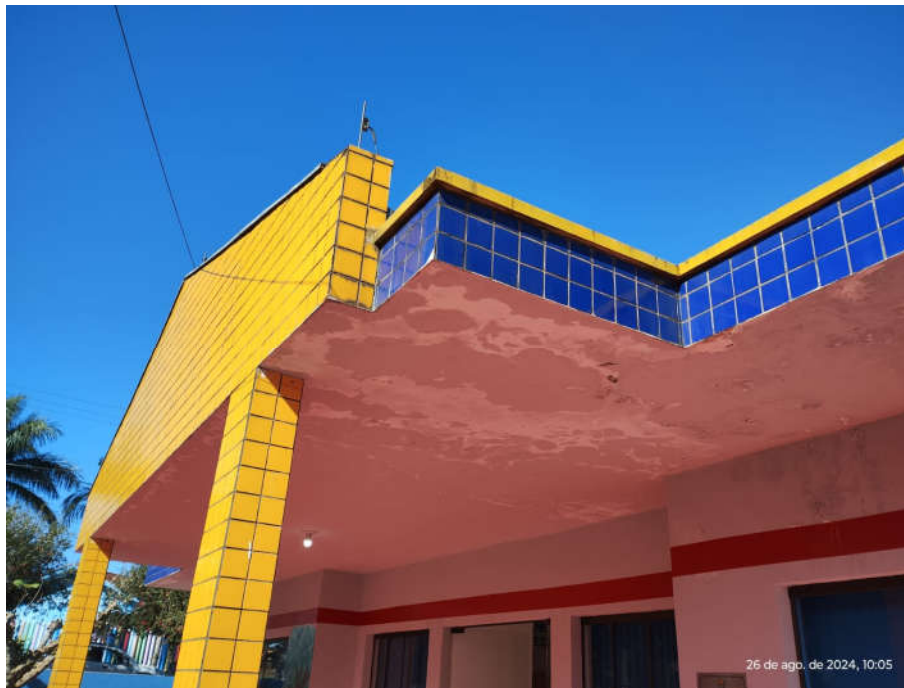
Figura 10 - Teto em área externa
