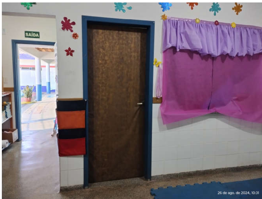
Figura 1 - Paredes a demolir
