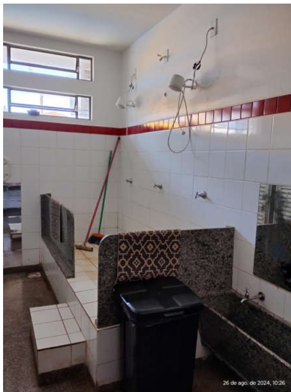
Figura 4 - Elevação dos chuveiros a demolir
