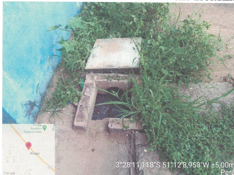
FOTO 6: VISTA DO ESGOTO DA COZINHA SEM ESCOAMENTO
