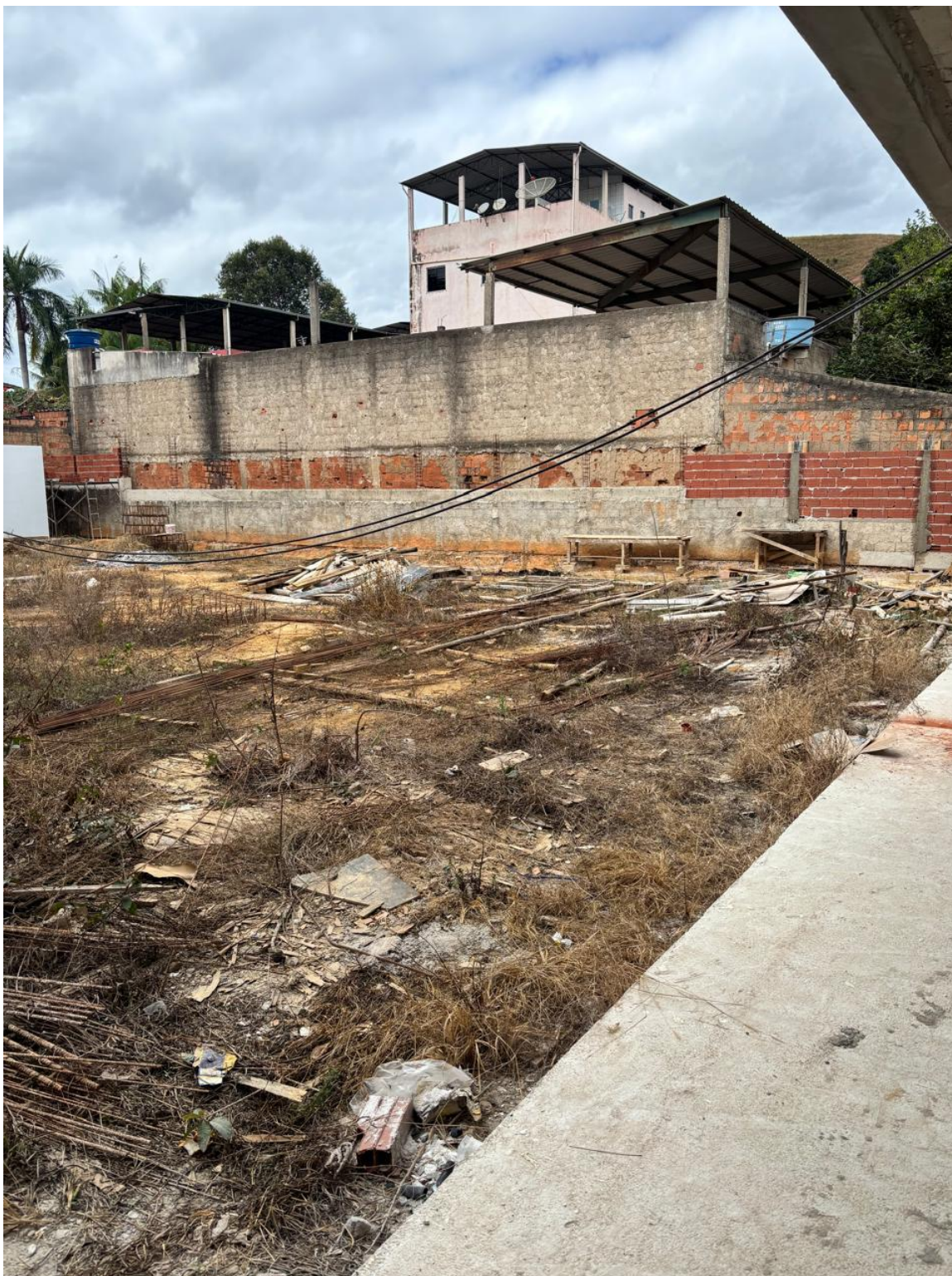
Foto 03 – Vista geral da área descoberta a ser implantada a obra.
