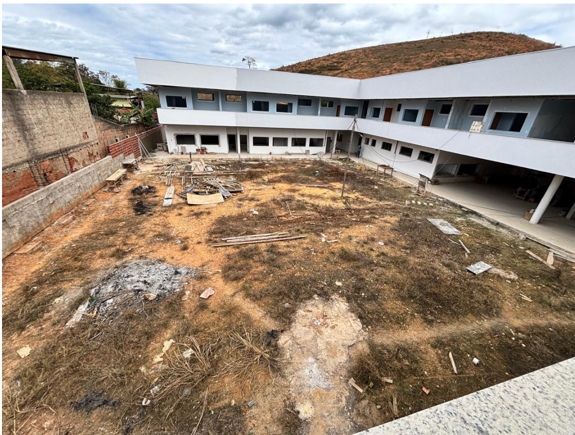
Foto 01 – Vista geral da área descoberta a ser implantada a obra.
