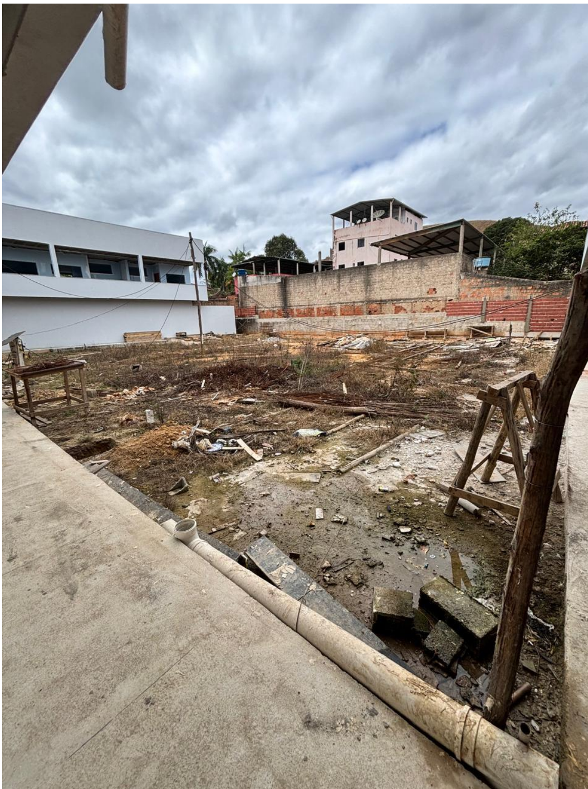
Foto 02 – Vista geral da área descoberta a ser implantada a obra.
