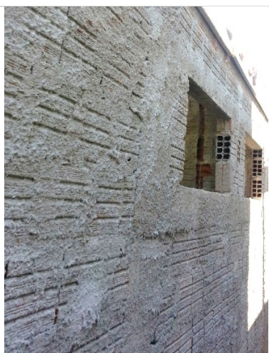
Imagem 06: Chapisco em alvenaria de vedação
