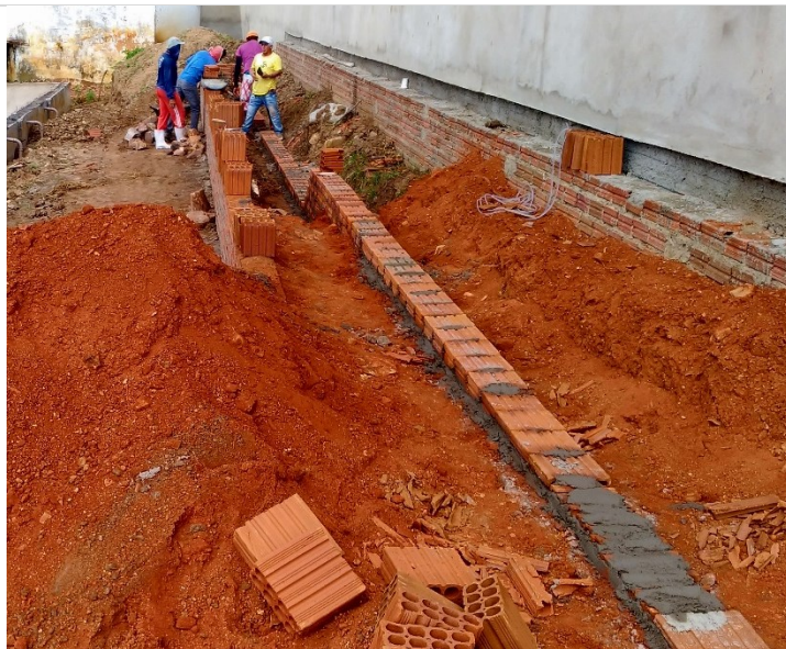
Imagem 04 : Alvenaria de ambasamento de tijolo cerâmico
