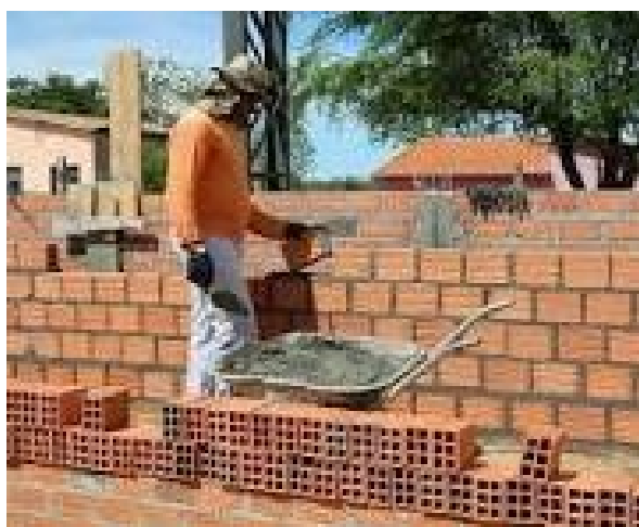
Imagem 04: Execução alvenaria de elevação
