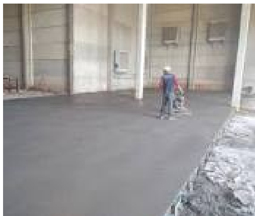
Imagem 07: Execução piso industrial de concreto armado
