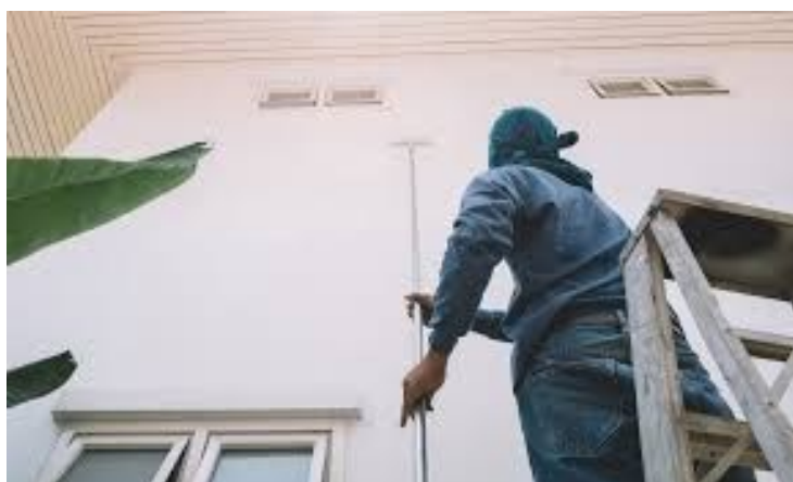
Imagem 16:Aplicação de pintura acrílica
