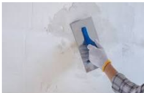
Imagem 14: Aplicação de massa acrílica
