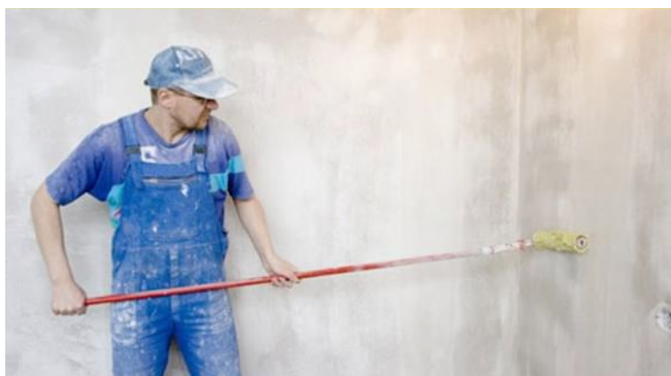
Imagem 15: Aplicação de fundo selador acrílico
