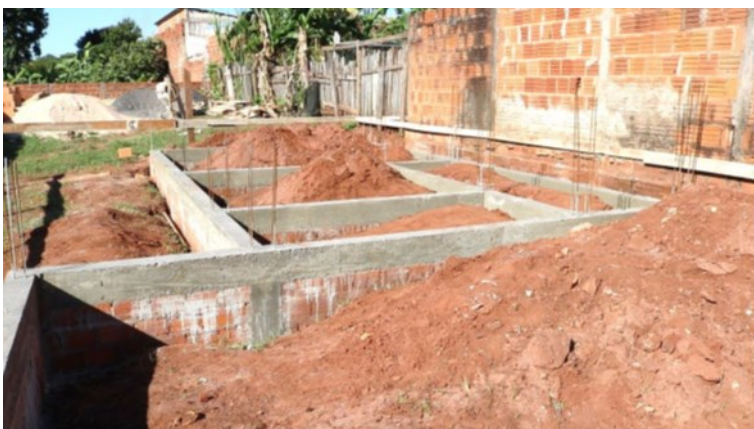
Imagem 03: Execução de fundação - vigas baldrame apoiadas em alvenaria de embasamento.
