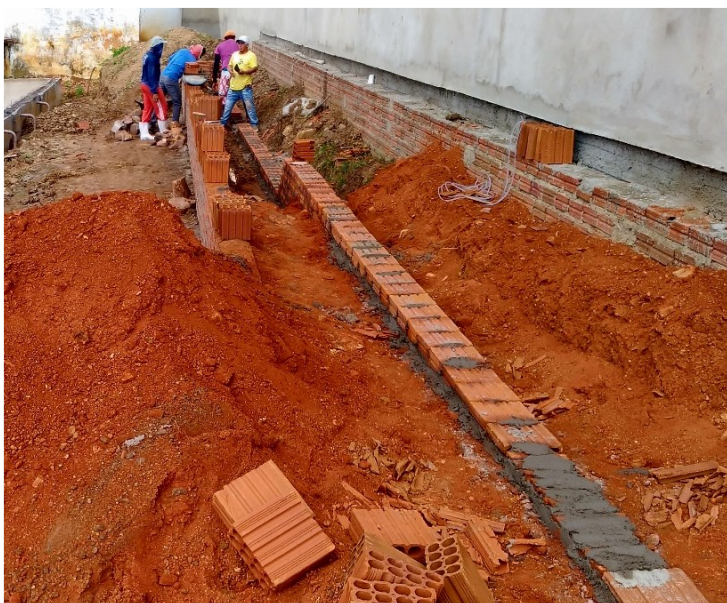
Imagem 02: Execução de fundação - alvenaria de embasamento
