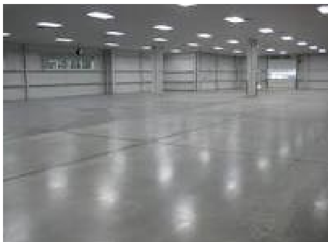
Imagem 08: Piso industrial de concreto armado finalizado
