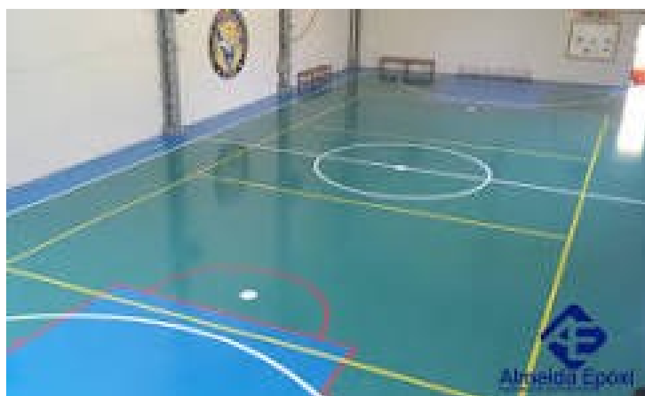
Imagem 17: Pintura epóxi em piso de quadra
