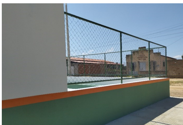
Imagem 10: Alambrado com tela de aço 5x5cm
