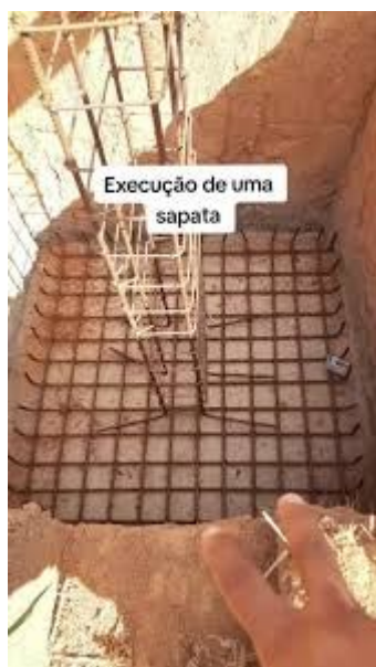
Imagem 01:Execução de fundação das sapatas
