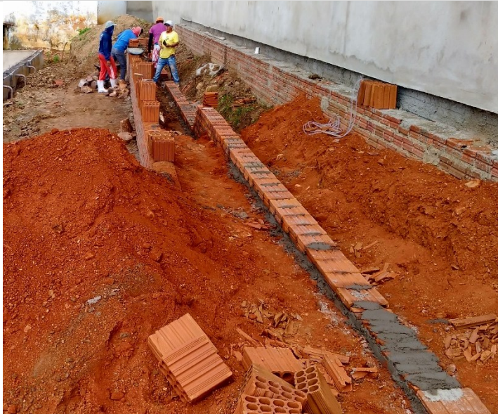
Imagem 04 : Alvenaria de ambasamento de tijolo cerâmico
