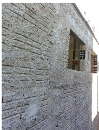
Imagem 06: Chapisco em alvenaria de vedação
