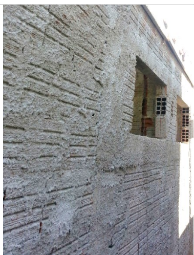
Imagem 06: Chapisco em alvenaria de vedação
