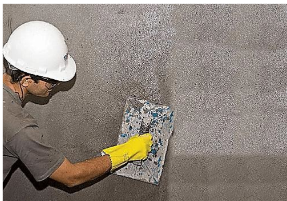
Imagem 05: emboço sobre alvenaria de vedação
