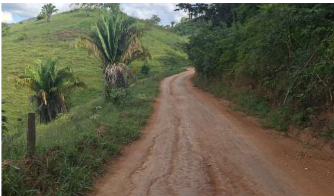
Figura 10 – Fotografia Estrada Acesso ao Córrego Barreiro – Trecho 02 (17° 56'24,12"S 42°2'42.25"O)
