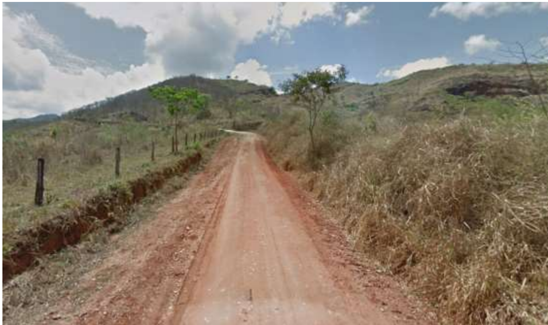
Figura 05 – Fotografia Estrada Acesso ao Córrego Santa Rosa – Trecho 01 (18° 0'15.27"S 41°51'8.30"O)
