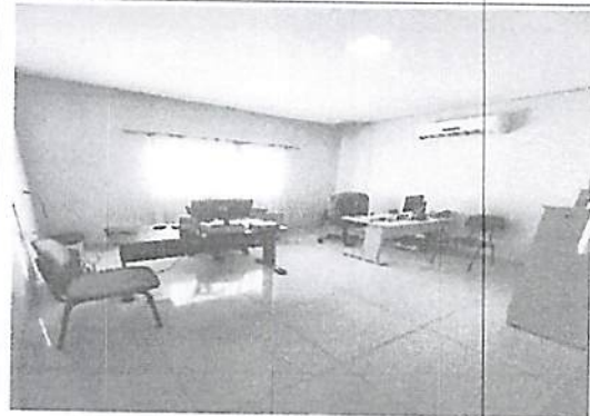
Acabamento em gesso e porcelanato.
