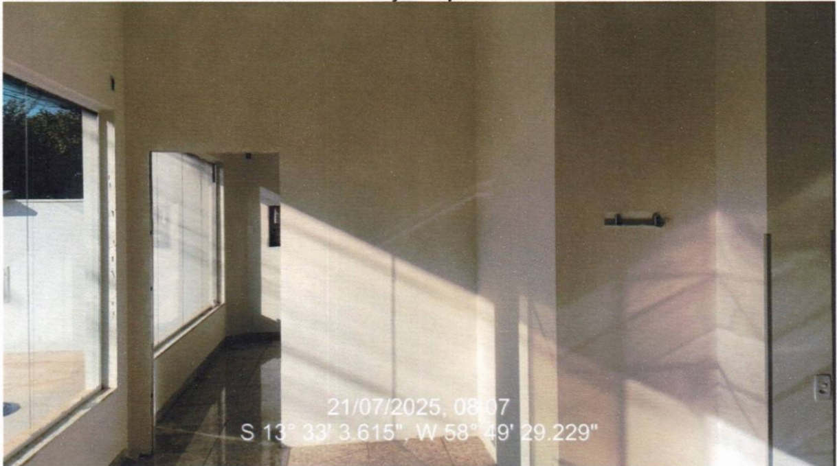
Foto 03 – Recepção – Vista Geral – Detalhe para abertura de vão que irá receber esquadria após a finalização da pintura
