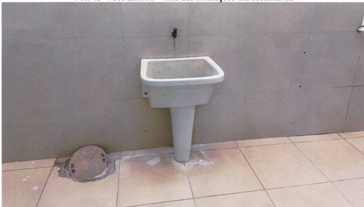
Foto 12 – Área Externa – Vista das instalações hidrossanitárias
