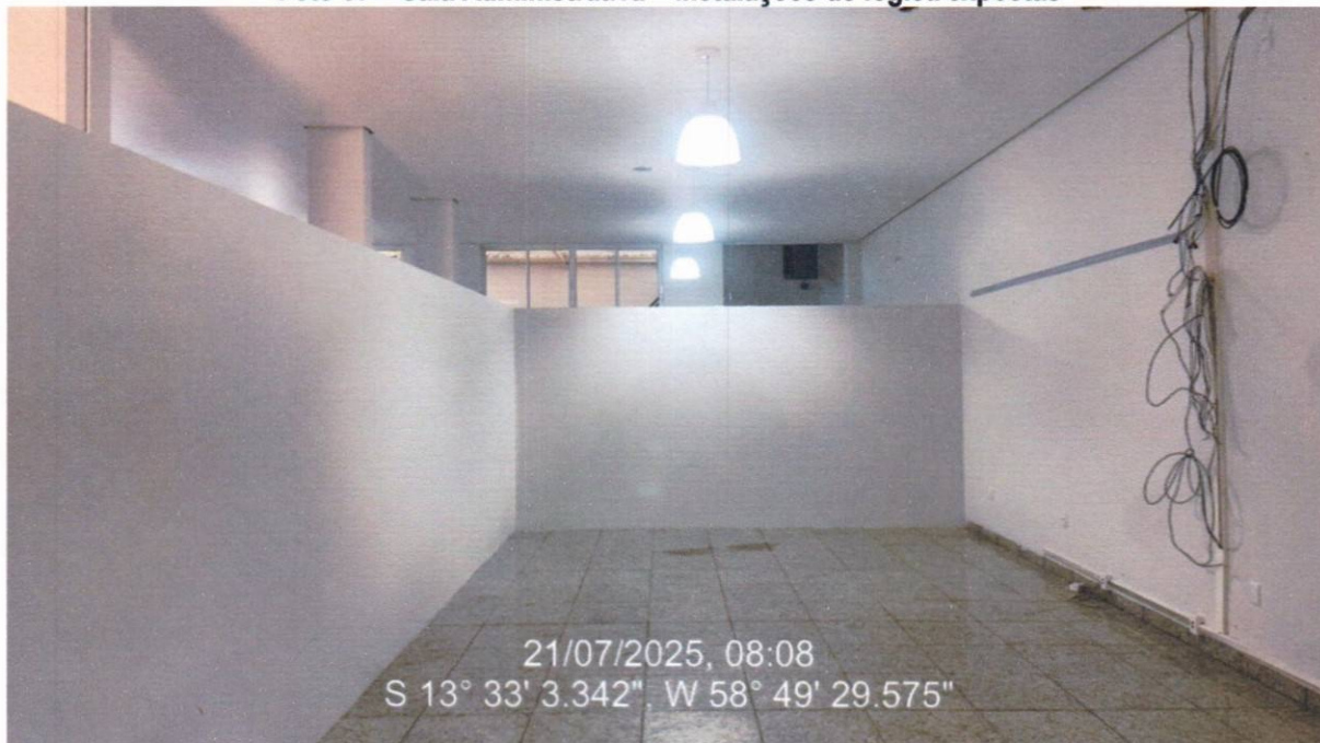
Foto 07 – Sala Administrativa – Instalações de lógica expostas
