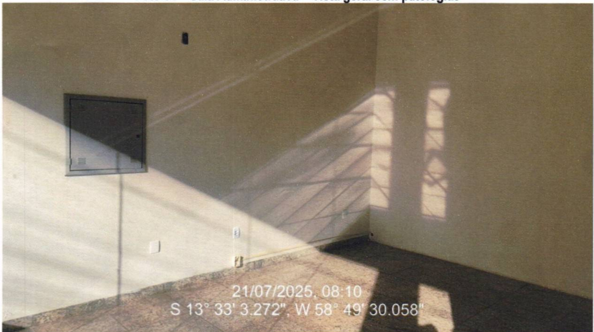
Foto 04 – Sala Administrativa – Vista geral sem patologias
