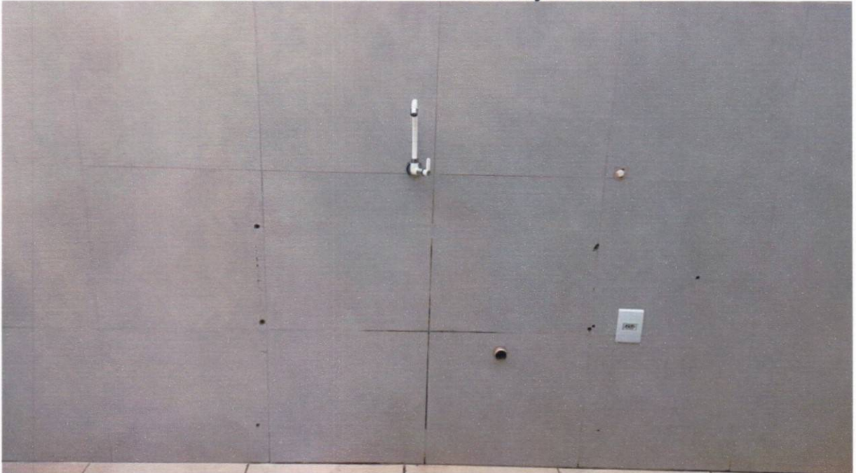
Foto 13 – Área Externa – Vista das instalações sanitárias
