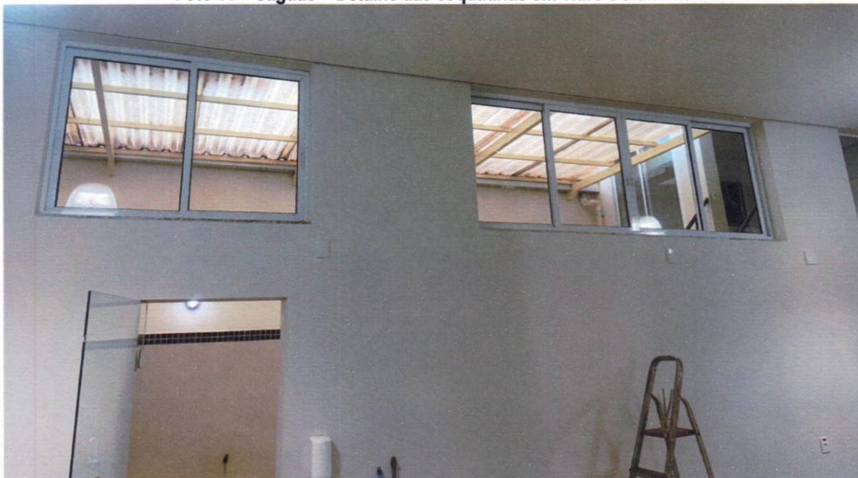
Foto 11 – Saguão – Detalhe das esquadrias em vidro e alumínio
