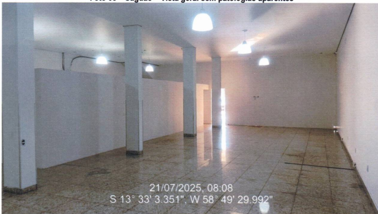
Foto 08 – Saguão – Vista geral sem patologias aparentes
