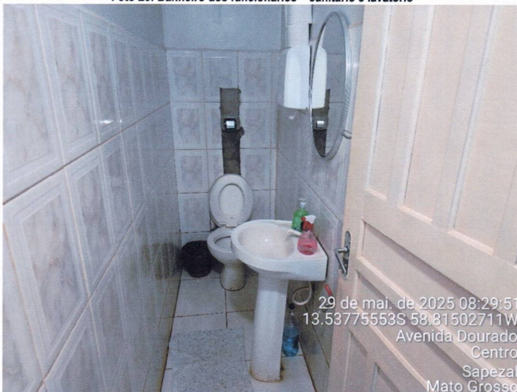
Foto 26: Banheiro dos funcionários – sanitário e lavatório
