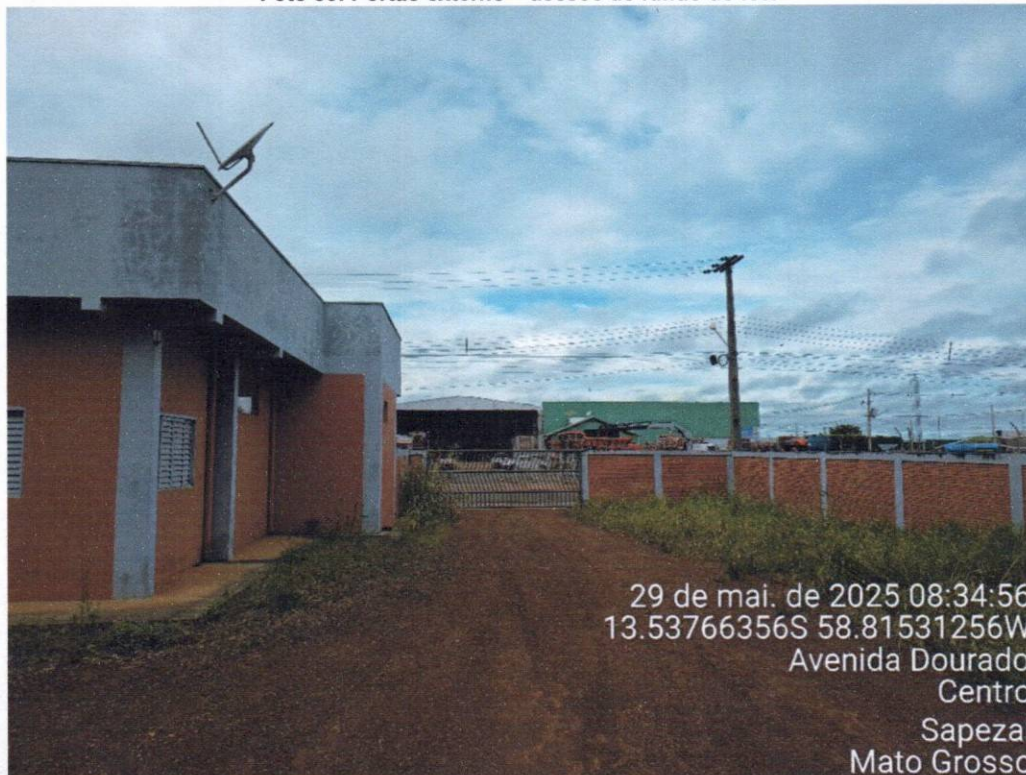
Foto 33: Portão externo – acesso ao fundo do lote
