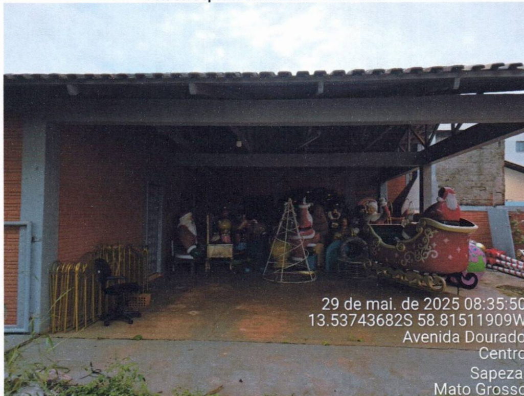
Foto 35: Depósito desanexado – vista frontal
