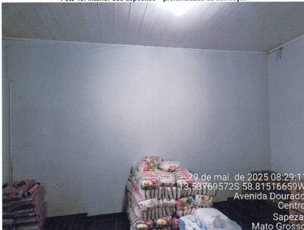
Foto 19: Interior dos depósitos – profundidade da edificação
