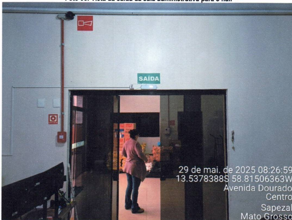
Foto 06: Vista da saída da sala administrativa para o hall
