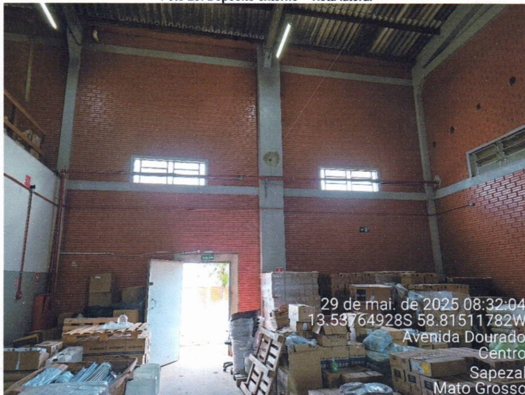
Foto 28: Depósito externo – vista lateral
