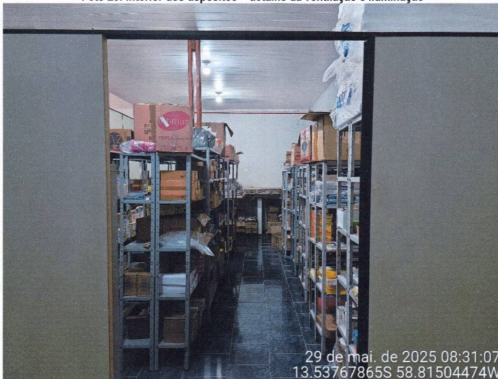
Foto 23: Interior dos depósitos – detalhe da ventilação e iluminação
