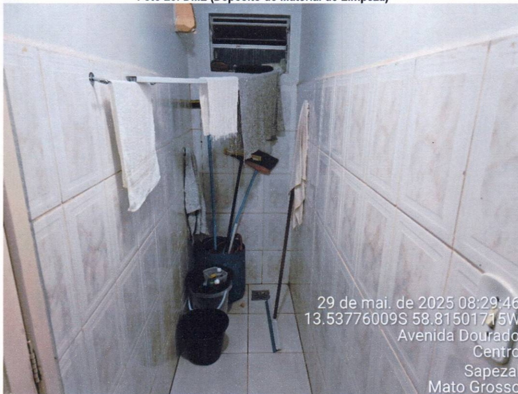
Foto 25: DML (Depósito de Material de Limpeza)
