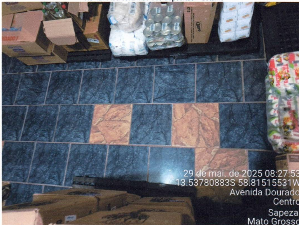
Foto 12: Piso cerâmico dos depósitos – detalhe
