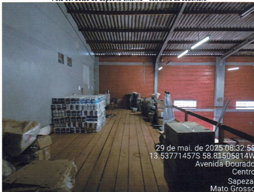
Foto 30: Sótão do depósito externo – estrutura da cobertura
