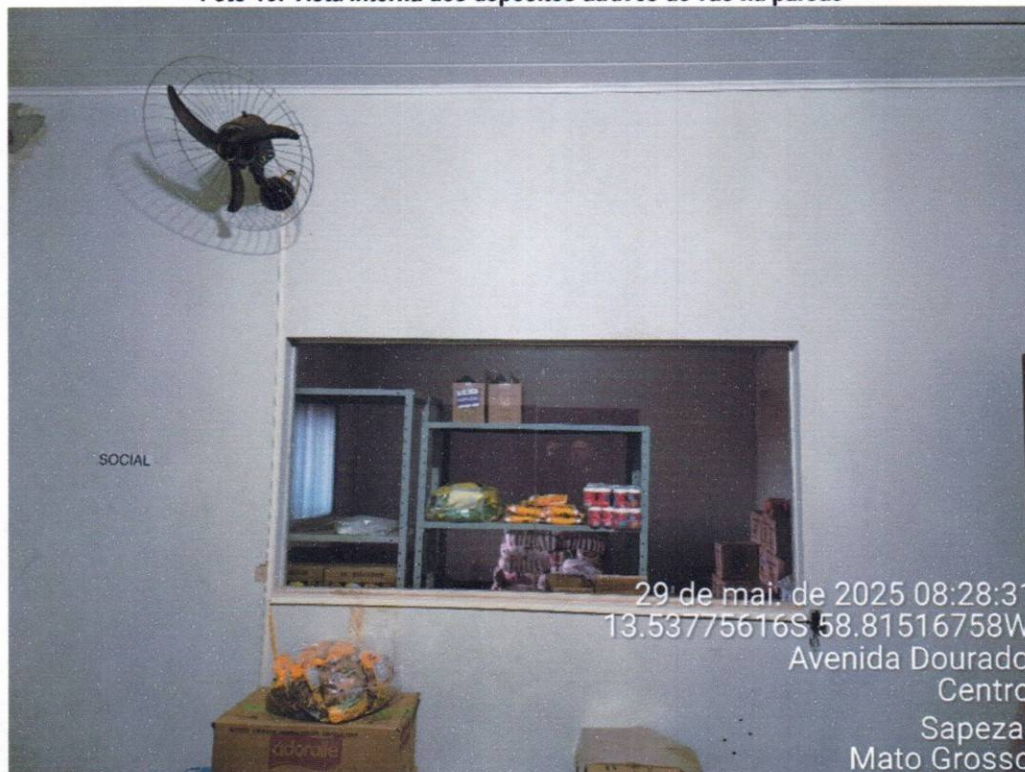
Foto 16: Vista interna dos depósitos através de vão na parede
