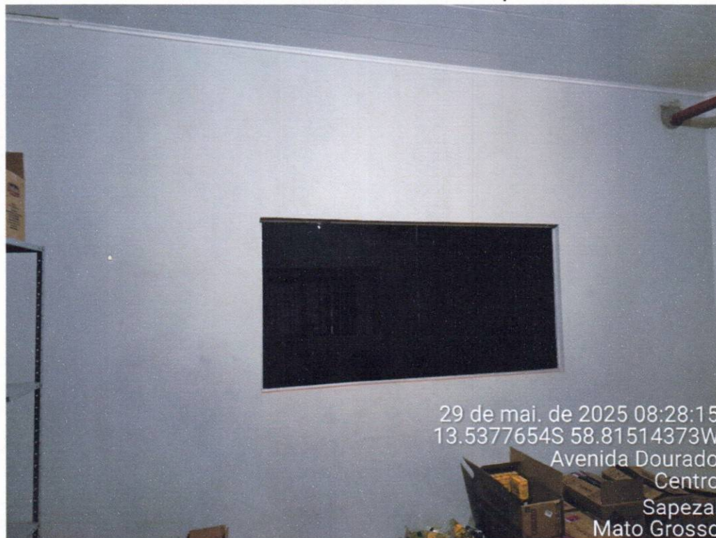
Foto 14: Pintura interna em bom estado – depósito
